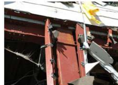
写真3 建物の柱梁部材
