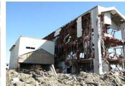
写真4 隣接するRC建物
