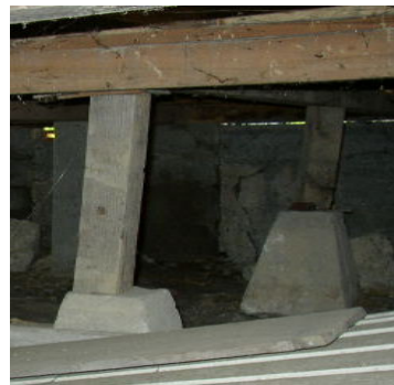
(c)床下の高い支柱・束（ろうそく基礎と呼ぶこともある） (d)無筋コンクリート
