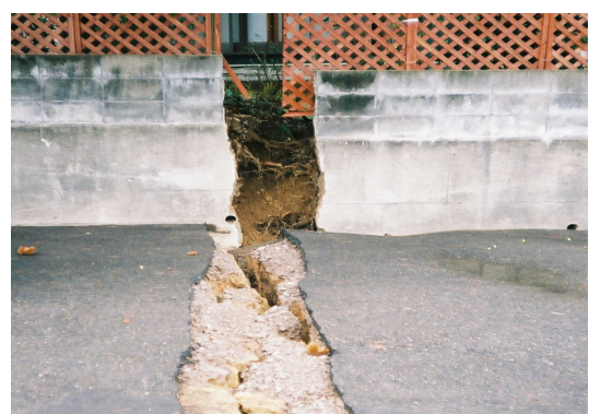
写真7.3 宅地地盤の被害(地すべり、崖くずれ、地割れなどのによる被害)
