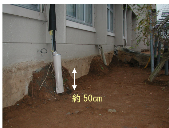
写真 7.10 校舎周辺の地盤の移動
