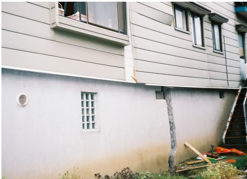
写真 7.32 戸建住宅の基礎の被害(高床式の鉄筋コンクリート造の被害) (地すべりが発生して著しい地盤変位が生じた地域で見られた例)
