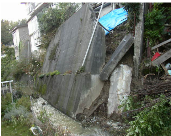
写真 7.26 宅地擁壁の被害
