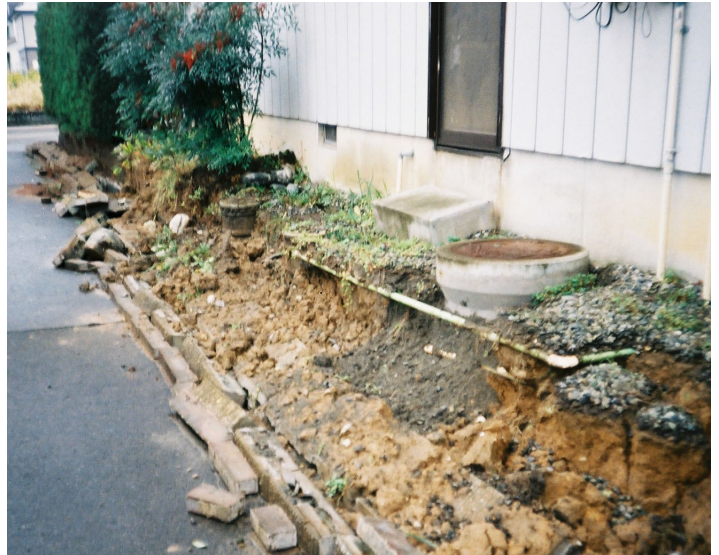
写真 7.30 低い外構ブロックの転倒例
