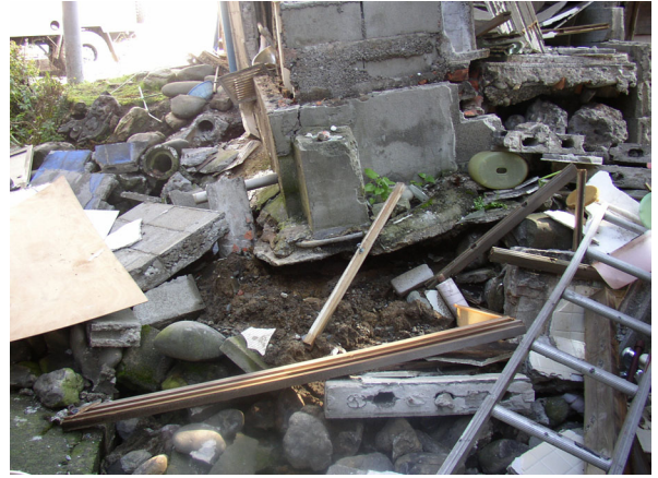
写真 7.29 宅地における低盛土(50-70cm)が崩壊することによる住宅の不同沈下や崩壊
