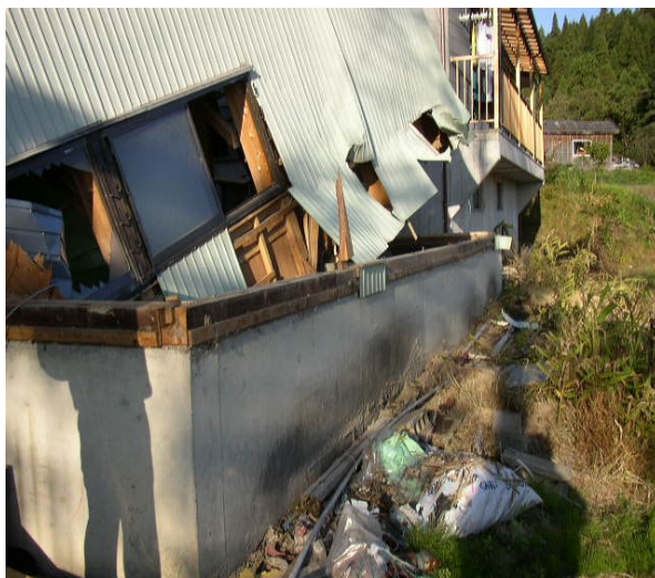
写真 7.33 戸建住宅の基礎と上部構造の被害 (基礎は無被害であるが上部構造が崩壊した例。基礎は鉄筋コンクリート造であることが多い)
