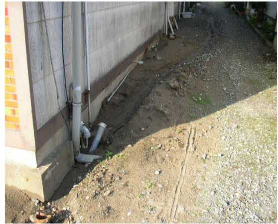
写真 7.25 液状化による被害(刈羽村)
