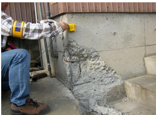
写真 7.34 戸建住宅の基礎の被害
