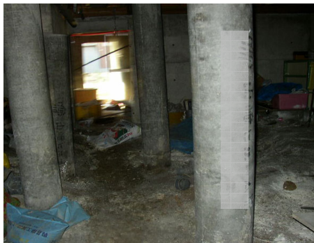
(c)床下の高い支柱・束（ろうそく基礎と呼ぶこともある） (d)無筋コンクリート
