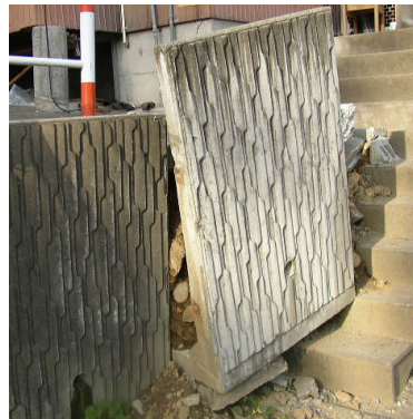
写真 7.27 宅地擁壁の被害
