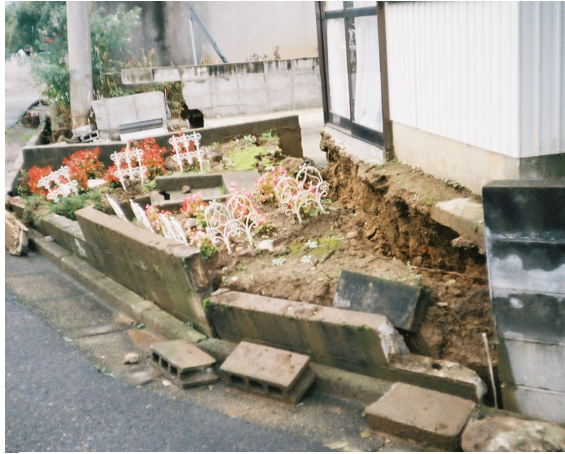
写真 7.29 宅地における低盛土(50-70cm)が崩壊することによる住宅の不同沈下や崩壊
