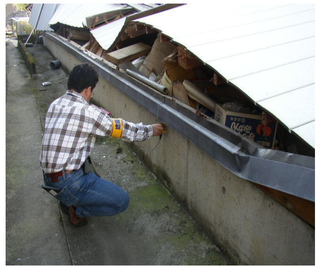
写真 7.33 戸建住宅の基礎と上部構造の被害 (基礎は無被害であるが上部構造が崩壊した例。基礎は鉄筋コンクリート造であることが多い)
