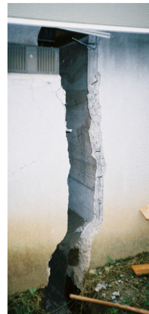
写真 7.32 戸建住宅の基礎の被害(高床式の鉄筋コンクリート造の被害) (地すべりが発生して著しい地盤変位が生じた地域で見られた例)
