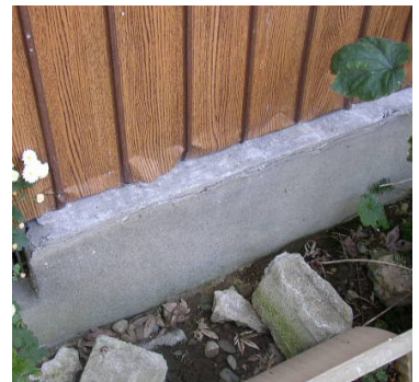
(c)床下の高い支柱・束（ろうそく基礎と呼ぶこともある） (d)無筋コンクリート
