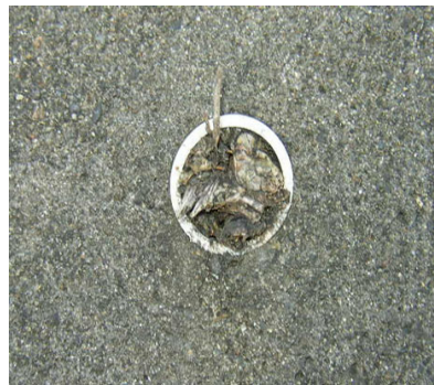
写真 7.28 擁壁の維持管理等の状況 (水抜き孔の孔詰まり、水抜き孔からの土砂流出)
