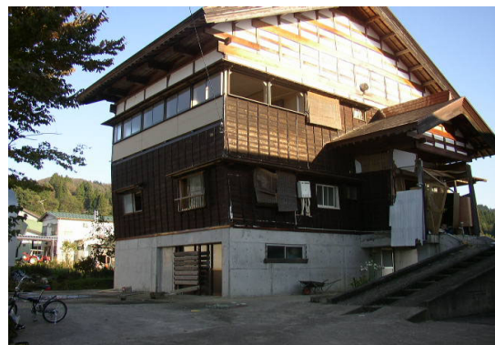
写真 7.2 被災地に多い高床式の鉄筋コンクリート造の基礎
