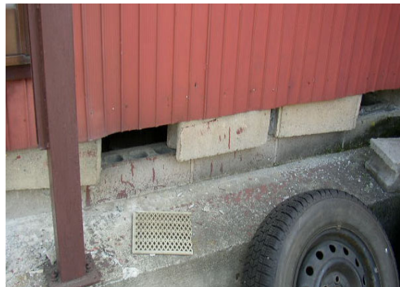
写真 7.34 戸建住宅の基礎の被害
