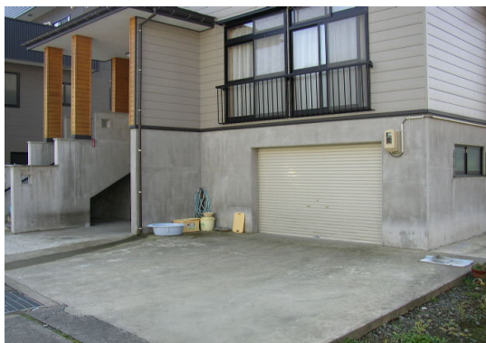
写真 7.2 被災地に多い高床式の鉄筋コンクリート造の基礎
