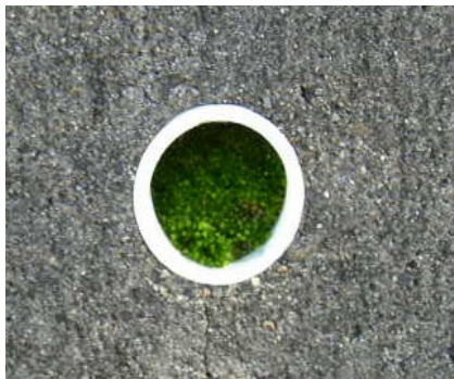
写真 7.28 擁壁の維持管理等の状況 (水抜き孔の孔詰まり、水抜き孔からの土砂流出)
