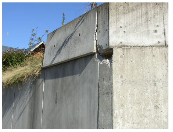
写真 7.26 宅地擁壁の被害
