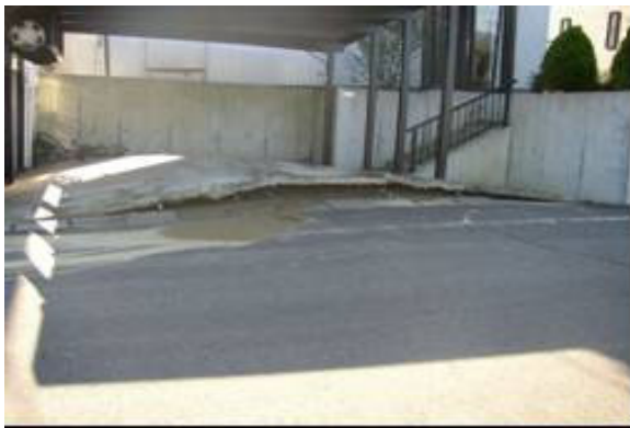
写真 7.26 液状化による地盤の隆起と宅地内の地割れ (長岡市)
