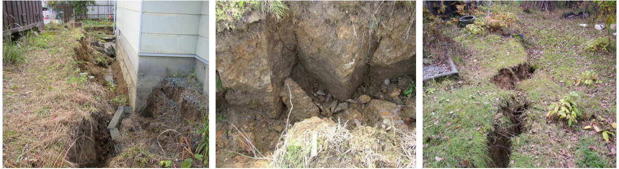
写真 7.24 高町団地外周道路より外側の住宅敷地における地盤変状の例
