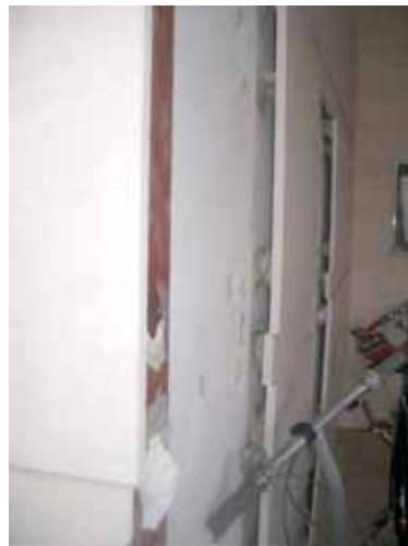
写真 21 外壁の剥離
