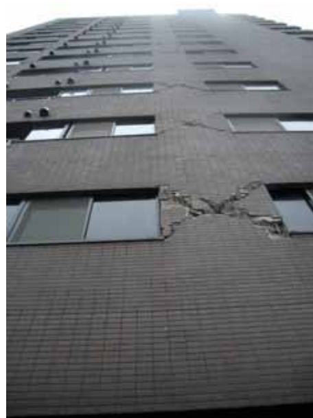
写真 15 共同住宅外壁面のせん断ひび割れ
