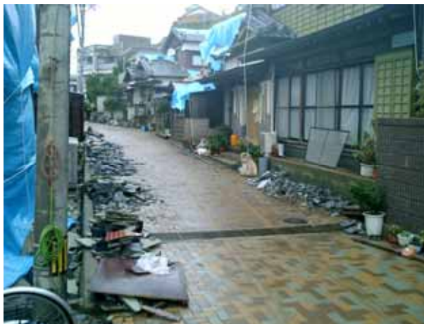
写真 35 屋根瓦の落下
