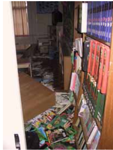
写真 38 小学校の内部
