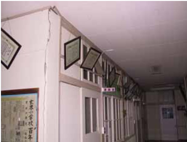
写真 39 小学校の内部
