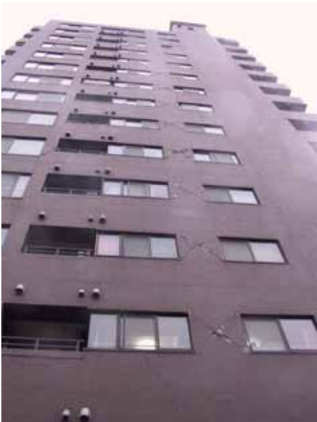
写真 15 共同住宅外壁面のせん断ひび割れ
