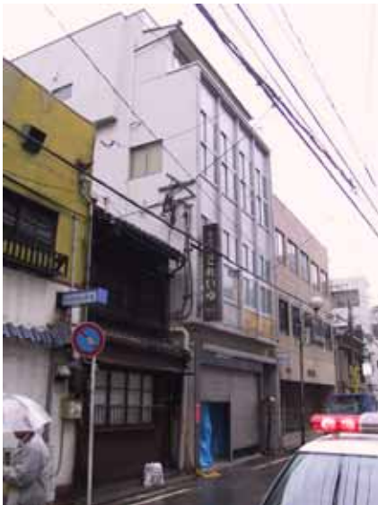
写真12 総合判定「危険」の店舗外観
