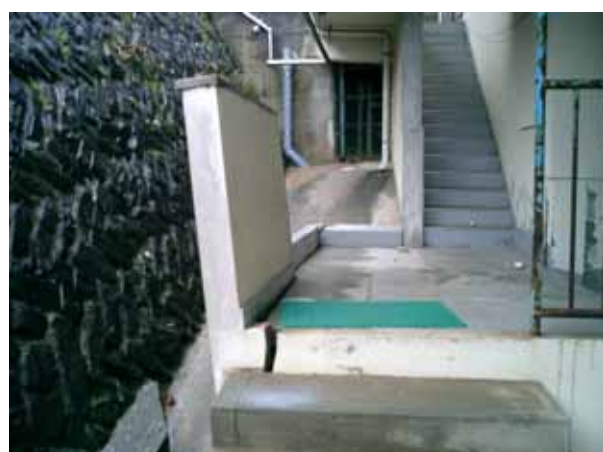
写真 48 中学校体育館の塀
