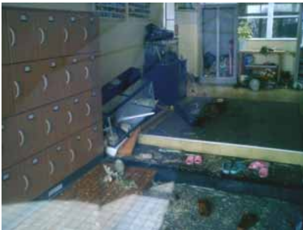
写真 47 中学校の玄関内部 (植木鉢が倒れ、水槽が割れている)
