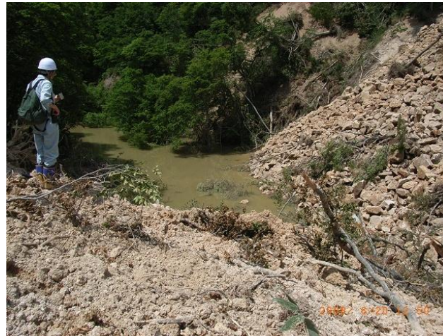
天然ダム現地調査(湯ノ倉温泉下流)
