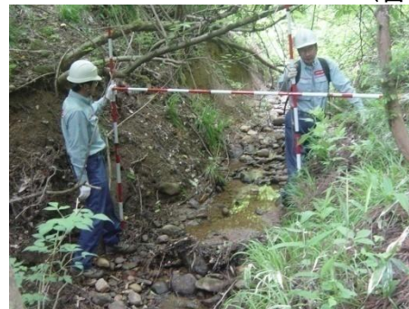
土石流危険溪流の点検状況 (岩手県旧平泉町)
