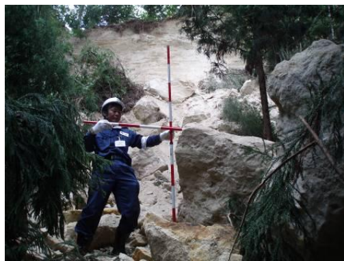
宮城県一迫町での点検状況
