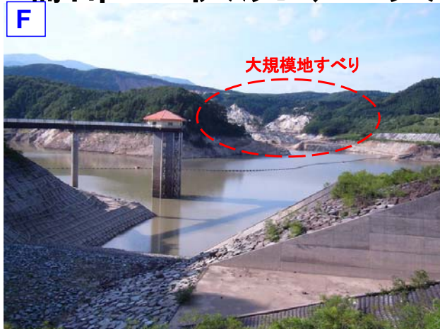
荒砥沢ダムとその上流の大規模地すべりとの位置関係。距離はおおよそ1km程度。(H20.8.9)
