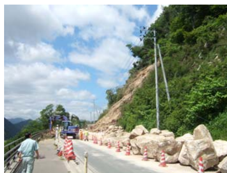
山側切土のり面(のり枠+ロックボルト工)の上方自然斜面で岩盤崩壊が発生
