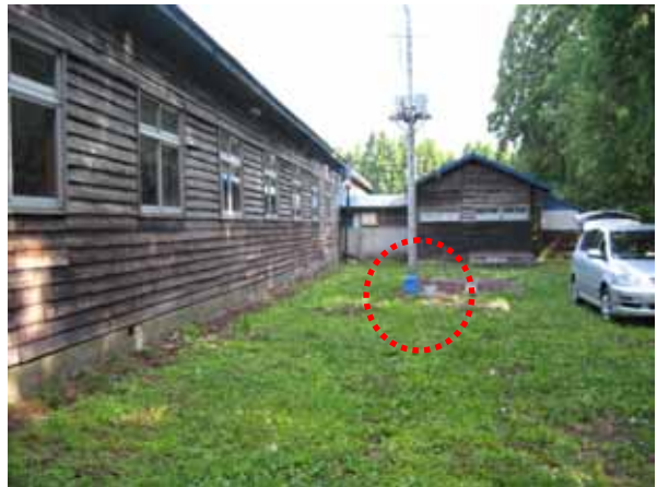
写真-3.8 鬼首中学校強震計設置状況
