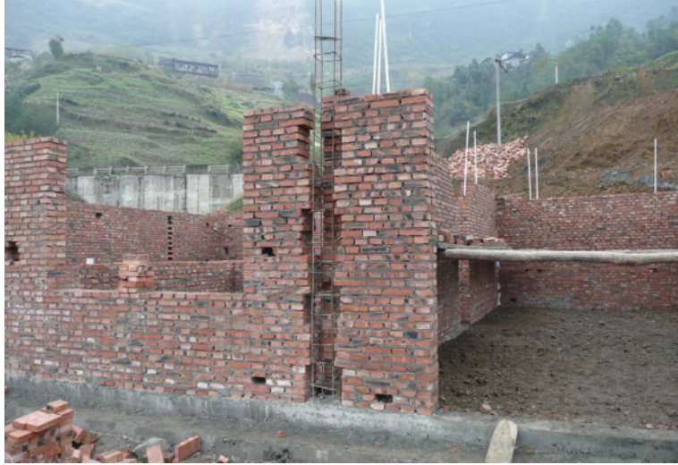
写真 6.2 山間部（映秀）における住宅再建の様子
