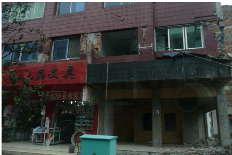
写真 6.4 市街地（都江堰）における店舗併用住宅 （1階はRC造2階以上は枠組組積造）の被害
