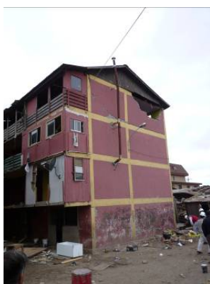
写真 15-3 妻壁頂部の梁の崩落
