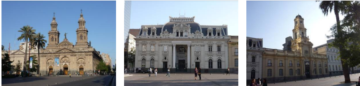
写真 13-1 サンティアゴ市内の組積造建物（無被害）
