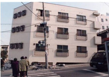
写真 36-3 ピロティ建物の崩壊 （阪神・淡路大震災）
