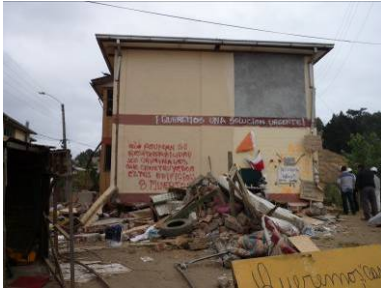
写真 14-3 1層部分で層崩壊した建物
