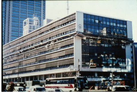
写真 35-3 中間層で崩壊した建物（阪神・淡路大震災）
