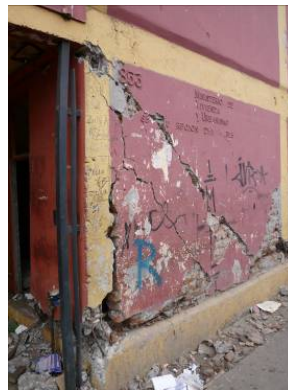
写真 15-2 妻壁のせん断破壊
