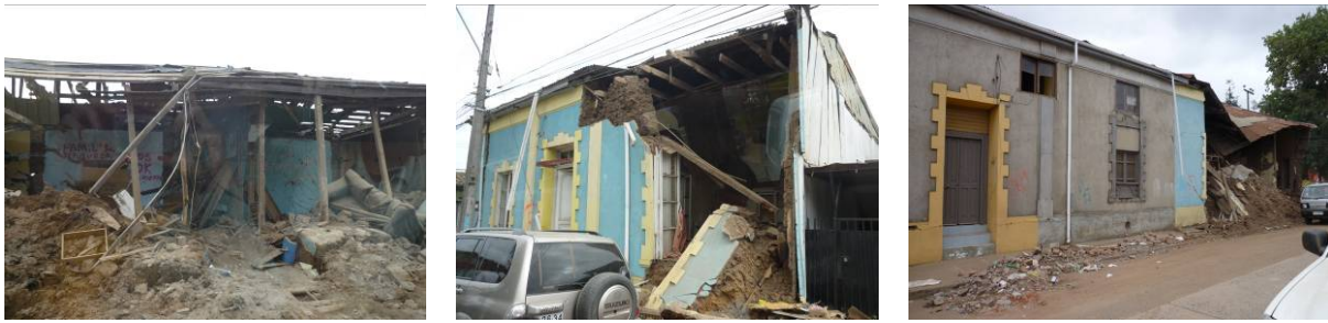
写真 16-1 れんが造やアドベ造建物の被害
