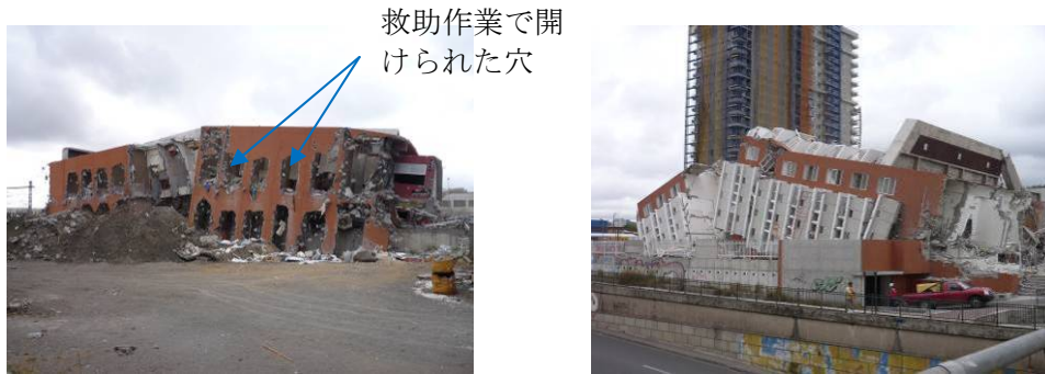
写真34-1 転倒による被害(写真25-1を再掲)
