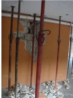
写真 10-2 T形壁柱と耐力壁の破壊
