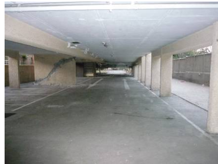
写真 9-2 1階駐車場（ピロティ）
