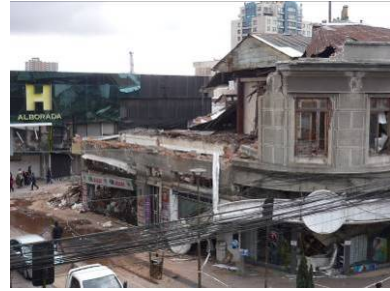
写真 38-2 れんが造建物の被害（写真 22-1、写真 26-1 を再掲）
