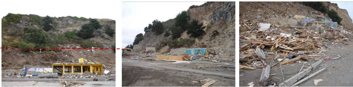
写真 31-3 津波の被害跡
