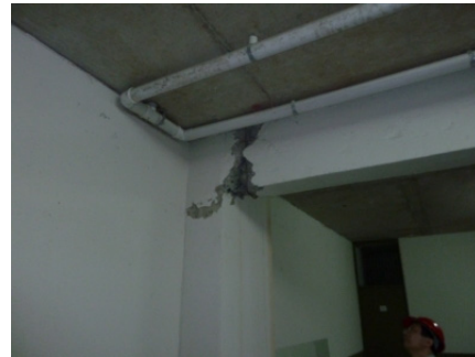
写真 4-4 写真 4-2 の地下部分
