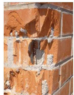
写真 28-3 壁の縦筋
