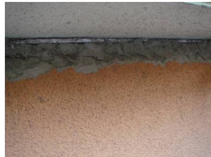
写真 10-3 壁上端の充填物
