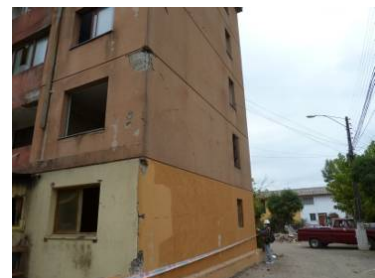
写真 21-3 隅柱の損傷
