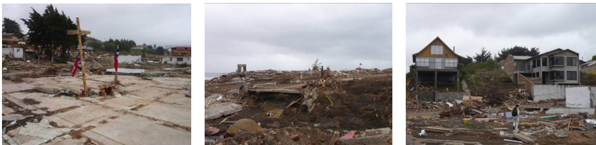
写真 32-1 津波による海岸部の被害
