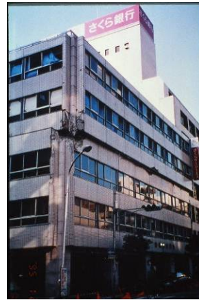
写真 35-3 中間層で崩壊した建物（阪神・淡路大震災）
