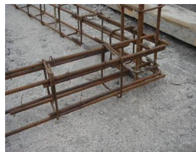
写真 18-2 基礎梁の配筋とコーナー鉄筋
