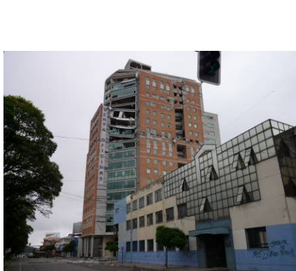
写真35-1 中間層崩壊による被害(写真23-1を再掲)
