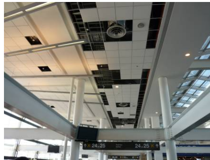
写真 47-2 サンティアゴ国際空港天井パネルの脱落
