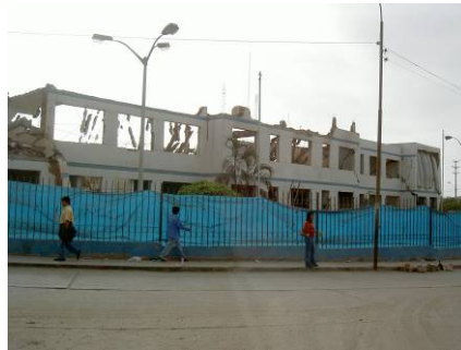
写真 37-3 崩壊した CM 造建物（ピスコ地震）
