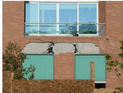
写真 7-2 梁のと柱梁接合部破壊
