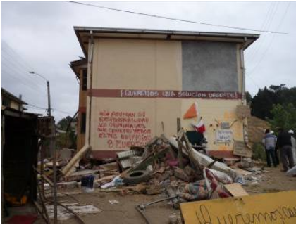
写真 37-1 1 階部分で層崩壊した CM 造（写真 14-3 を再掲）
