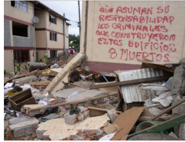
写真 14-3 1層部分で層崩壊した建物
