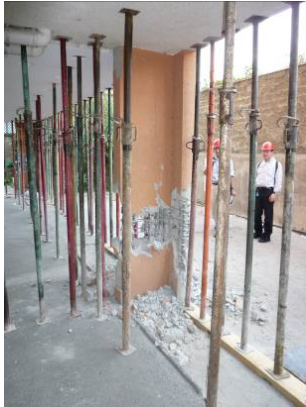
写真 10-2 T形壁柱と耐力壁の破壊
