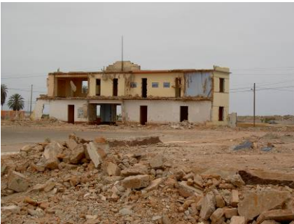
写真 37-3 崩壊した CM 造建物（ピスコ地震）
