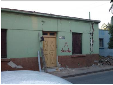
写真 38-2 れんが造建物の被害（写真 22-1、写真 26-1 を再掲）
