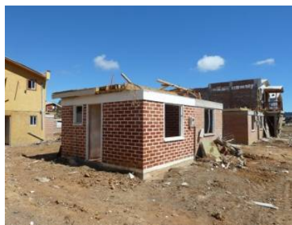
写真 28-2 津波により2階が流された住宅
