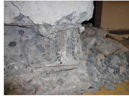
写真 20-4 柱脚部の配筋状況
