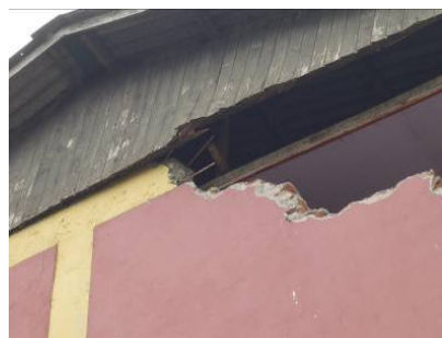
写真 15-3 妻壁頂部の梁の崩落
