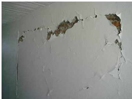
写真 12-3 非構造内壁の損傷
