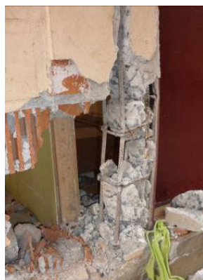
写真 14-2 CM 造の柱と壁部分
