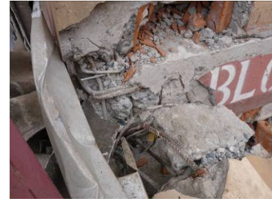
写真 14-4 柱梁接合部
