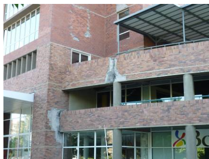
写真 44-1 2 棟の建物の接合部分 （写真 6-2 を再掲）
