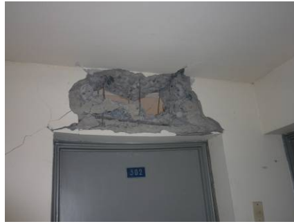
写真 20-3 せん断破壊した耐力壁と短スパン梁
