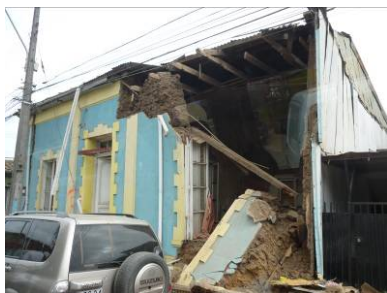
写真 38-1 アドベ造建物の被害（写真 16-1、写真 22-1 を再掲）
