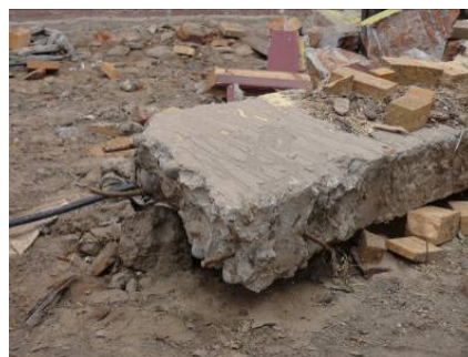
写真 42-2 継ぎ手位置が揃った梁主筋 (写真 15-4 を再掲)
