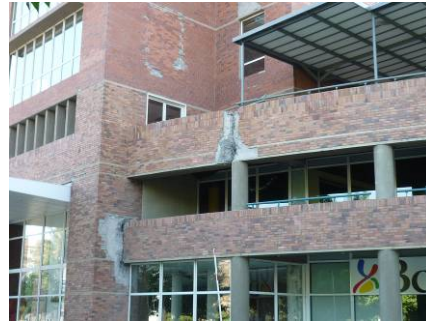
写真 6-2 壁梁の損傷
