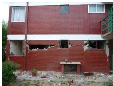
写真 17-1 妻壁と桁行方向壁の崩壊
