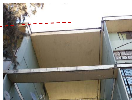
写真 12-5 屋上部分の飾り梁が脱落（左は落下した梁）
