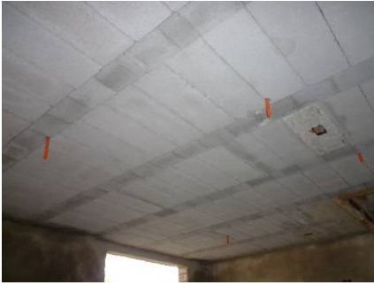
写真 18-3 スラブ（見上げ）
