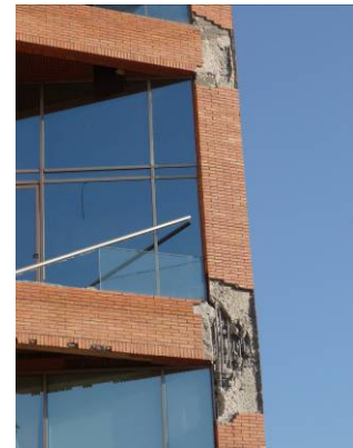
写真 7-2 梁のと柱梁接合部破壊
