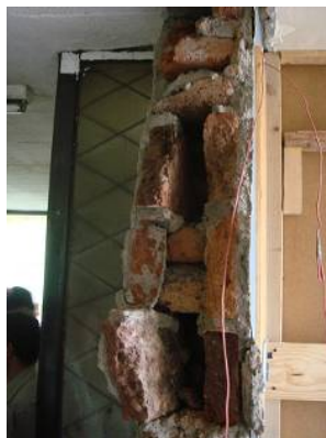
写真 12-3 非構造内壁の損傷
