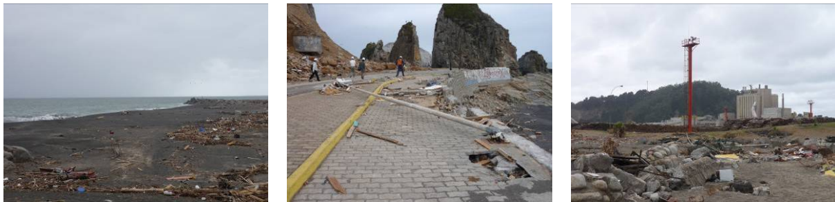
写真 31-4 津波による海岸部の被害
