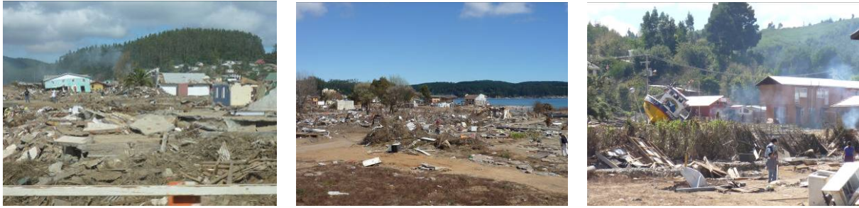
写真 33-1 津波による海岸部の被害
