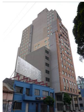
写真35-1 中間層崩壊による被害(写真23-1を再掲)
