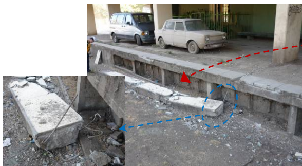
接続部の配筋状況
