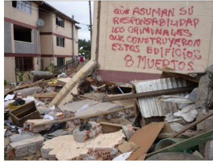
写真 37-1 1 階部分で層崩壊した CM 造（写真 14-3 を再掲）
