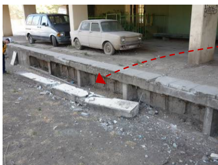
写真 12-5 屋上部分の飾り梁が脱落（左は落下した梁）
