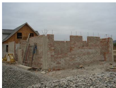
写真 18-1 CM 造住宅建設風景
