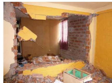
写真 14-2 CM 造の柱と壁部分
