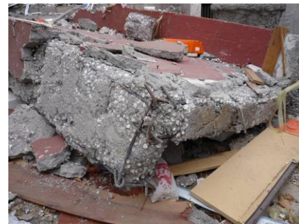
写真 19-2 発泡スチロール粒が混入された コンクリート
