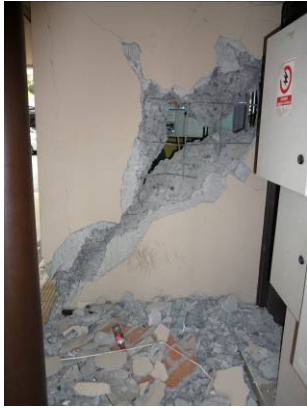
写真 20-3 せん断破壊した耐力壁と短スパン梁
