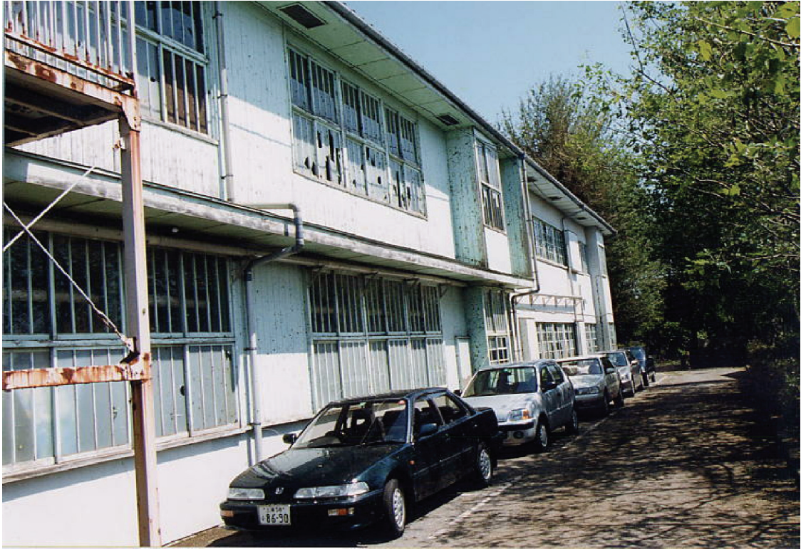
図6 校舎の窓ガラスの被害（我孫子市教育委員会提供） 校舎の2階の窓ガラスは丸い穴が無数に開いている。窓の上段部のガラスがあまり割れていないのは、大きく張出した庇の影になったものと思われる。
