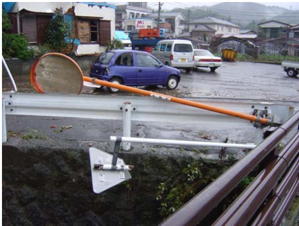
写真 13 道路標識の折損
