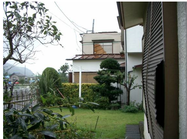
写真6 雨戸のはらみによる損傷
