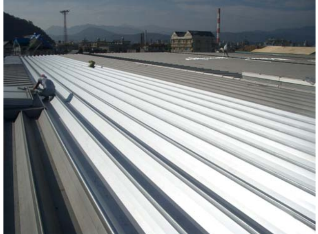
写真10 鋼板製屋根ふき材の修復状況
