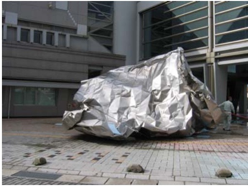
写真 41 落下した屋根ふき材
