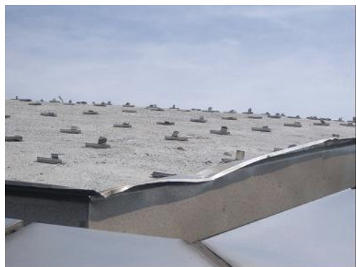
写真 48 吊子の間隔
