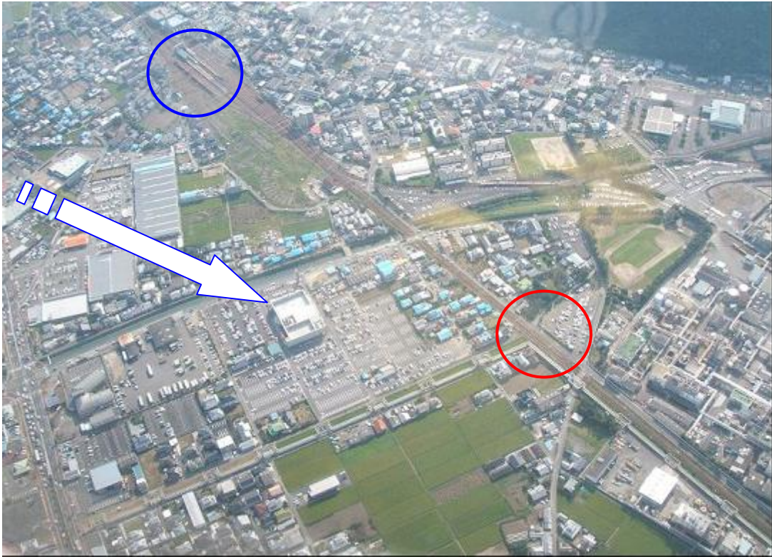
写真2 上空からの特急列車の転覆（横転）現場付近の状況（九州地方整備局提供）
