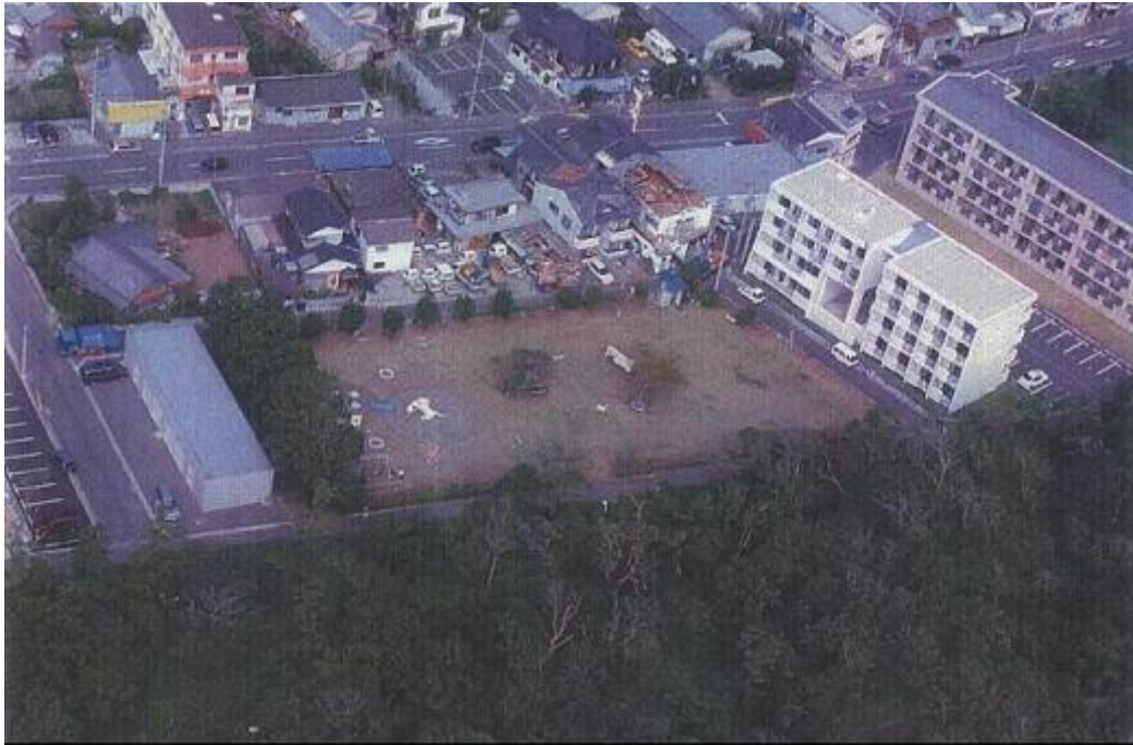
写真11 上空からの被災直後の緑ヶ丘5丁目公園周辺の状況（九州地方整備局提供）
