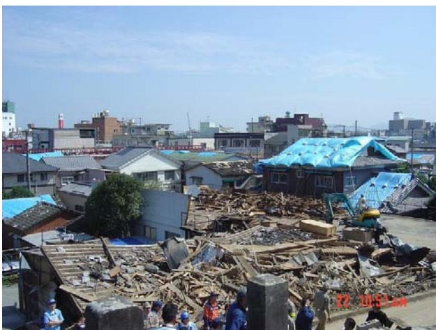
写真 33 木造住家の倒壊(山下町)
