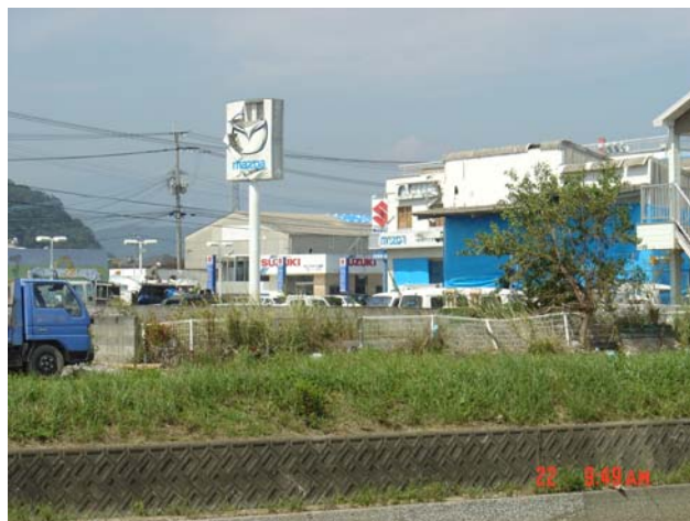
写真 36 看板の損傷(浜町)
