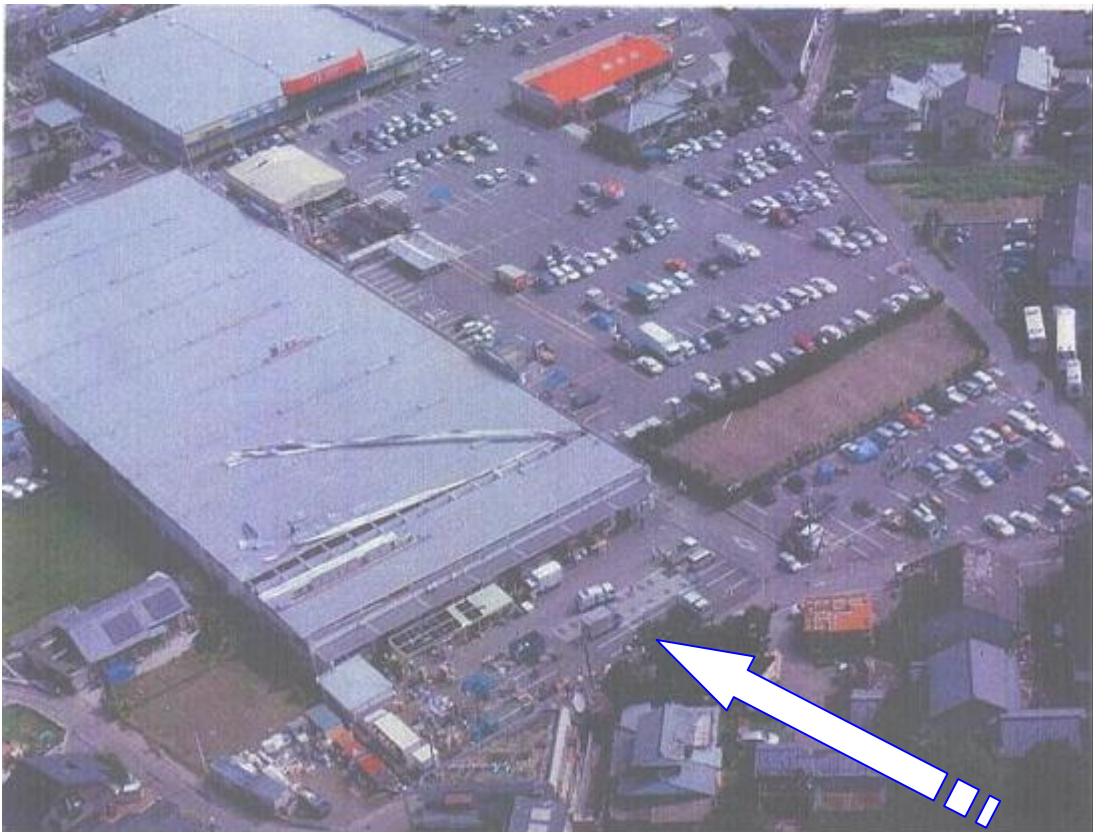
写真4 上空からの被災直後の状況（矢印は竜巻の進行方向を表す：九州地方整備局提供）
