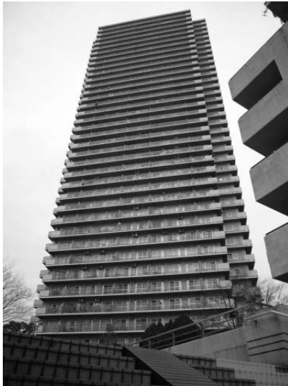
写真 1 佃タワー外観
