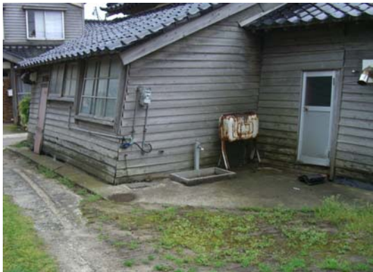
写真-8.4 土台から上部の建物被害 (土台から上部の建物の変形と外壁の破損)
