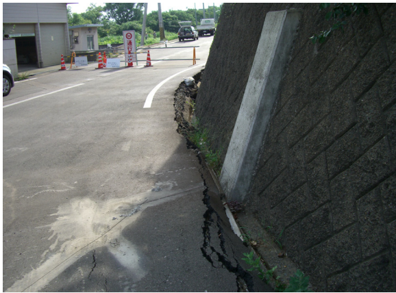
写真-8.18 山本団地における擁壁の被害例
