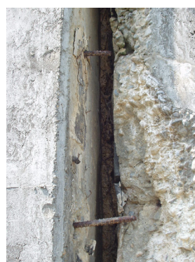
擁壁接合部の状況
