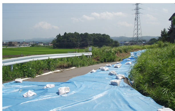
擁壁上部 団地内外周道路
