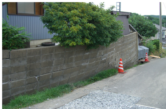
ブロック土留め壁体のねじれ
