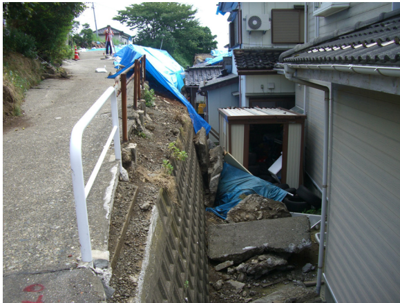
擁壁手前側（高さ 2m）の状況
