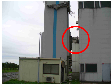
写真-6.3 煙突の北側面 (水平煙道)
