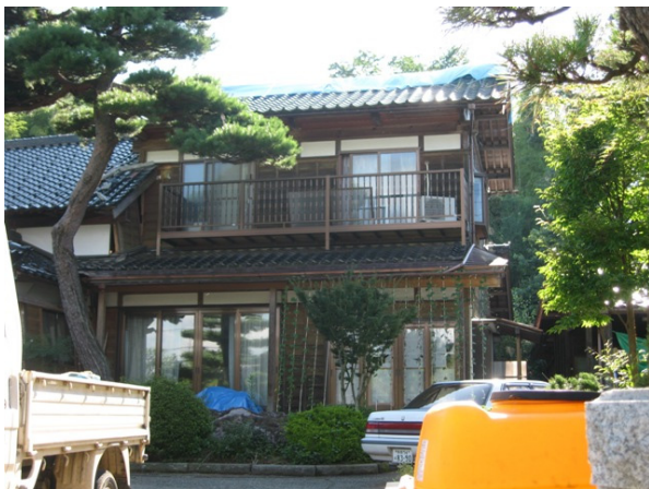
写真-4.3.59 増築部分の外観
