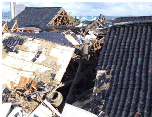
写真-6.7 煙突と木造工場 (写真中央に、煙突の低層部(奥)、中層部、先端部(手前)が 3 本見える)
