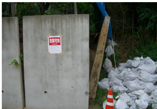
壁高 2m 程度の L 型擁壁
