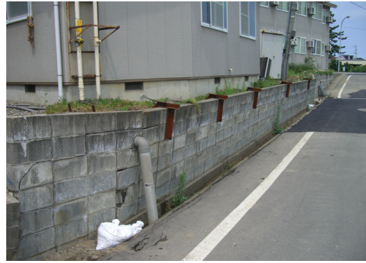
写真-8.32 液状化による木造建物の被害状況 (基礎形式：直接基礎、数十 cm の不同沈下)
