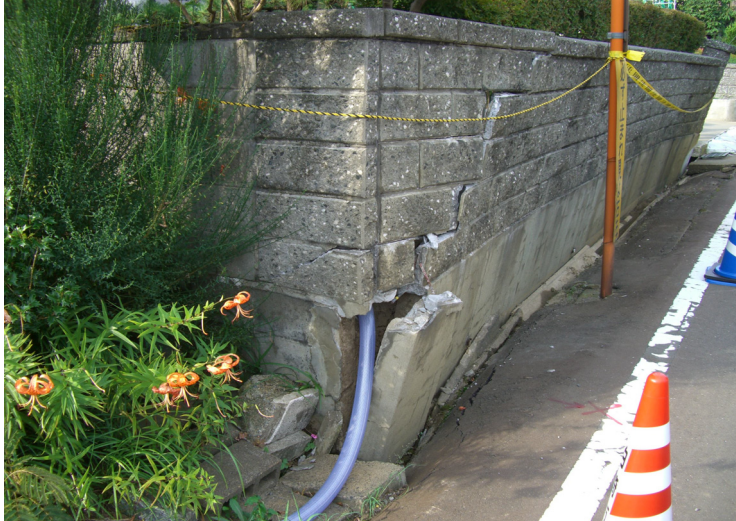
写真-8.34 種々の擁壁の被害例
