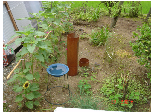
写真-4.3.65 中越地震後の液状化対策用鋼製パイプ
