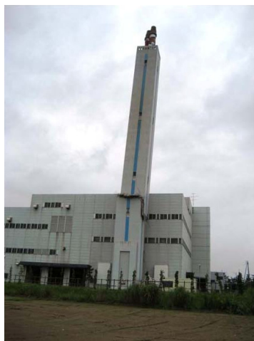
写真-6.1 柏崎市橋場にある塔状工作物(自立型煙突)の全景
