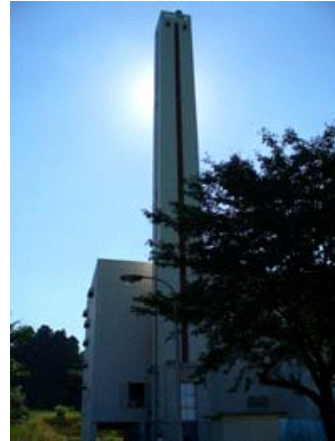
写真-6.6 小千谷市時水にあ る塔状工作物
