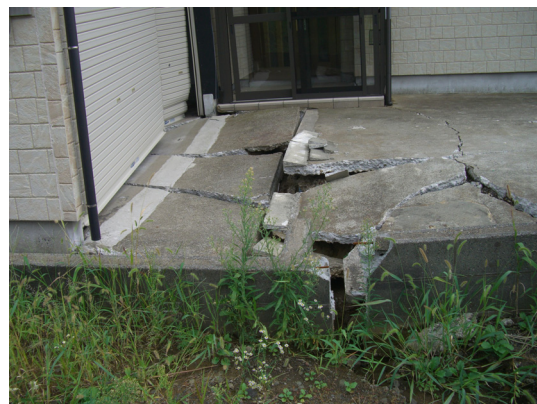
写真-8.17 橋場における危険住宅（左：全景、右；車庫前の段差 20cm 程度沈下）
