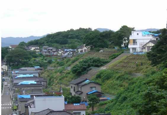
写真-8.8 海側からみた崖周辺の状況
