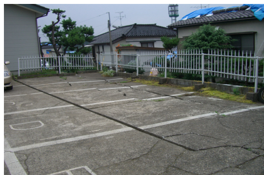
ブロック土留めの変形と背面地盤の陥没・段差
