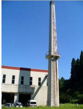
写真-6.5 長岡市小国町武石 にある塔状工作物
