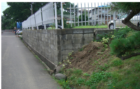
ブロック土留めの変形と背面地盤の陥没・段差
