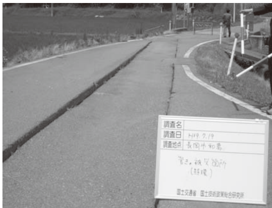
写真-4.3 埋戻し部沈下 (長岡市和島)
