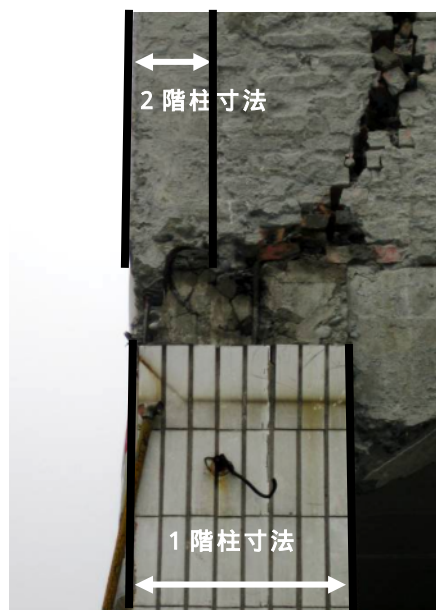
写真 5.6 写真 5.5 の1階柱と2階柱の接合部
