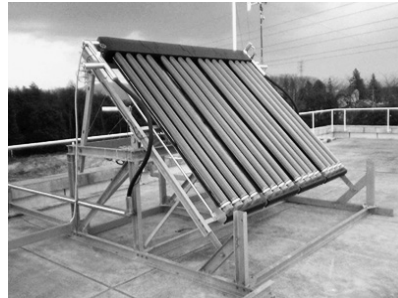
図3.5.4 集熱パネルの例 （太陽熱給湯システム 自然循環式）
