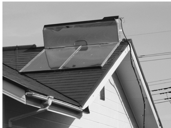
図3.5.2 集熱パネル、貯湯タンクの例(太陽熱温水器・自然循環式)
