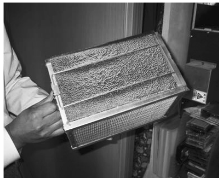
図5.2.3 熱交換素子の点検
