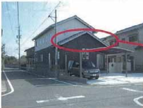
写真：小屋裏空間の利用
