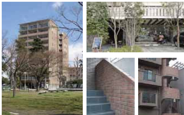
④長く保ち剥離しないレンガの腰壁
