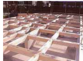
土台・大引組立状況
