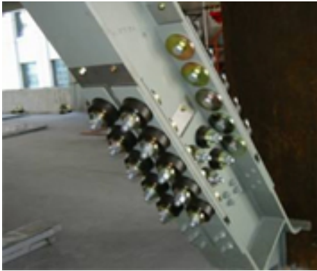
解図 2.2.2 摩擦ダンパーの一例
