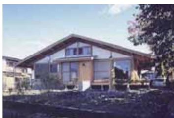
軒の出が深く、外壁に杉板を用いた住宅。
