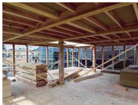
内部は2本の構造柱だけのがらんだ空間
