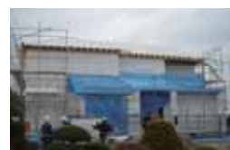
↑2日目の様子 上棟は2日工程です。
