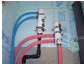
【②ヘッダー前圧力ゲージの設置】
