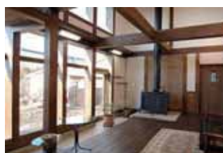
高窓からの採光と蓄熱土間
