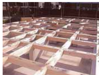
土台・大引組立状況
