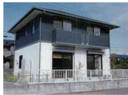
エバーループ事業により再生した住宅
