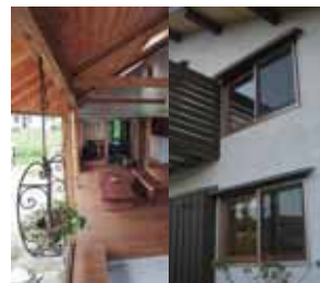
深い軒の出と付け庇の設置
