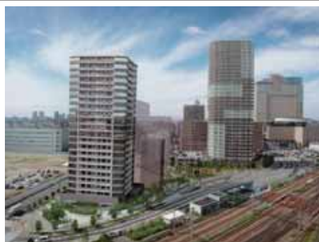
川崎駅西口大宮町F街区
