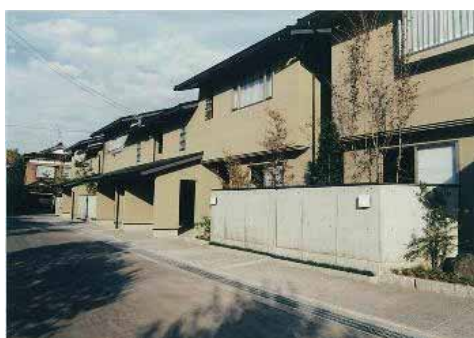
写真3：軒を設けたビルトインガレージにより街並みの特長が際立った例
