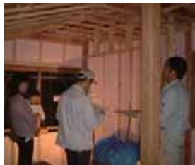
施工中に行う住まい手参加での立会い検査
