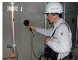
住宅診断：基礎配筋検査の例
