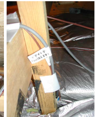
天井吊り木 直上
