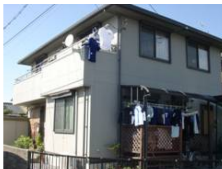
図 2.7.9 建物外観(C棟)
