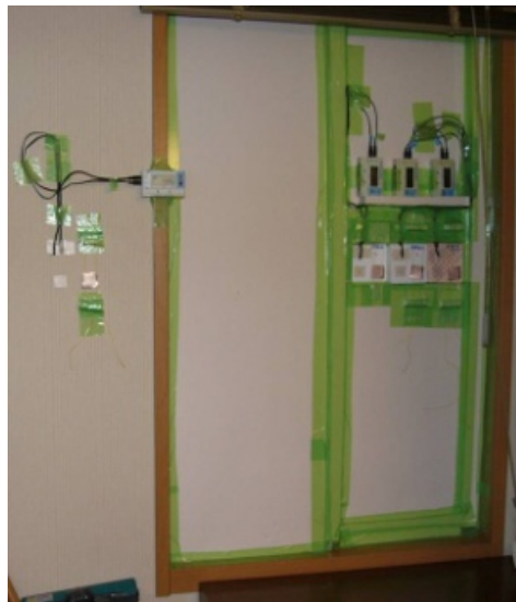
図 2.7.12 測定状況(室内側、C棟)
