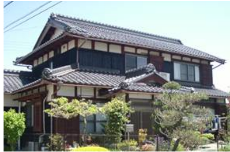
図 2.7.7 建物外観(A棟)
