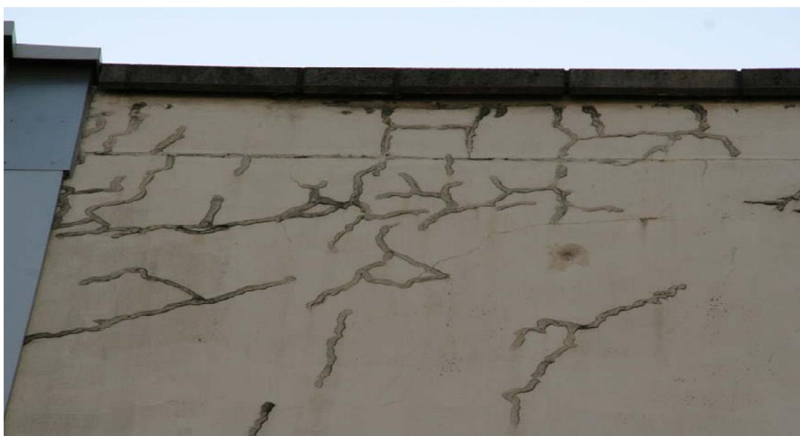
写真 3.2 シール工法で補修した施工例
