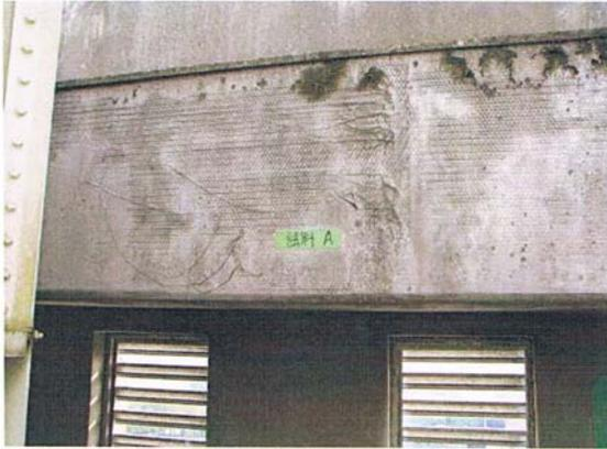
a. 仕上げが無い場合、風雨の当たる面はフィラーが洗い流されネットが露出している。
