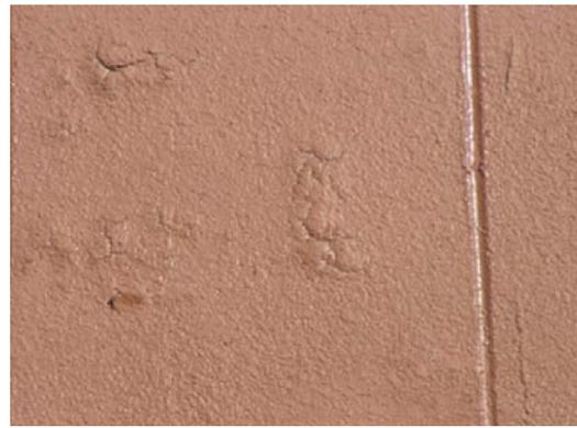
② 塗装材のふくれ (漏水による劣化)
