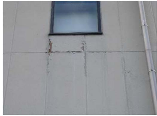
④ 塗装材のはく離 (開口部からの漏水による劣化)
