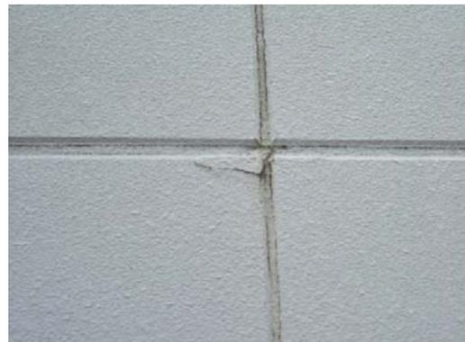
⑦ シーリング接合部周辺の ALC のひび割れ (高接着力による部材破壊)
