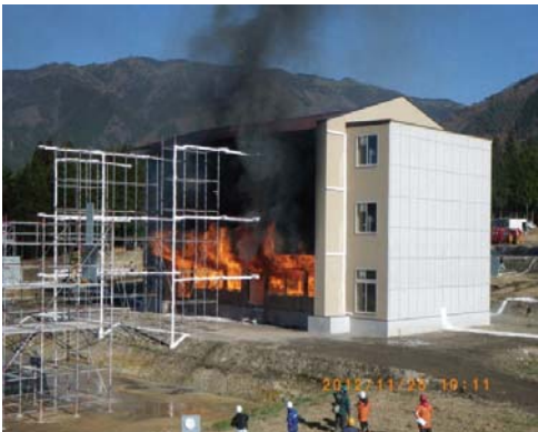
写真5 2階開口部からも噴出火炎 (131分後)
