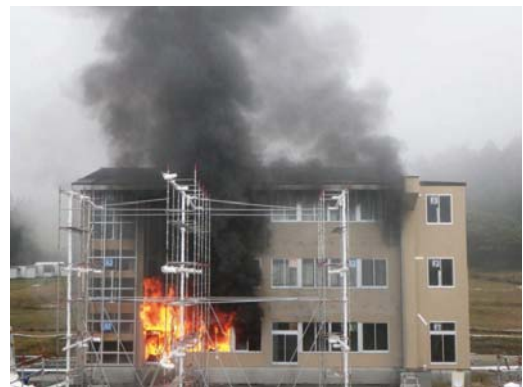
写真6 出火室フラッシュオーバー (68分後)
