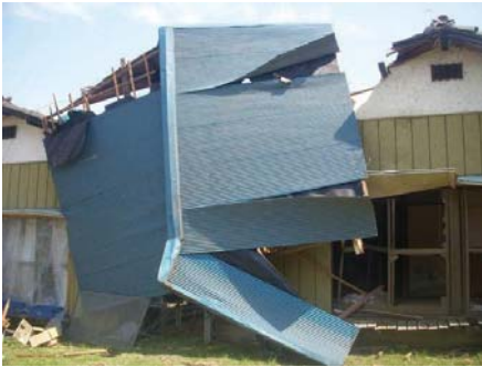
写真 28 飛来物(屋根)の衝突 (つくば市)
