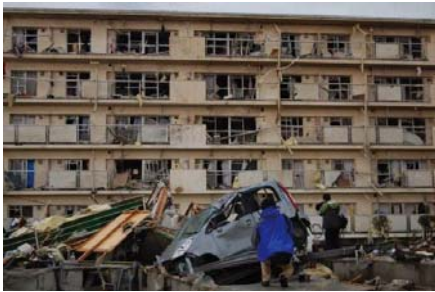
写真 22 集合住宅(南面)の被害状況 (つくば市)
