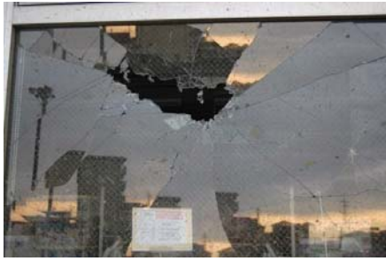
写真 27 窓ガラスへの衝突痕 (つくば市)
