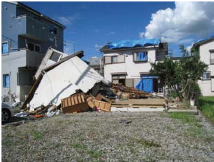
写真10 上部構造の倒壊（越谷市）
