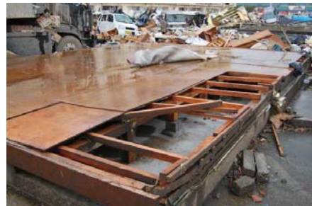
写真13 上部構造の飛散（つくば市）
