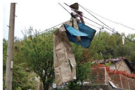
写真 26 電線に引掛かった飛来物(鋼板製屋根材) (つくば市)
