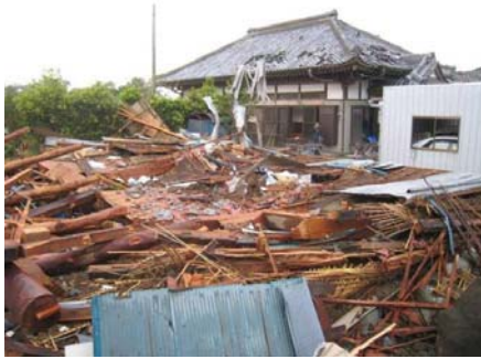
写真9 上部構造の倒壊（手前の建築物の残がい）（つくば市）
