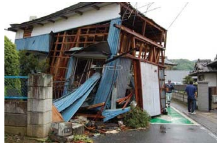
写真14 上部構造の水平移動（つくば市）
