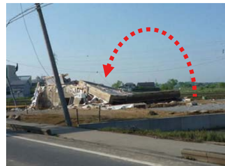
写真15 基礎を伴う上部構造の転倒（つくば市）
