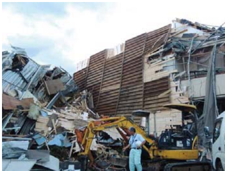
写真 29 飛来物(上部構造)の衝突 (越谷市)
