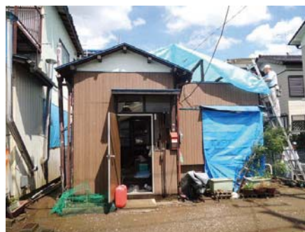
写真7 小屋組の破壊 (越谷市)
