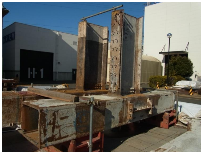
写真 3.1.1-1 試験体切出状況
