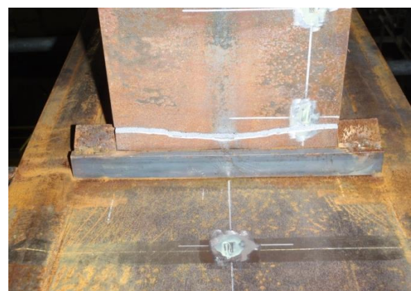
(b) フランジ破断状況(フランジ外側)
