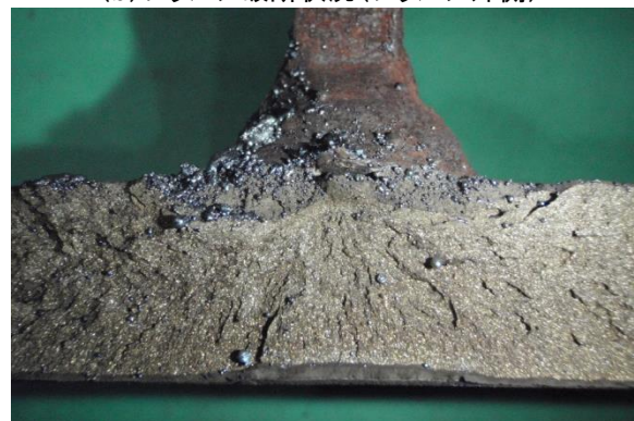
(d) スカラップ底のき裂の起点部
