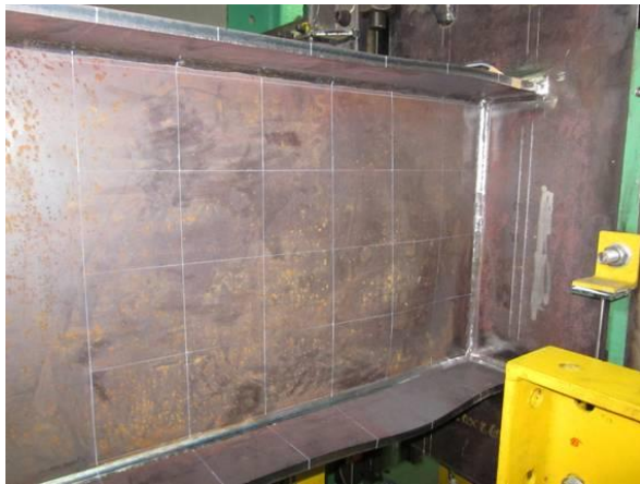
局部座屈進展(-28 サイクル目)
