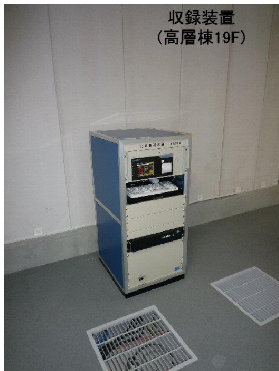
写真 5.1.1-1 加速度計および収録装置の設置状況
