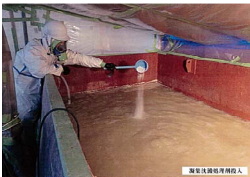
写真5 凝集沈殿処理剤投入
