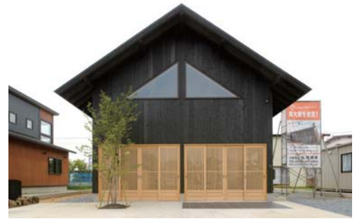
道路からの外観：外壁は焼杉を採用。表面が炭化しているため長持ちしやすい。軒の出を910mm出して、焼杉の劣化防止にしている。8枚の建具を耐候性の高い地場の青森ヒバを採用。外部から中の様子は見えないが、内部からは外の様子がはっきり見える細工をしている。金沢のすむしこからヒントを得ている。
