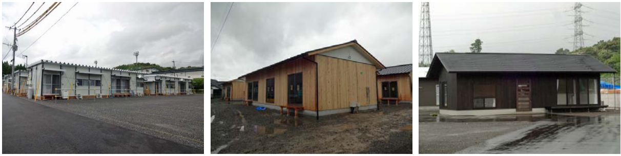
写真 3. 7-1 軽量鉄骨造仮設(甲佐町白旗)・木造仮設(氷川町鹿島)・みんなの家(宇城市当尾)の例
