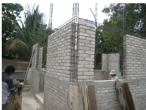
写真3 枠組組積造（ソイルセメントレンガ）
