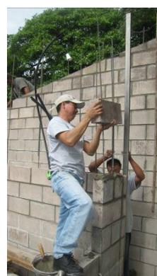
写真2 コンクリートブロック造
