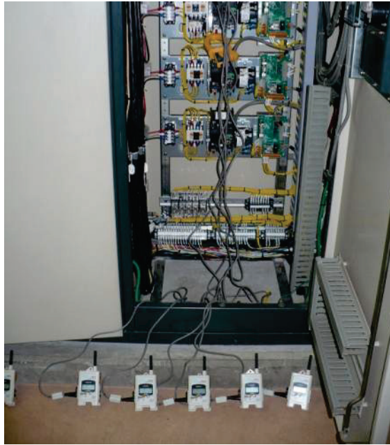
図IV.2.2.2 クランプ電流ロガーの設置状況（動力盤）
