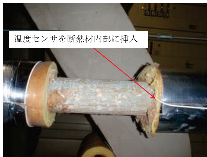
図Ⅱ.2.2.4 配管表面温度測定状況（断熱材復旧前）
