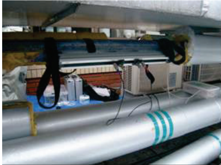
図Ⅱ.2.2.3 超音波流量計による冷温水配管流量測定状況（断熱材復旧前）
