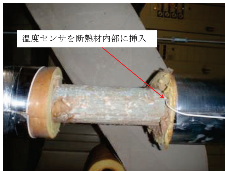
図Ⅲ. 2. 2. 4 配管表面温度測定状況（断熱材復旧前）
