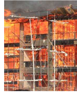
写真 2.7.7-2 トイレ部分両側の壁
