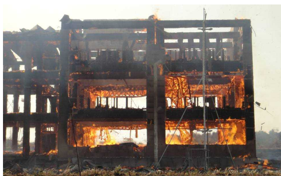
写真 2.7.7-7 枠組壁工法部分壁、床、屋根の消失
