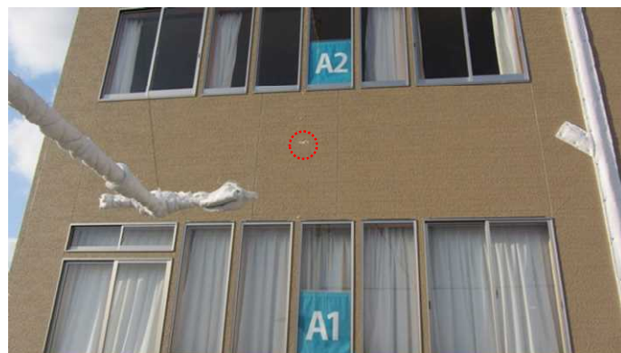
b) 外壁面の熱流束計設置状況
