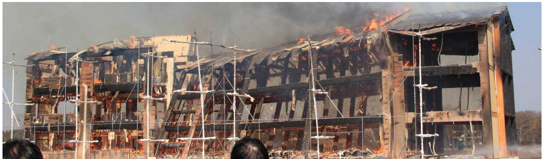
写真 2.7.7-4 軸組構法①部分倒壊の様子 (76 分)
