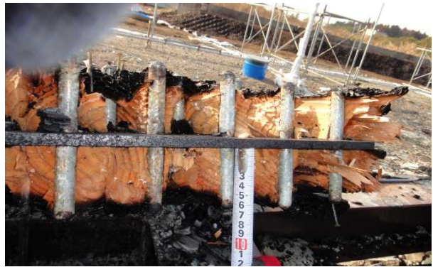
写真 2.7.7-11 残存した断面の測定
