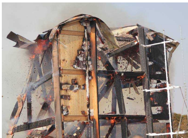
写真 2.7.7-5 軸組構法②部分倒壊の様子 (123 分)
