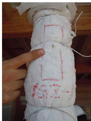
写真 2.5.3-2 熱電対設置の様子
