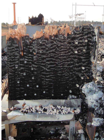
写真 2.7.7-12 脚部での曲げ破壊
