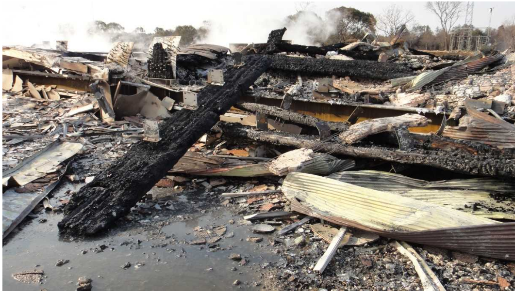
写真 2.7.7-9 消火直後の実験建物の様子
