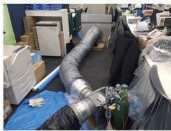
写真 19 補助ファン設置
