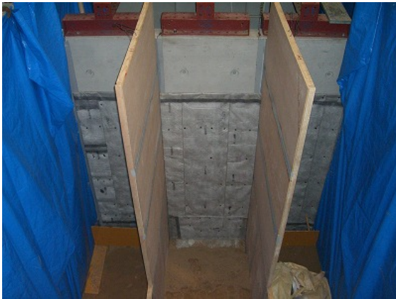
写真 7-9 従来工法透水マット貼付状況
