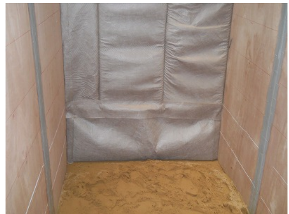
写真 7-15 試験体 No. 2、新工法(B)
