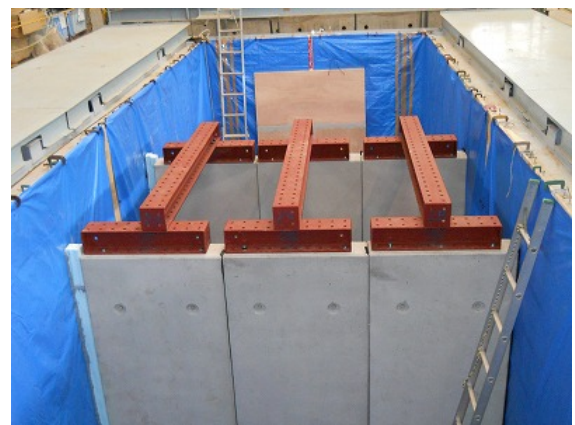
写真 2-5 擁壁天端支保工設置状況
