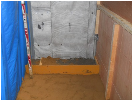
写真 7-24 試験体 No. 4 碎石投入状況
