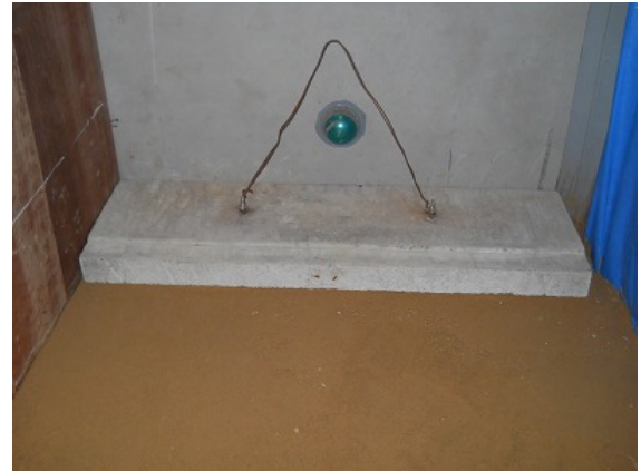
写真 7-5 止水コンクリート設置状況
