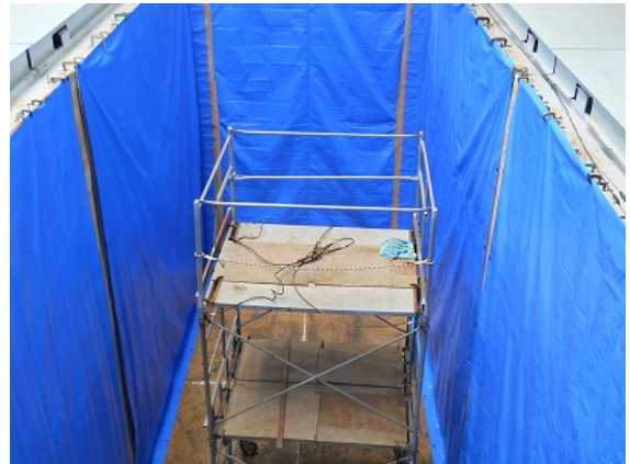
写真 1-4 ブルーシート設置
