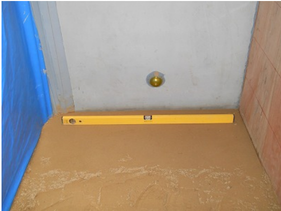
写真 7-4 2層目完了、水平確認
