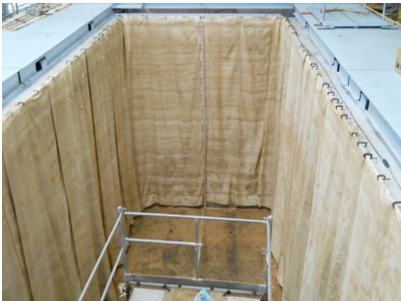
写真 1-3 大型土槽用シート設置 (ブルーシート保護用)
