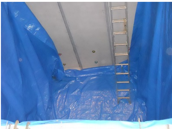
写真 3-5 土層内側（擁壁背面側） ブルーシート設置状況
