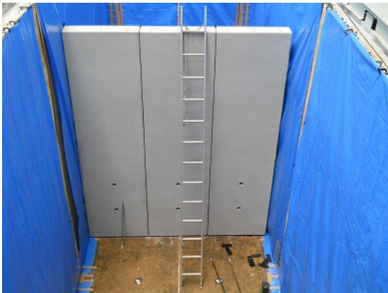
写真 2-3 設置完了（前面側）
