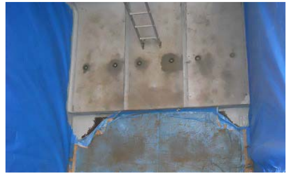
写真 3-4 擁壁底盤防水処理補強状況
