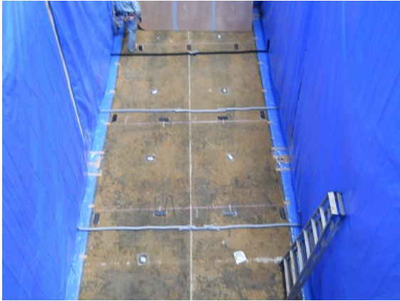
写真 2-1 大型土層の底盤状況
