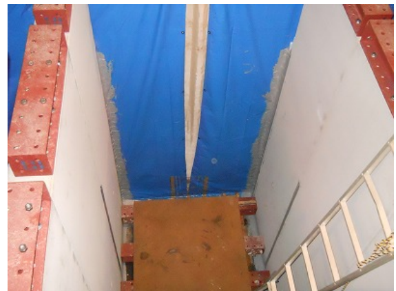
写真 3-6 擁壁前面側の状況
