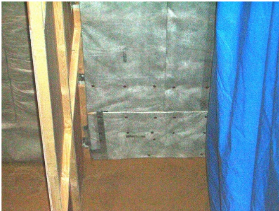
写真 7-14 試験体 No. 1、新工法(A)
