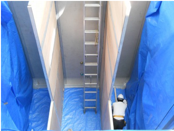
写真 4-1 擁壁仕切り板設置状況（擁壁背面）
