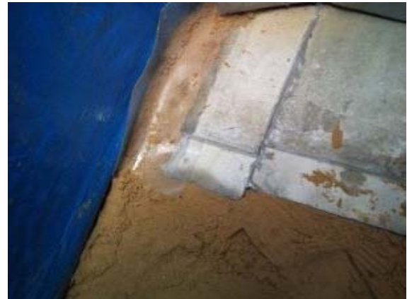
写真 7-7 止水コンクリート端部 シート設置による補充状況
