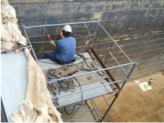
写真 1-1 セン断フレーム間の防水
