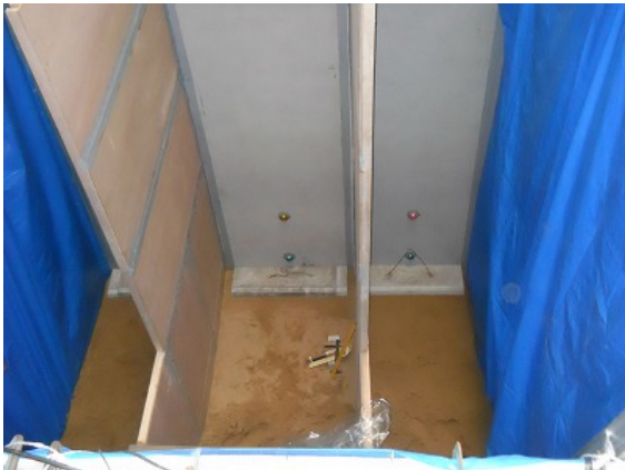
写真 7-6 止水コンクリート設置状況
