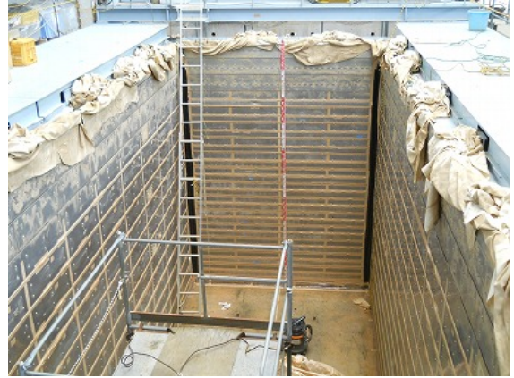
写真 1-2 防水補強(粘着テープを追加)
