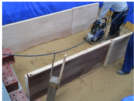
写真 7-26 擁壁背面地盤施工状況 (表層)
