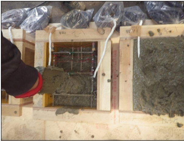
(a) 打設状況
