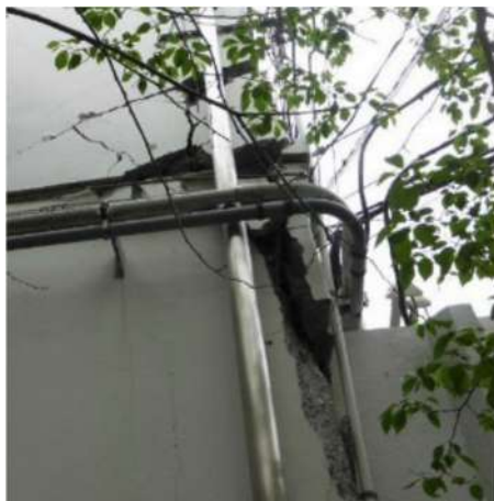
写真 9.3.5 北東側2階柱脚部
