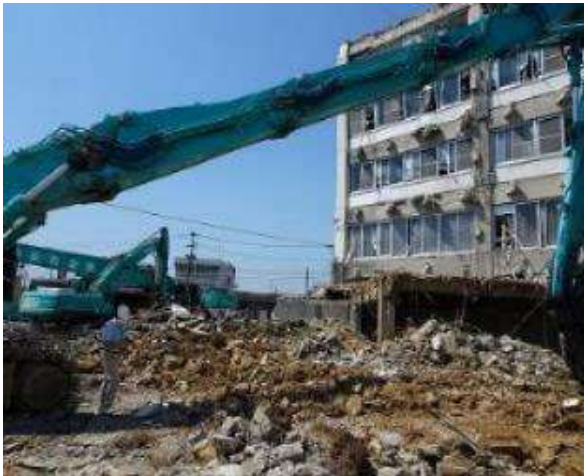
写真 9.2.1 解現場の状況
