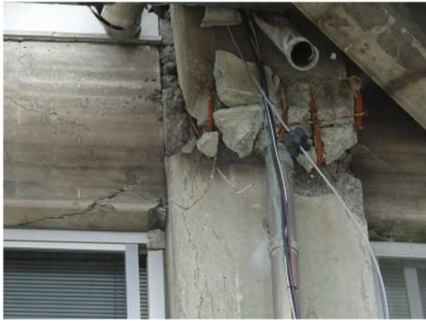
(a) 西側4階柱-5階梁接合部 (b) 南側4階柱-5階梁接合部
