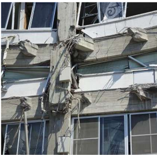
(c) 4, 5階十字形柱梁接合部 (西側面)
