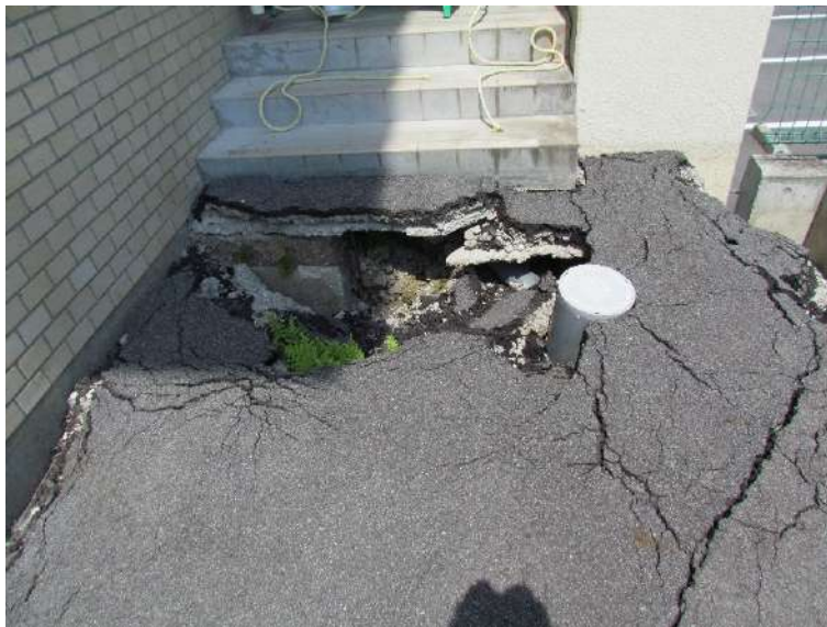
写真 7.4.1.9 外フレーム西側階段
