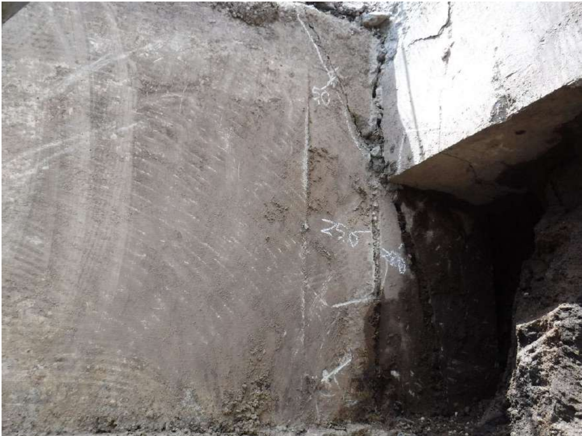
写真 7.4.2.9 基礎フーチング⑥周辺の状況
