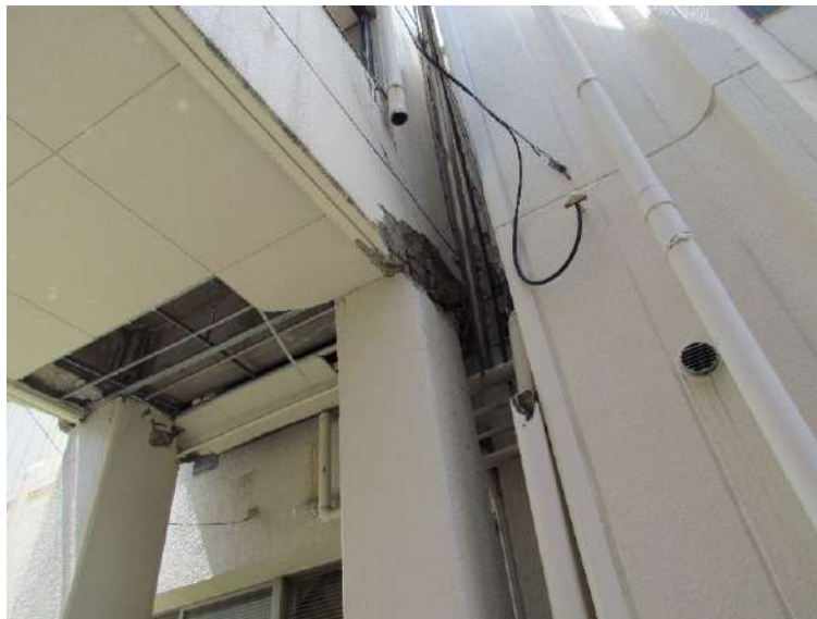
写真 7.4.1.12 渡り廊下棟の柱
