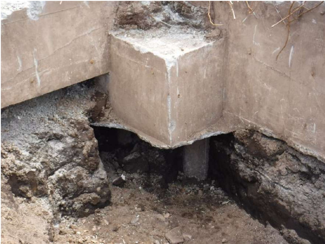
写真 7.4.2.13 基礎フーチング⑨周辺の状況
