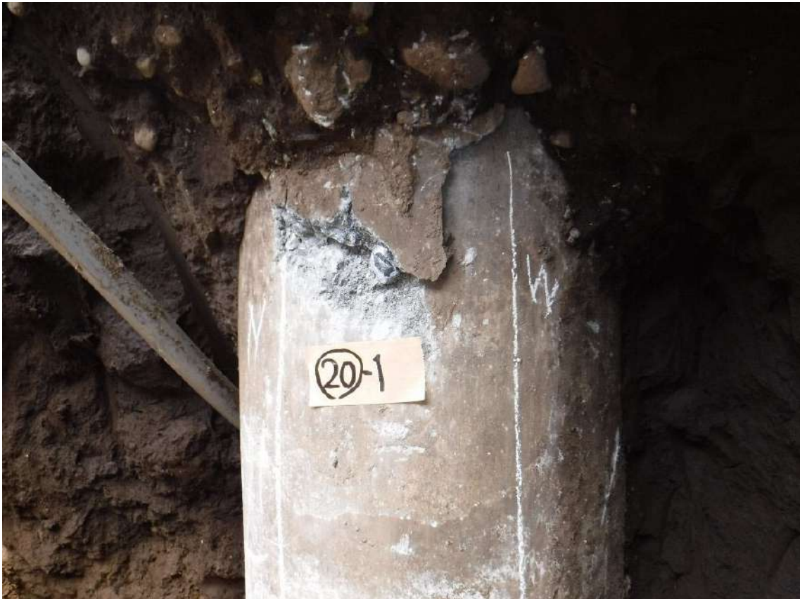
写真 7.4.2.51 杭⑳-1の杭頭部の状況
