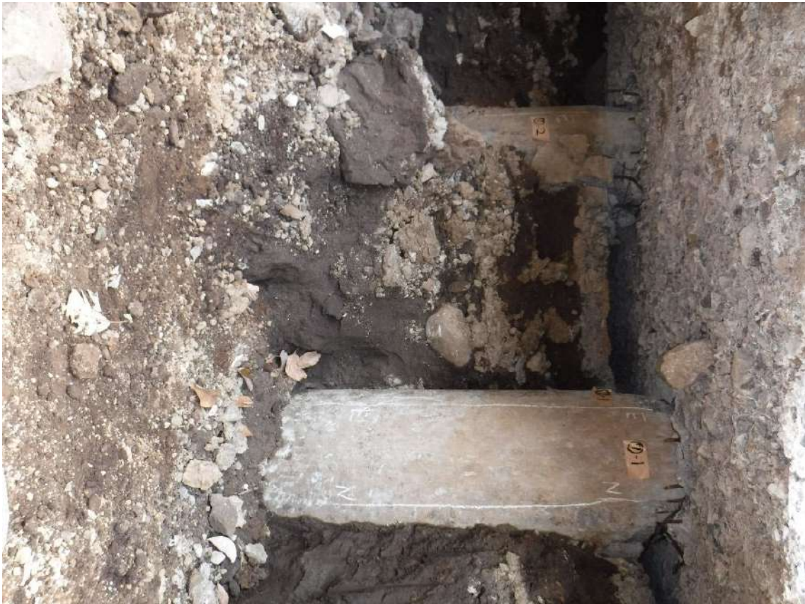
写真 7.4.2.11 基礎フーチング⑦周辺の状況
