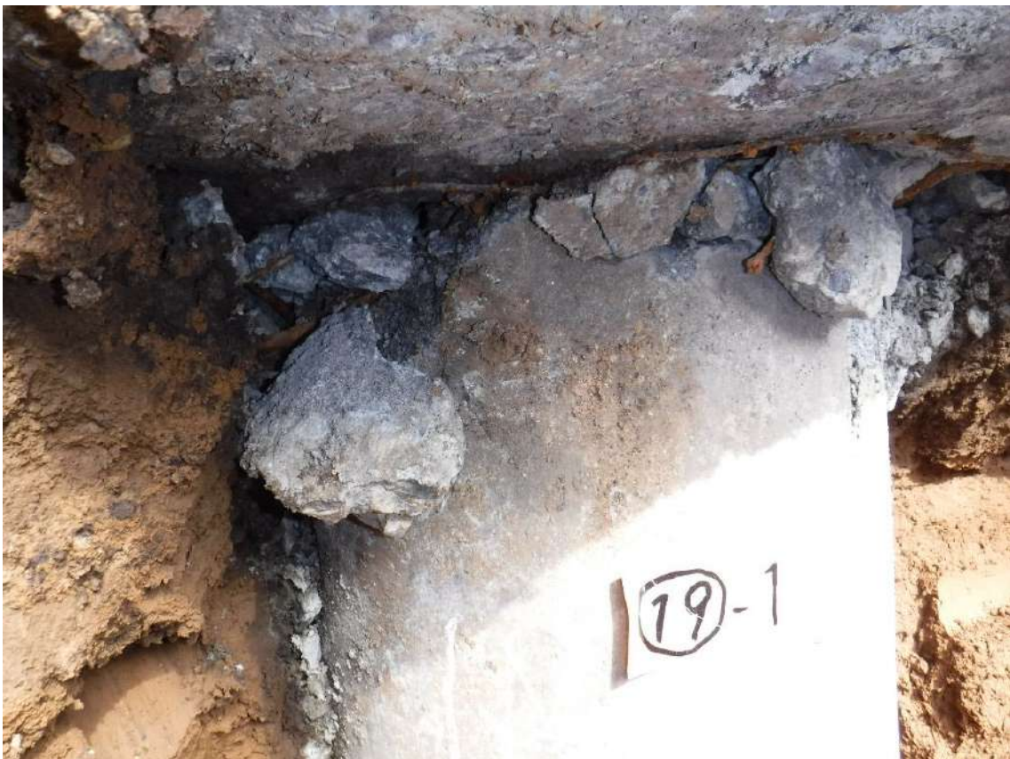
写真 7.4.2.50 杭⑲-1の杭頭部の状況
