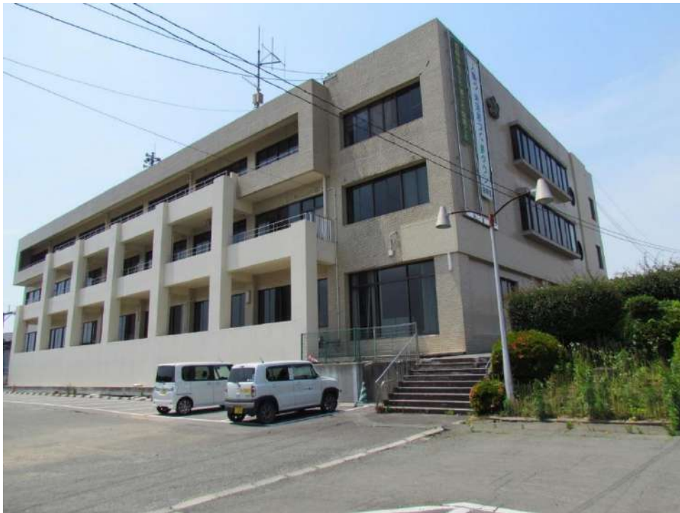
写真7.3.2.1 対象建築物南面
