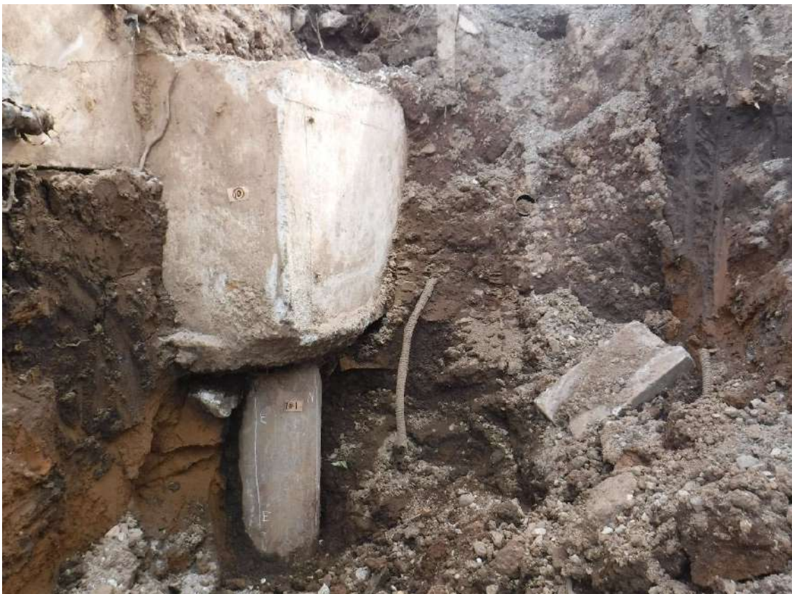
写真 7.4.2.14 基礎フーチング⑩周辺の状況
