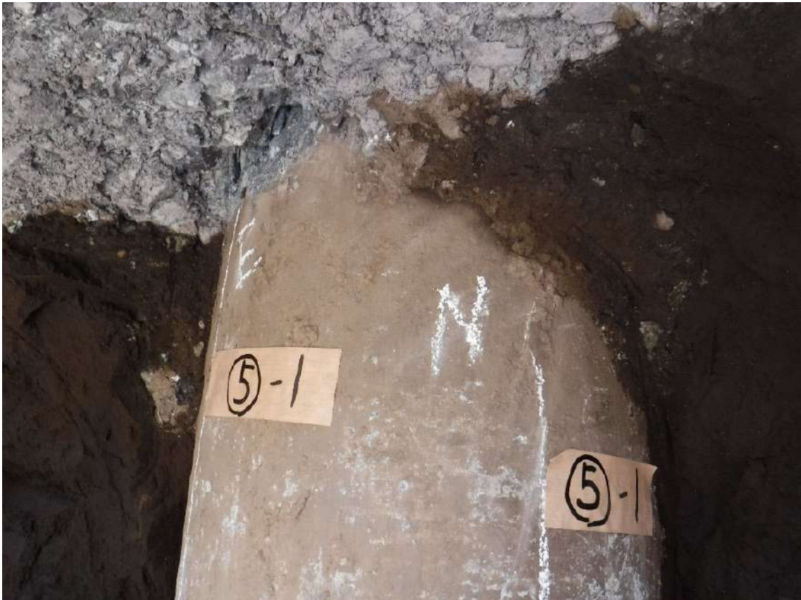
写真 7.4.2.29 杭⑤-1の杭頭部の状況
