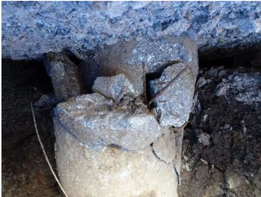
写真 7.4.2.1 No. 1 (X2-Y1) の杭頭部の状況
