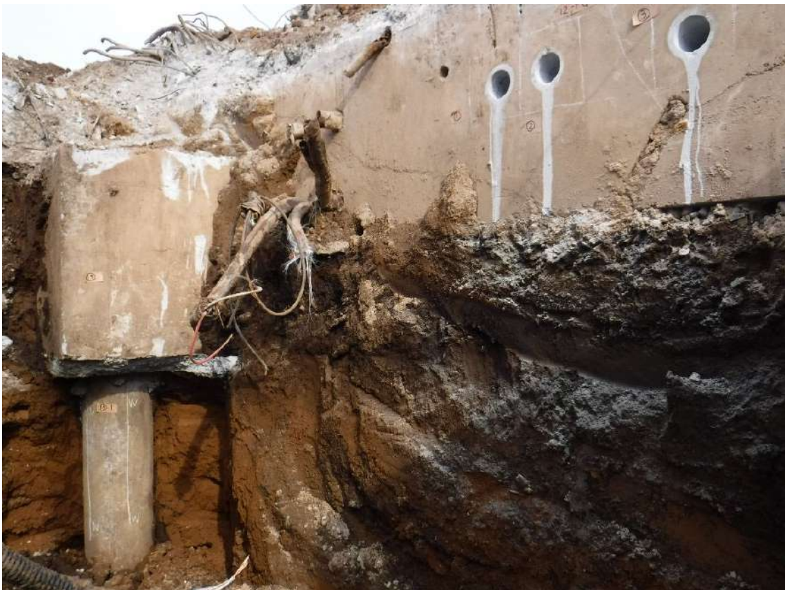
写真 7.4.2.22 基礎フーチング⑲周辺の状況
