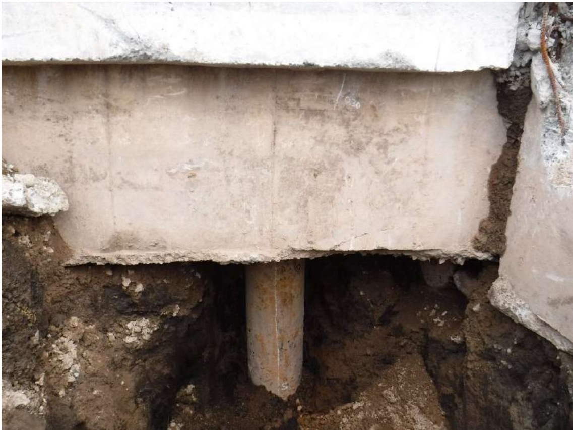
写真 7.4.2.17 基礎フーチング⑬周辺の状況
