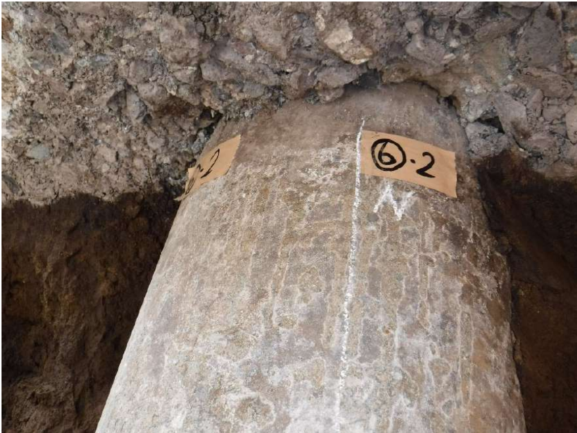
写真 7.4.2.31 杭⑥-2の杭頭部の状況
