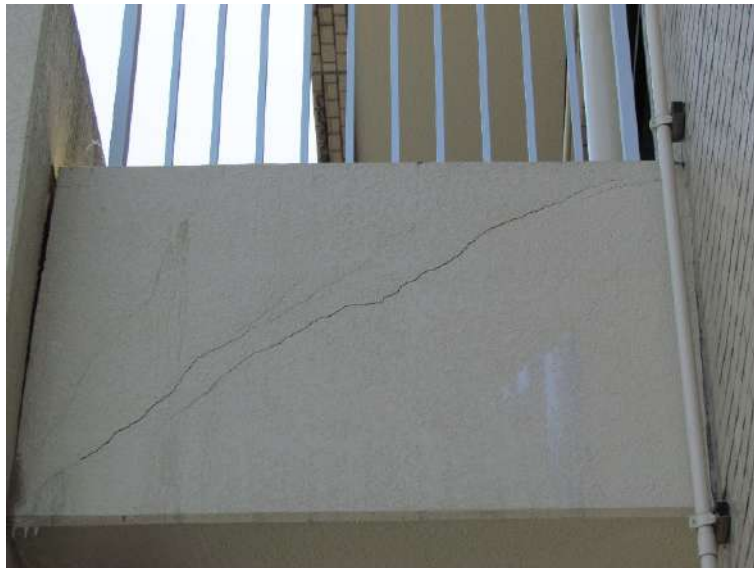
写真 7.4.1.4 境界梁の拡大写真
