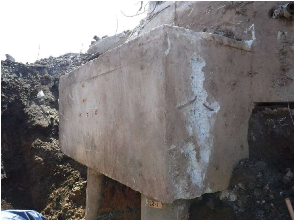
写真 7.4.2.16 基礎フーチング⑫周辺の状況
