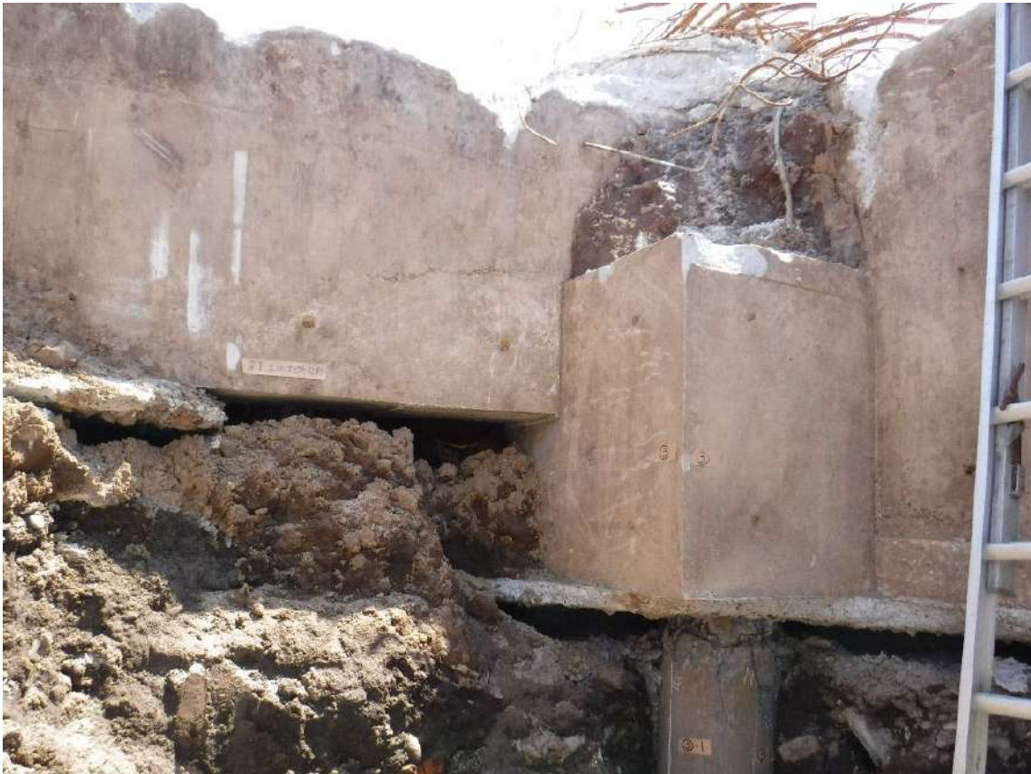
写真 7.4.2.5 基礎フーチング③周辺の状況
