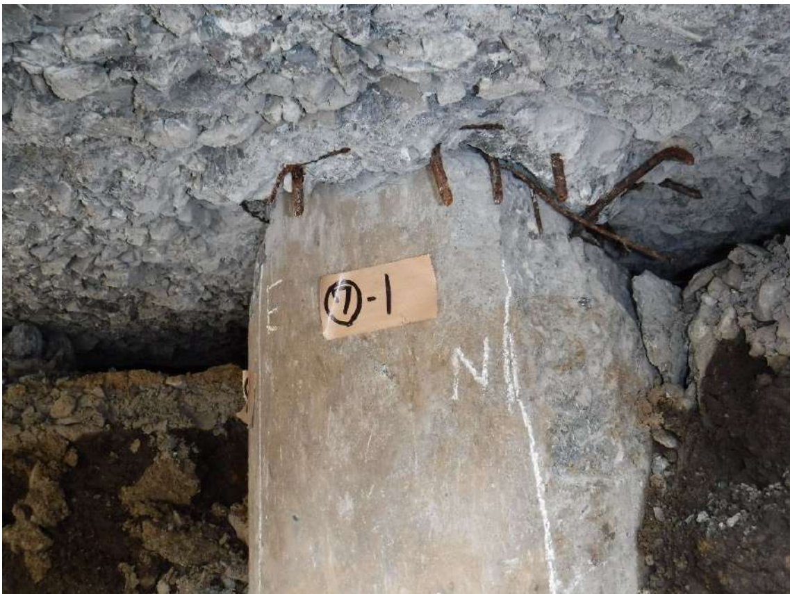
写真 7.4.2.32 杭⑦-1の杭頭部の状況
