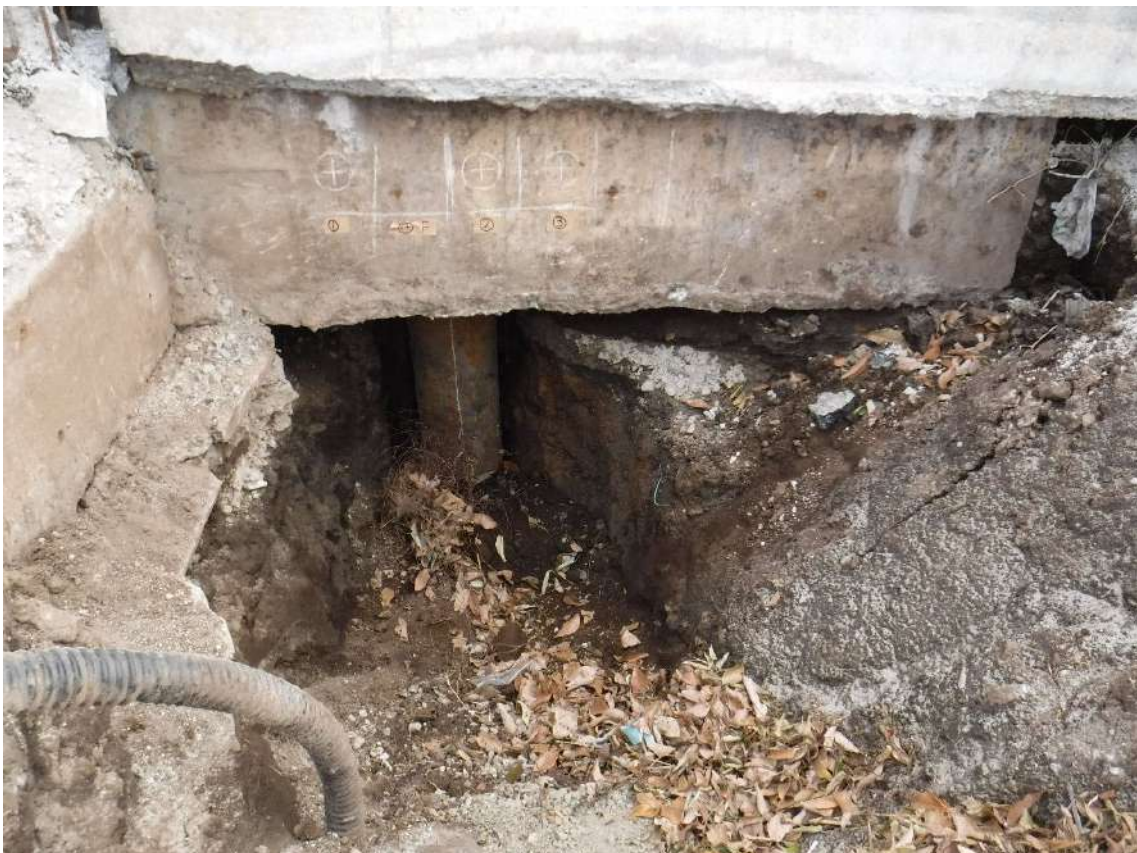
写真 7.4.2.18 基礎フーチング⑭周辺の状況
