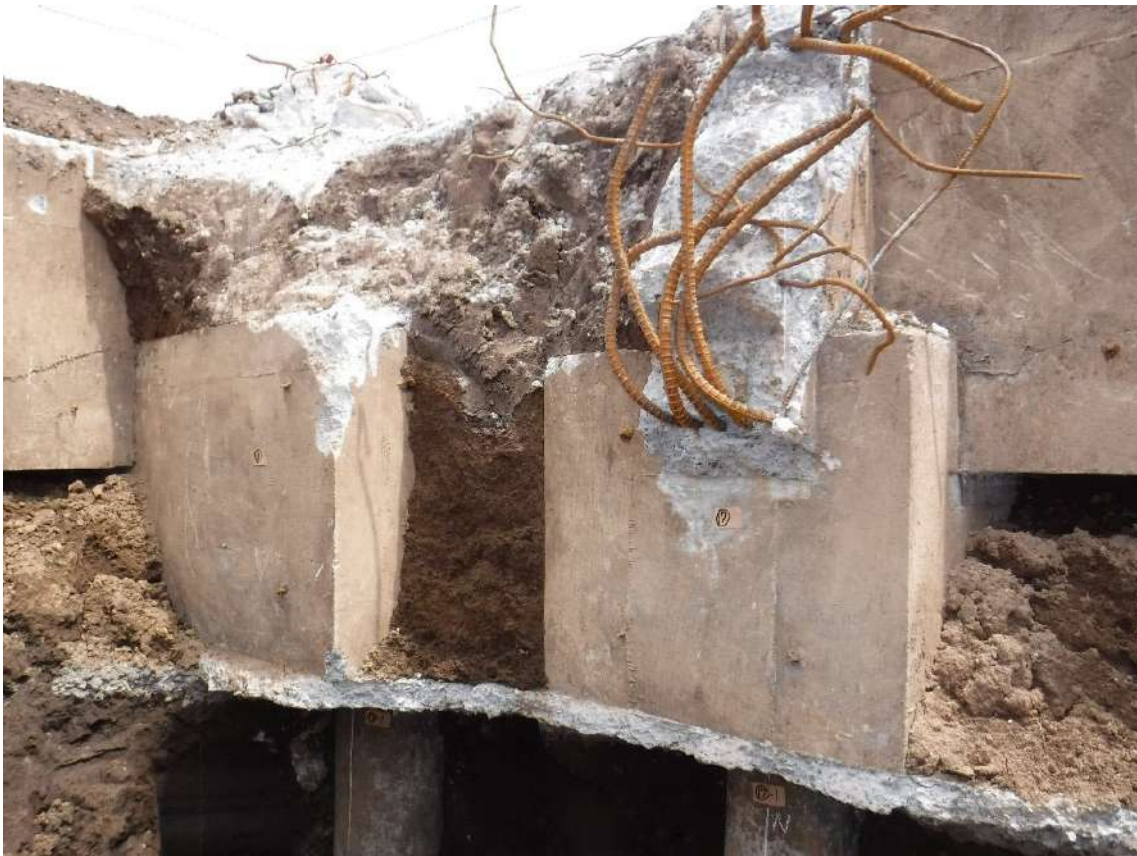
写真 7.4.2.21 基礎フーチング⑰および⑱周辺の状況
