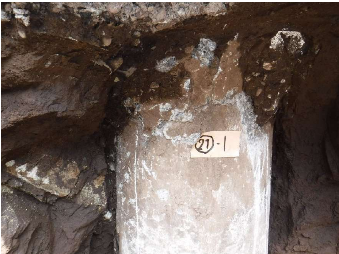
写真 7.4.2.52 杭㉑-1の杭頭部の状況
