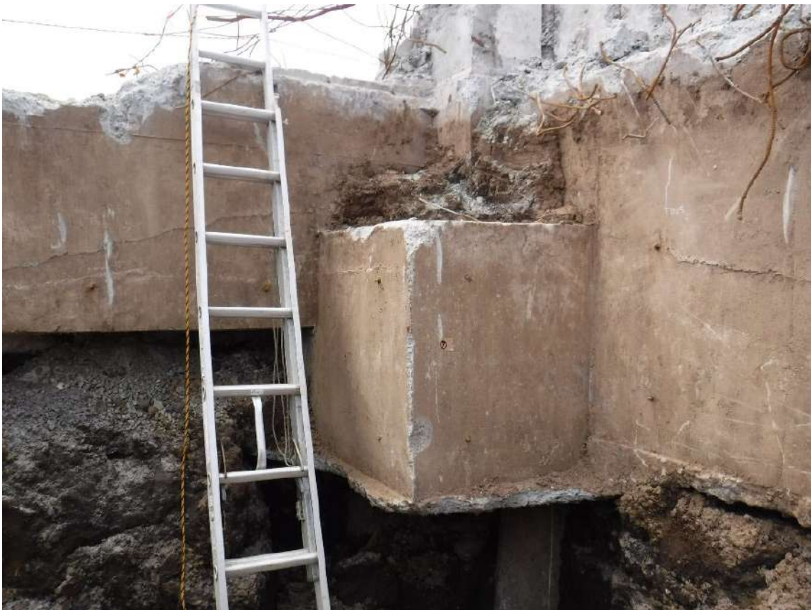
写真 7.4.2.10 基礎フーチング⑦周辺の状況
