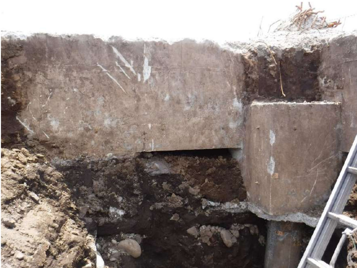
写真 7.4.2.6 基礎フーチング④周辺の状況
