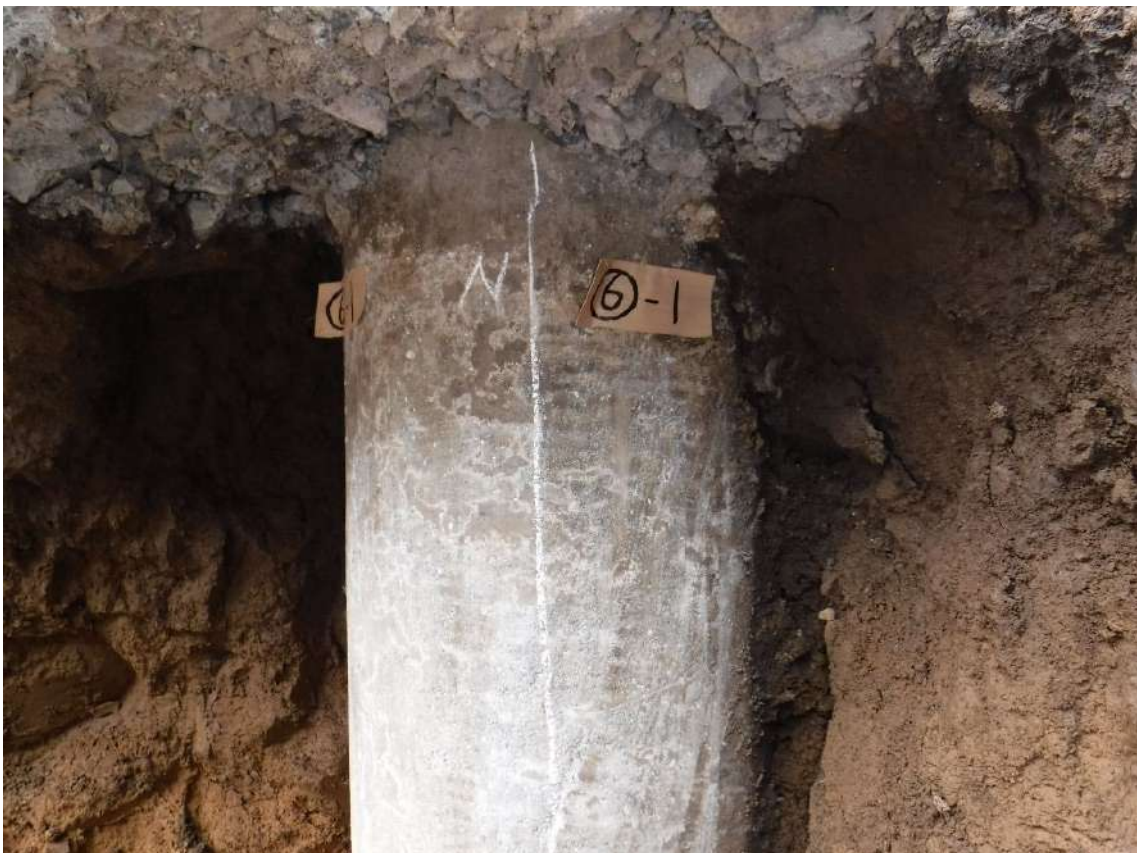
写真 7.4.2.30 杭⑥-1の杭頭部の状況
