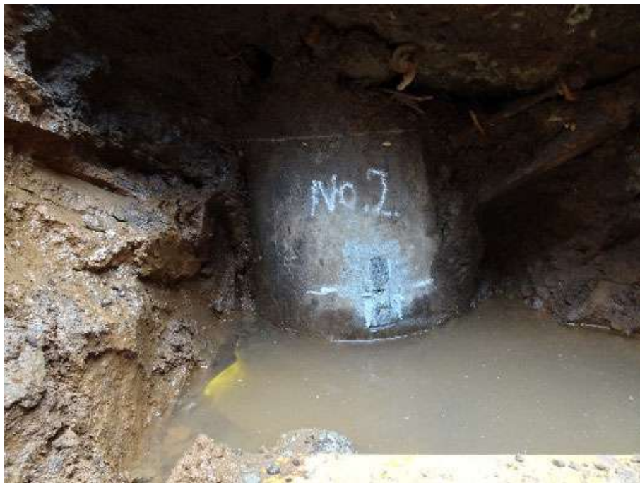
写真 7.4.2.2 No. 2 (X1-Y4) の杭頭部の状況
