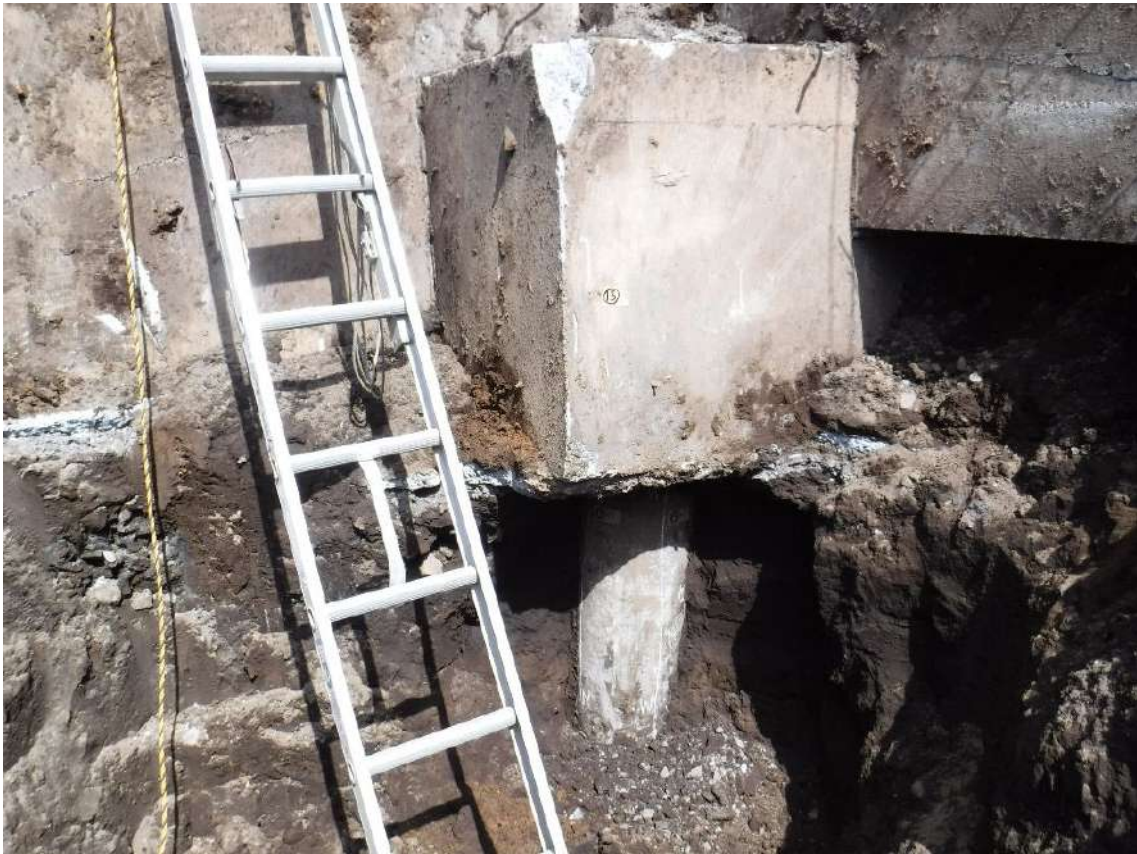
写真 7.4.2.19 基礎フーチング⑮周辺の状況
