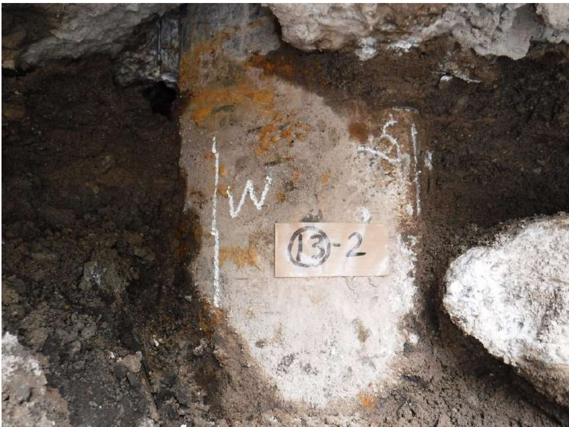
写真 7.4.2.42 杭⑬-2の杭頭部の状況
