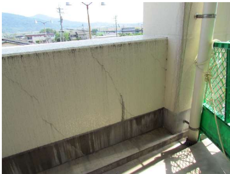
写真 7.4.1.7 損傷度 II の基礎梁
