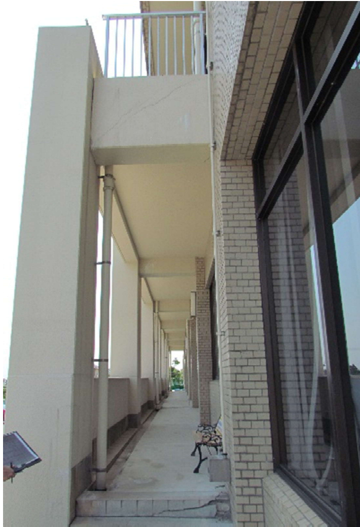
写真 7.4.1.3 外フレームと既存部の境界梁
