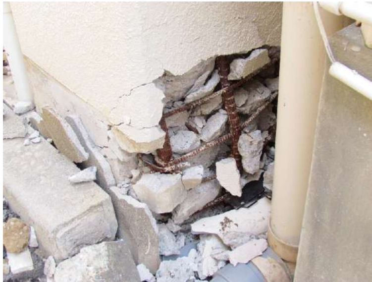
写真 7.4.1.11 渡り廊下棟の柱の柱脚
