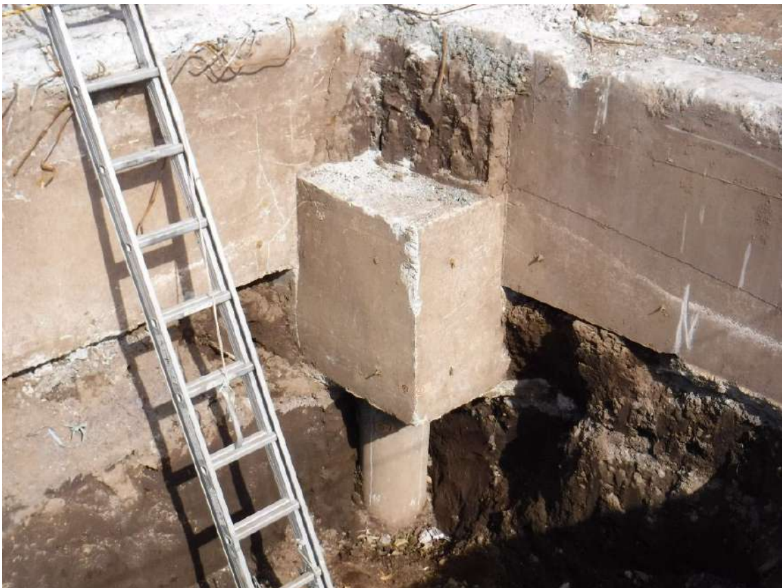
写真 7.4.2.4 基礎フーチング②周辺の状況
