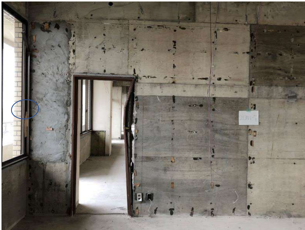
写真 7.4.1.15 2CW1-7 の部材写真
