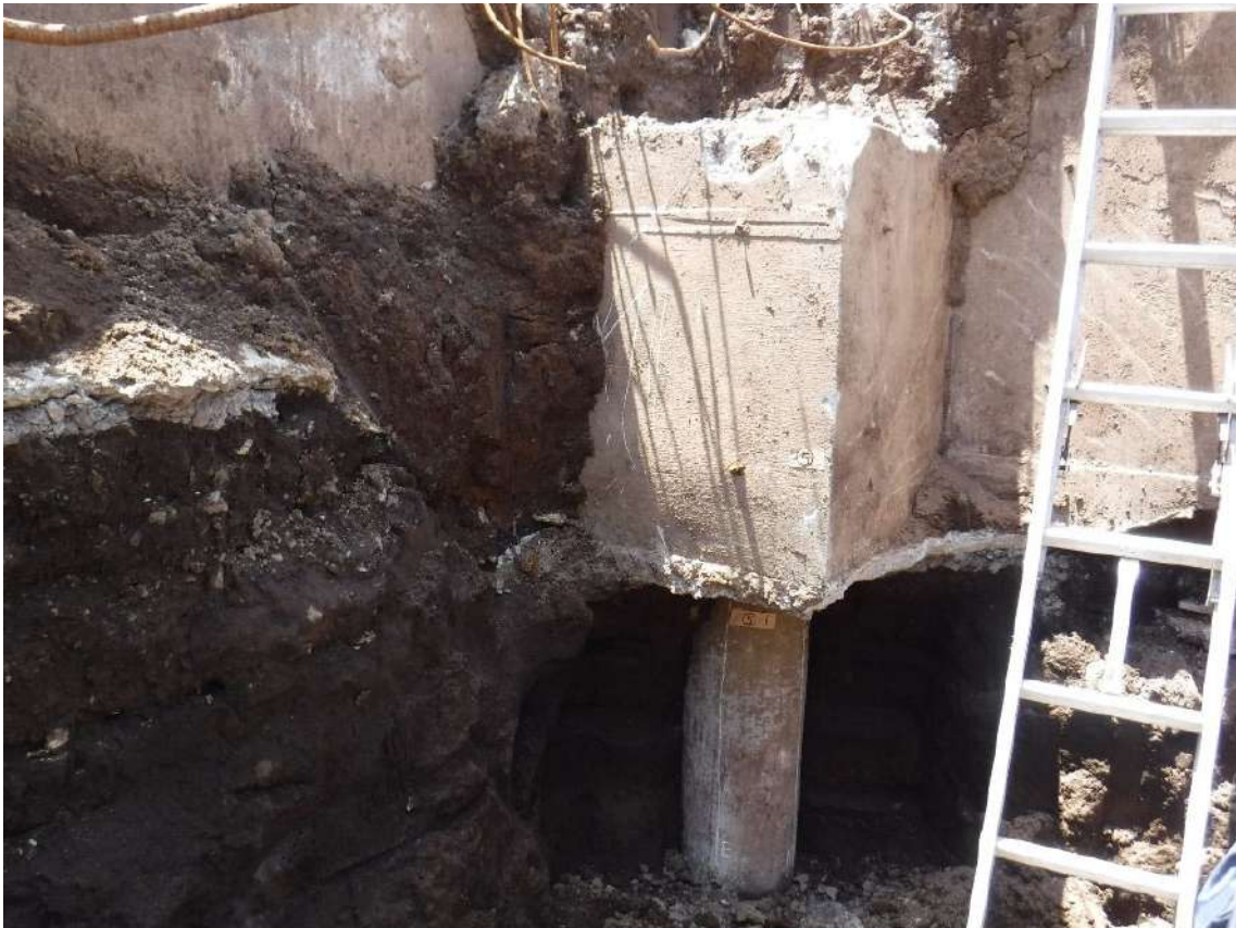
写真 7.4.2.7 基礎フーチング⑤周辺の状況
