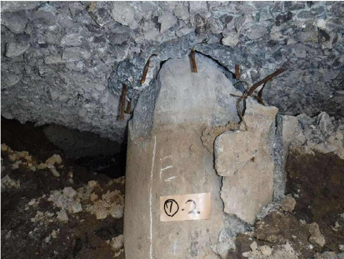
写真 7.4.2.33 杭⑦-2の杭頭部の状況
