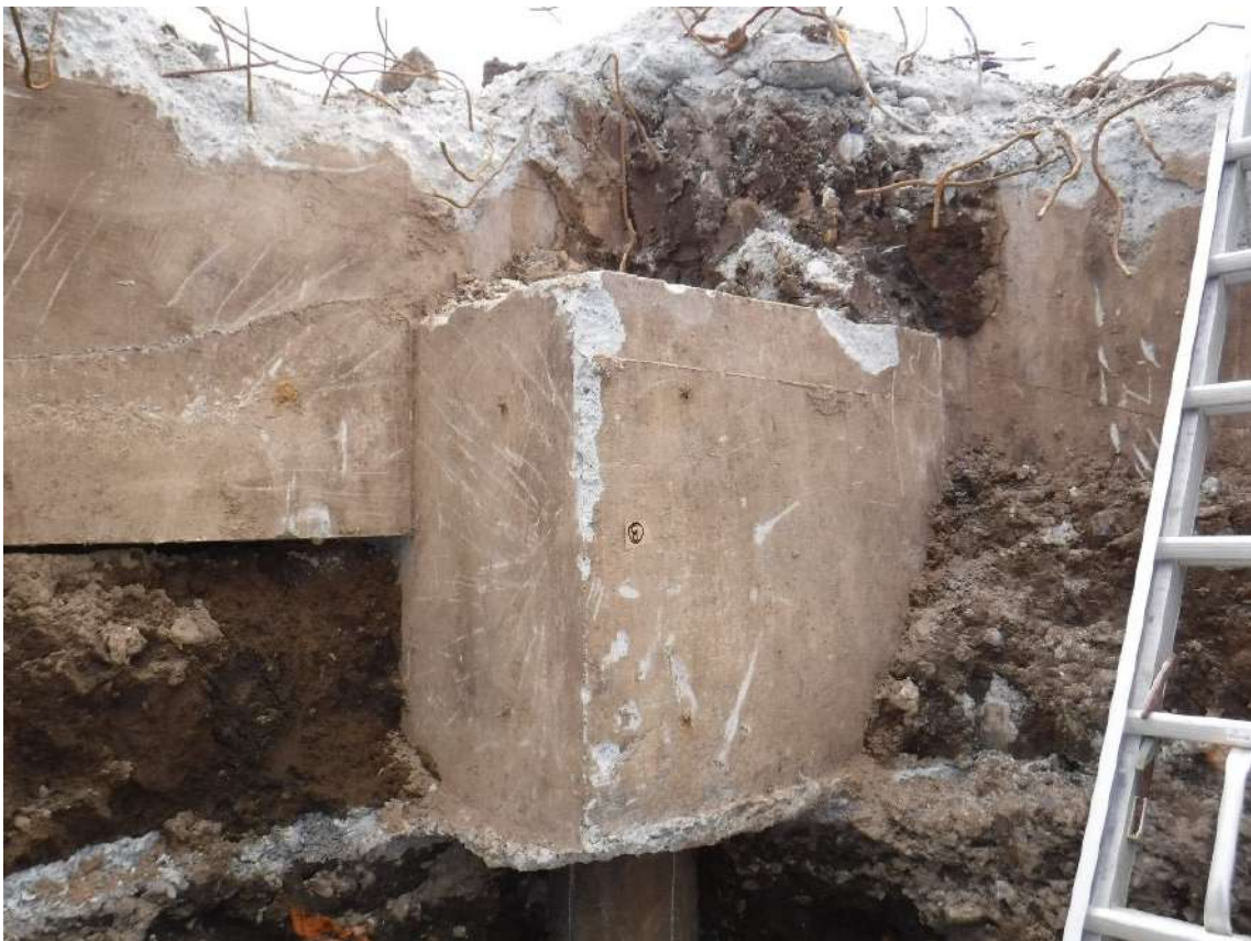
写真 7.4.2.12 基礎フーチング⑧周辺の状況
