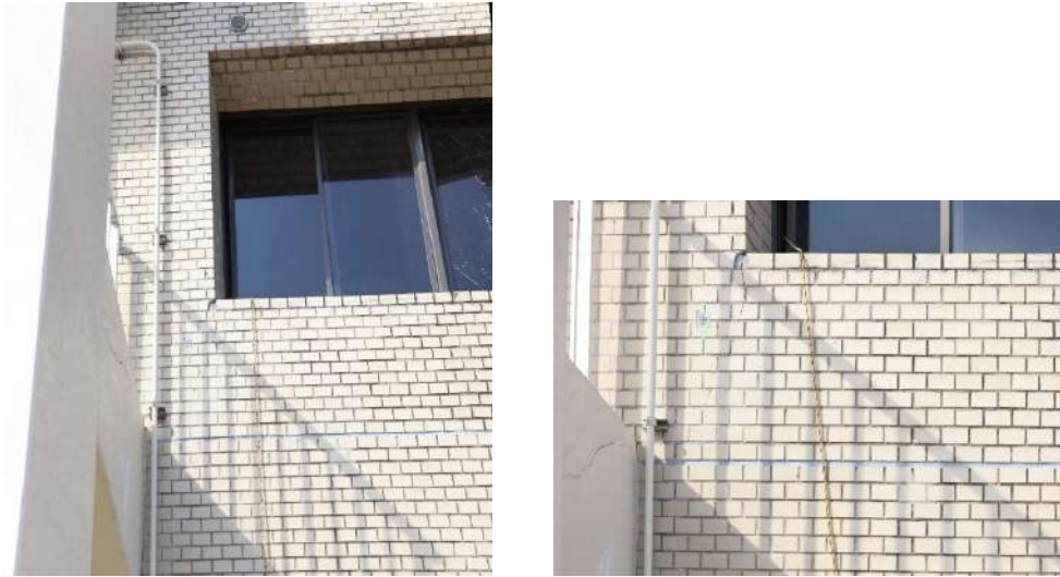
図 7.4.1.52 2階の撮影画像の比較
