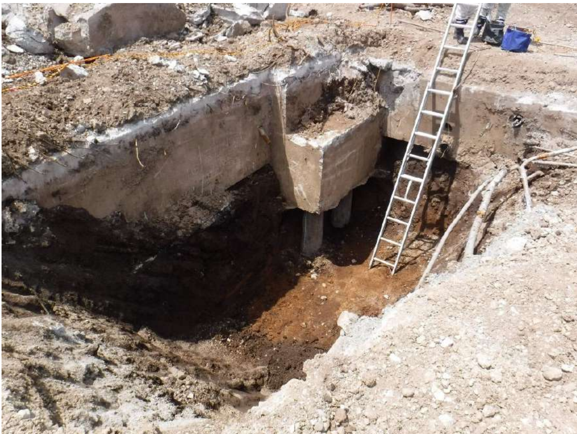
写真 7.4.2.8 基礎フーチング⑥周辺の状況
