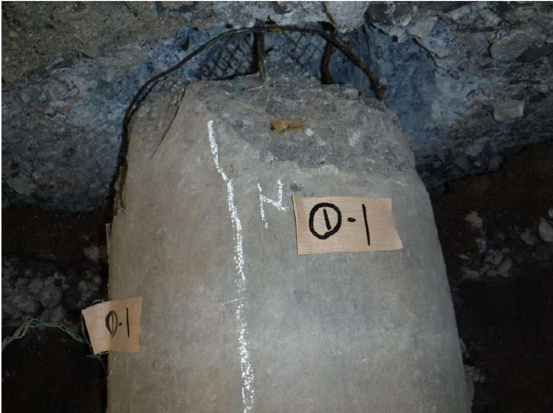
写真 7.4.2.24 杭①-1の杭頭部の状況
