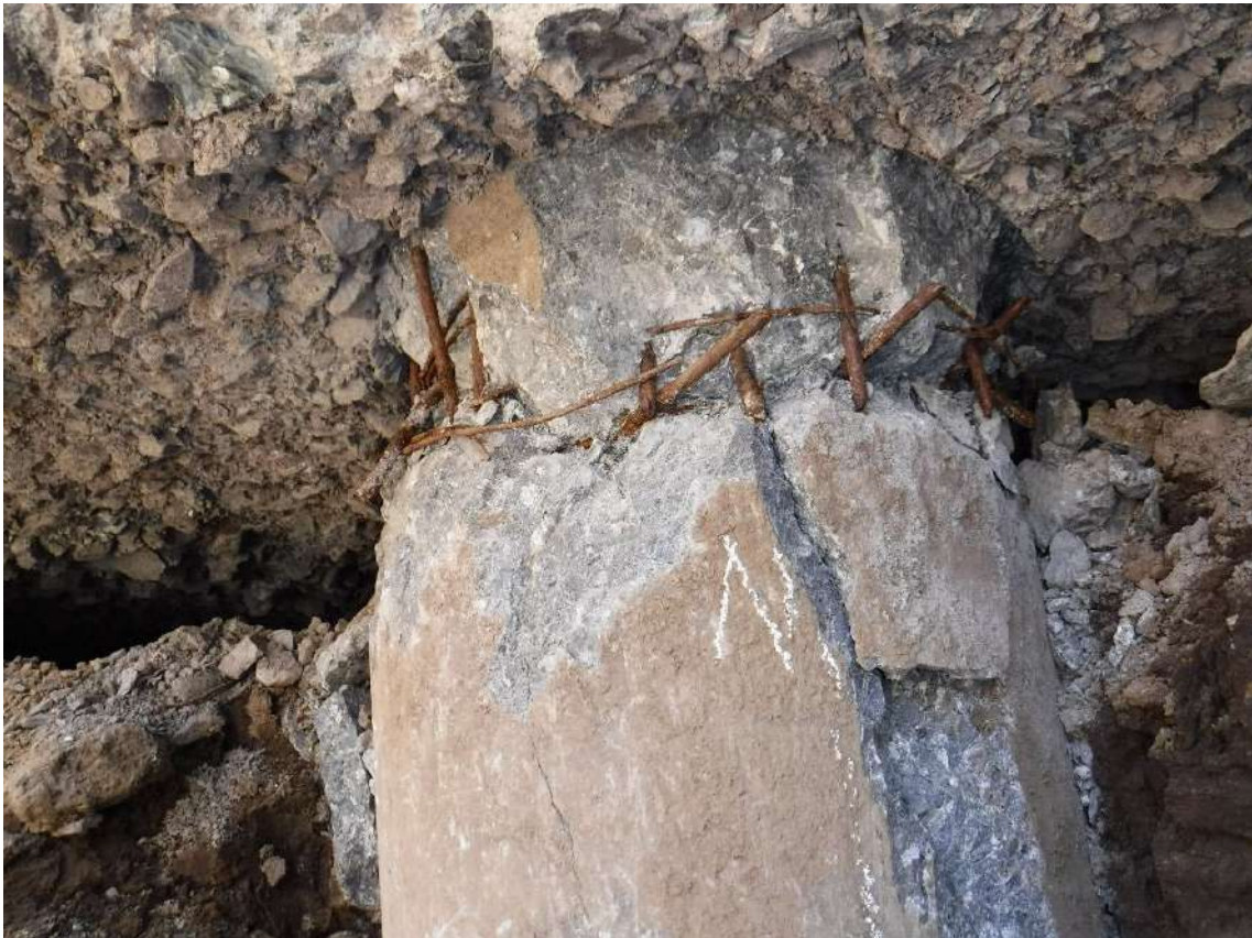
写真 7.4.2.27 杭③-1の杭頭部の状況
