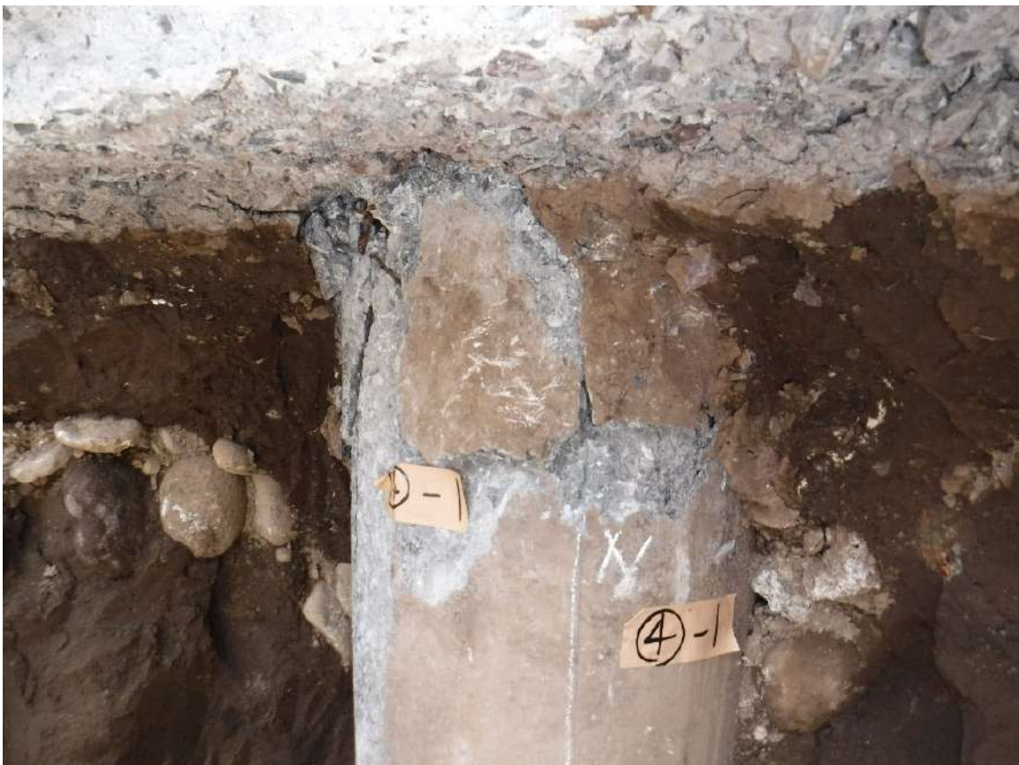
写真 7.4.2.28 杭④-1の杭頭部の状況
