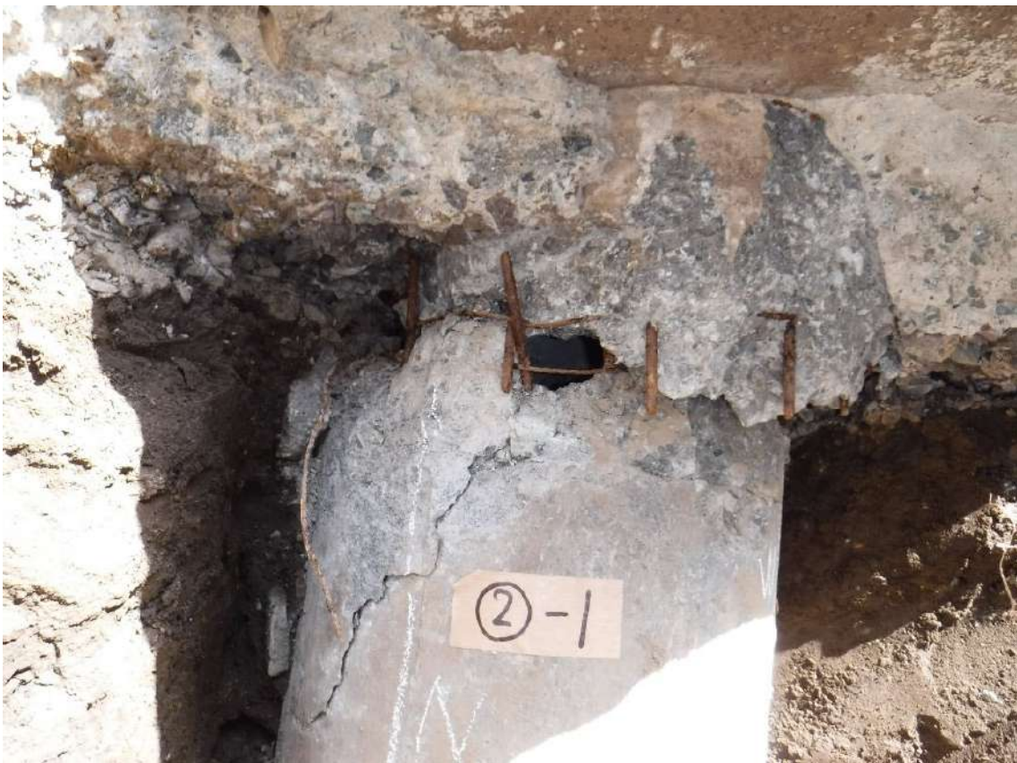
写真 7.4.2.26 杭②-1の杭頭部の状況
