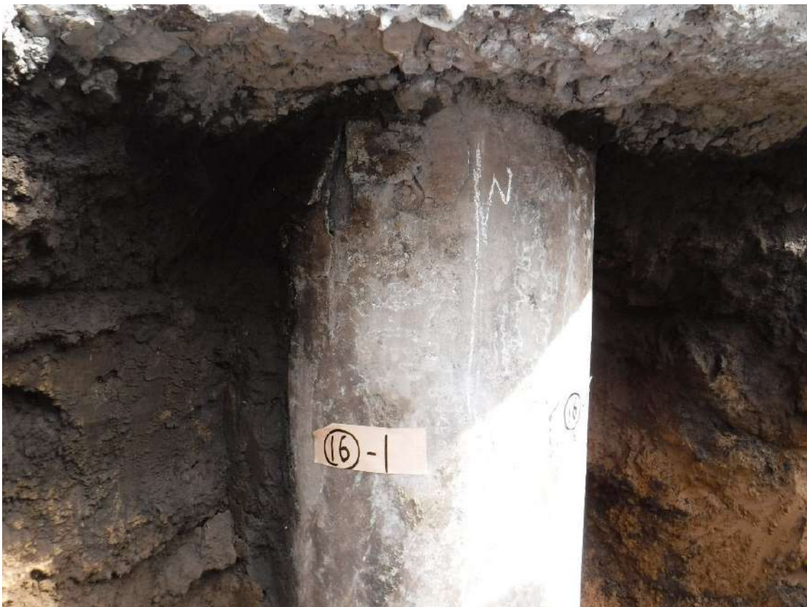
写真 7.4.2.46 杭⑯-1の杭頭部の状況
