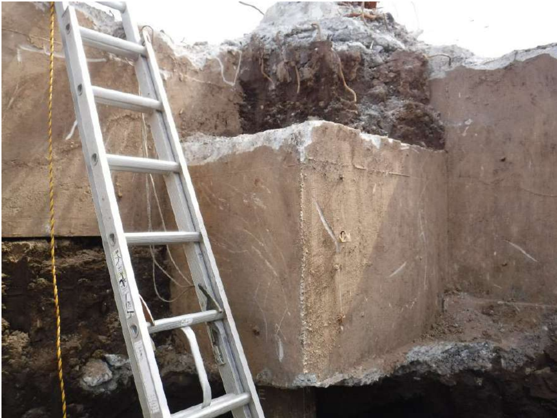
写真 7.4.2.15 基礎フーチング⑪周辺の状況
