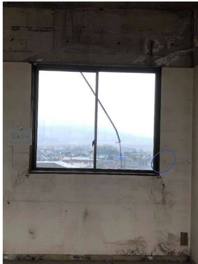
写真 7.4.1.16 3CW3-1 の部材写真
