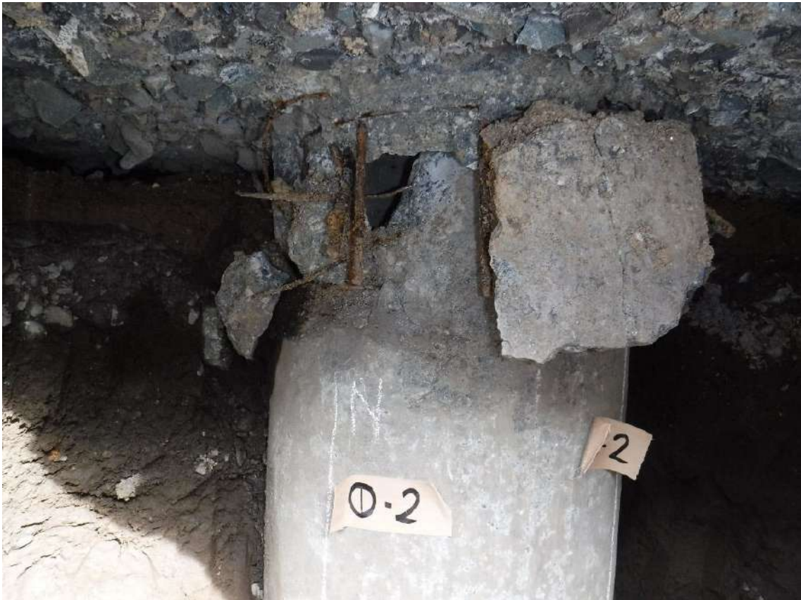
写真 7.4.2.25 杭①-2の杭頭部の状況
