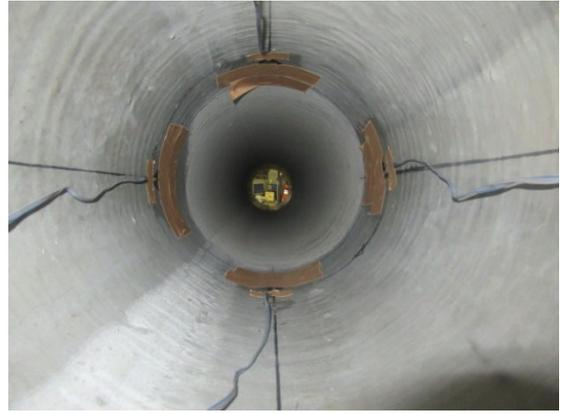
(b) 杭内面ひずみゲージ貼付け状況
