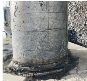
写真 3.3.10-2 鋼管除去後 (C-1 南面)
