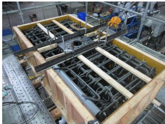
(f) 軸方向鉄筋の端板設置状況
