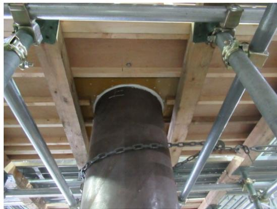
(b) 上スタブ型枠の漏れ防止処理状況
