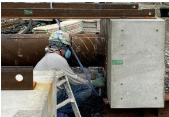
写真 3.3.9-1 鋼管剥がし作業
