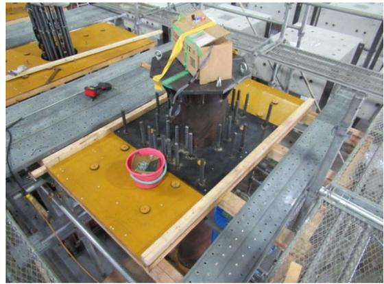
(b) 上スタブの型枠及び補強板設置状況
