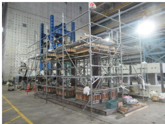
写真 3. 2. 6-7 鉄筋組及び型枠組完了
