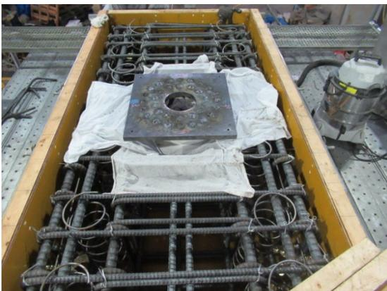
(g) 軸方向鉄筋の端板溶接完了
