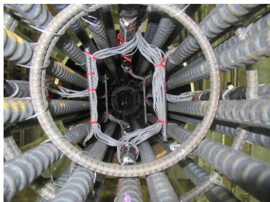
(h) 軸方向鉄筋内側リード線避け状況
