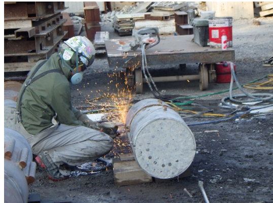
(b) 鋼管剥がし作業
