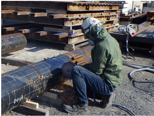
(a) 杭切断作業
