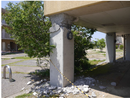
(a) 共同住宅 A (宇土市, 1998 年建設)
