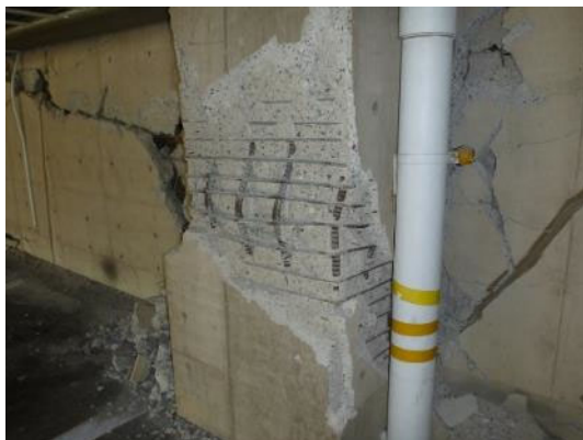
(c) 共同住宅 D (熊本市東区, 1992 年建設)
