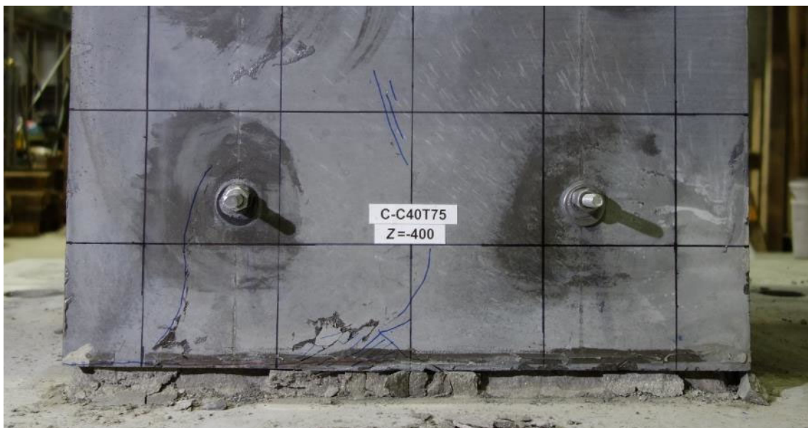
(c) 正面柱脚目地部の圧壊および正面パネルの損傷状況
