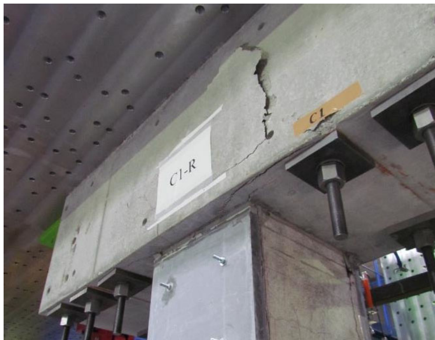
(d) 試験体正面南西方向からの写真 UFC パネル突き上げによるスタブコンクリートの破壊 図 3.3.1-5 損傷状況
