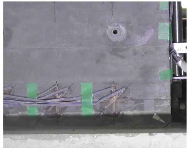
南面 (柱脚付近)
