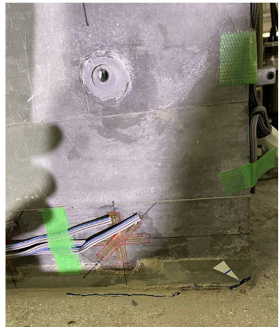
南面 (柱脚付近)
