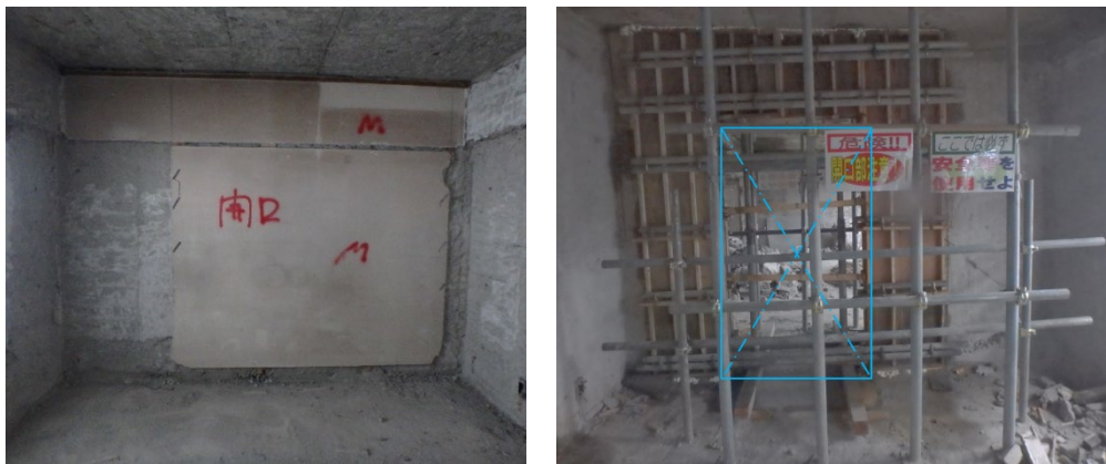
(b)壁開口施工状況（左：施工前、右：施工中）
