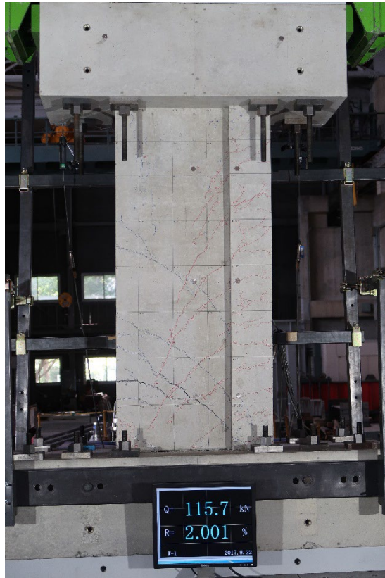
写真 5.2.4-25 R=1/50 損傷写真
