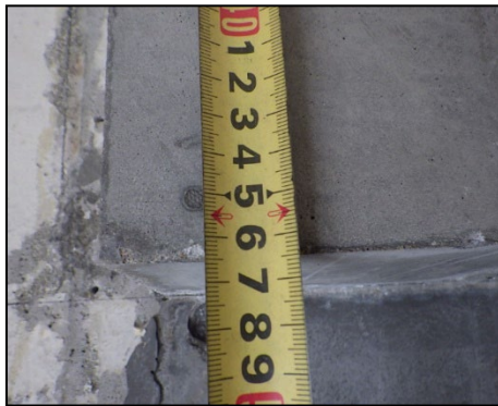
写真 8.2.2-51 外付け梁せいの確認, 201号室側
