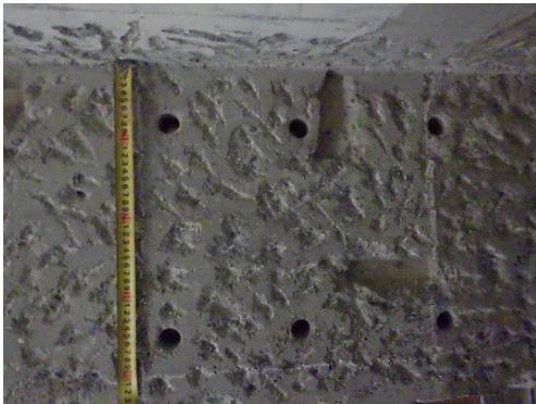
写真 8.2.2-13 補強梁用目荒らしの状況
