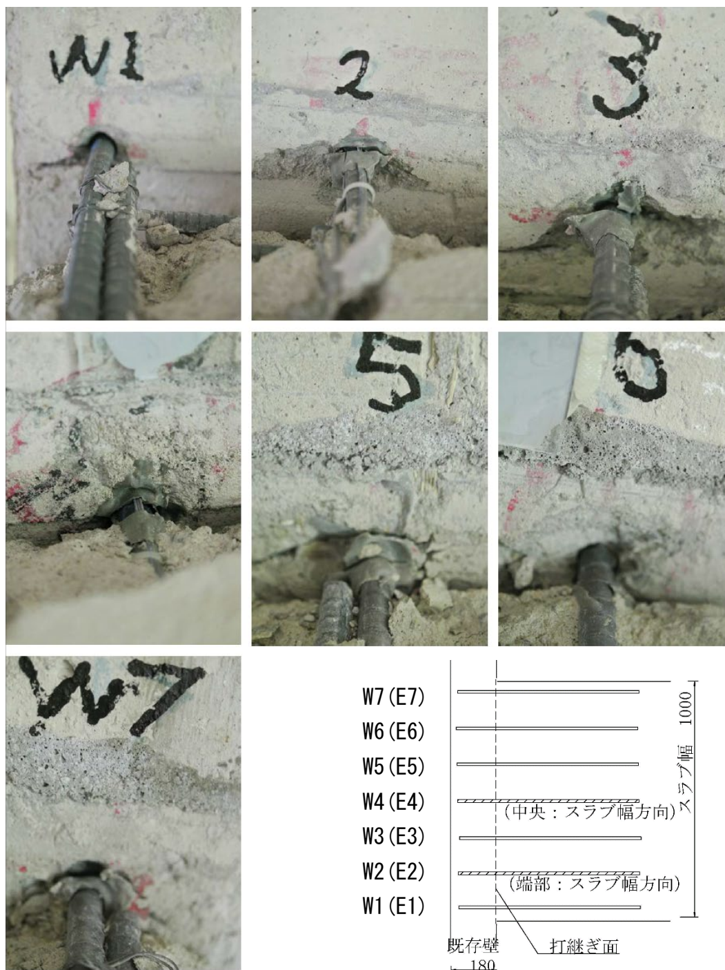
写真3.3.6-5 終局曲げ実験後のあと施工アンカー孔口の状況（階段側壁）
