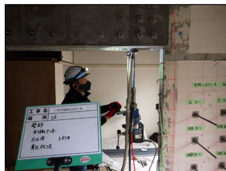
写真 8.2.2-36 穿孔作業（上向き）
