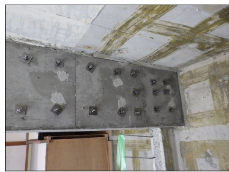
写真 8.2.2-32 補強梁コンクリート打設後
