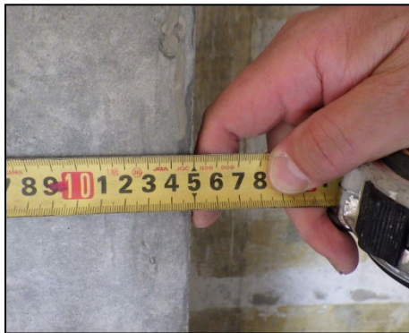
写真 8.2.2-63 北側補強壁柱厚さの確認
