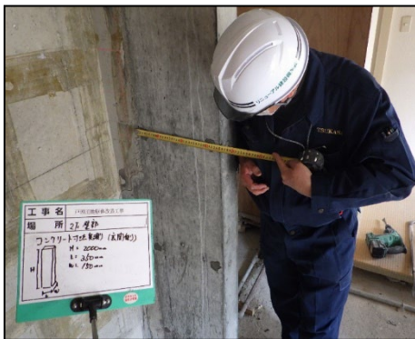
写真 8.2.2-58 北側補強壁柱の長さ確認
