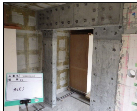
写真 8.2.2-40 壁柱補強部配筋
