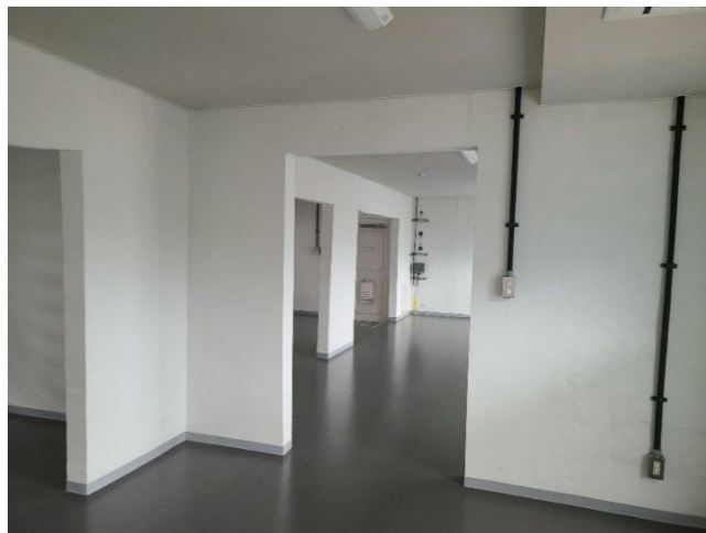
(c)壁開口施工状況(完成例)
