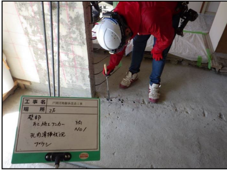
写真 8.3.2-4 孔内清掃状況
