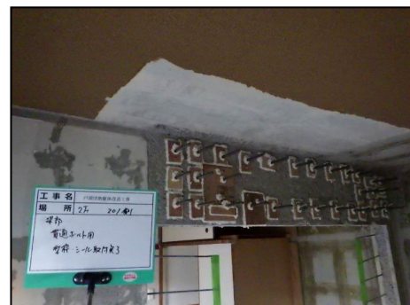
写真 8.2.2-20 型枠内シール充填状況
