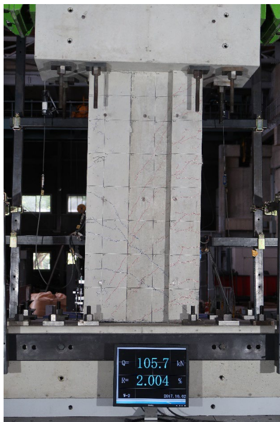
写真 5.2.4-53 R=1/50 損傷写真
