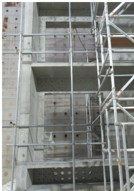
写真 8.2.1-8 横筋はつり出し
