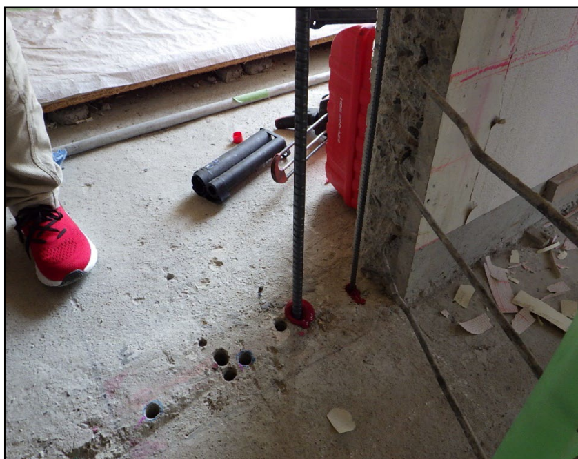
写真 8.3.2-32 あと施工アンカー挿入後樹脂充填状況，下向き No.1
