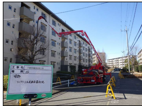
写真 8.2.2-28 コンクリート圧送状況
