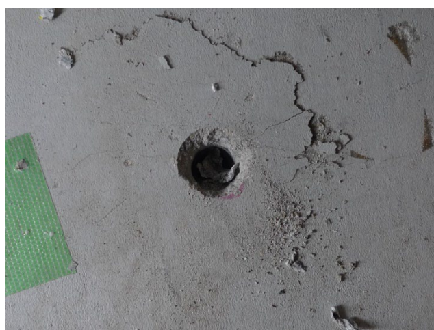
写真 5.3.5-3 穿孔した c の引き抜き試験後の状況
