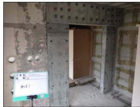
写真 8.2.2-44 壁柱補強部グラウト脱型後
