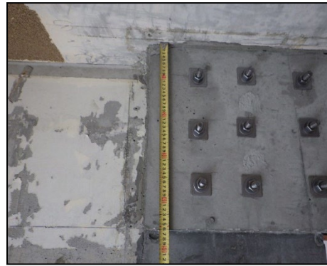
写真 8.2.2-50 外付け梁せいの確認, 201号室側
