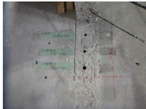
写真 8.2.1-5 穿孔後の状況
