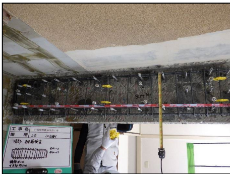
写真 8.2.2-23 補強梁配筋状況
