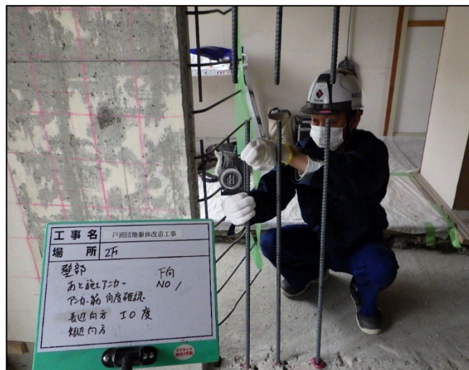
写真 8.3.2-11 アンカー筋の角度測定の状態
