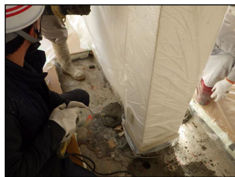
写真 8.2.2-30 コンクリート打設状況
