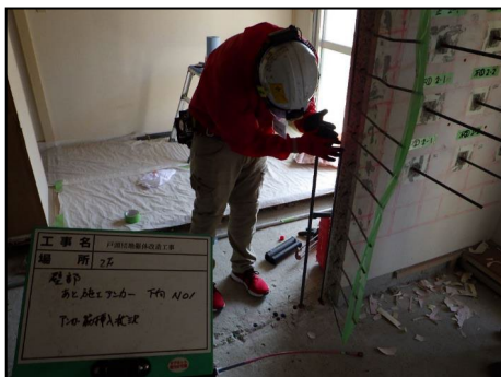
写真 8.2.2-37 あと施工アンカー挿入作業（下向き）
