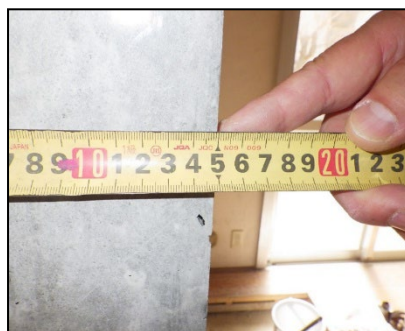
写真 8.2.2-69 北側補強壁柱厚さの確認
