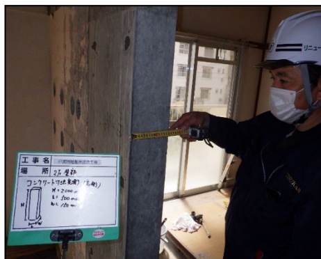
写真 8.2.2-67 南側補強壁柱厚さの確認
