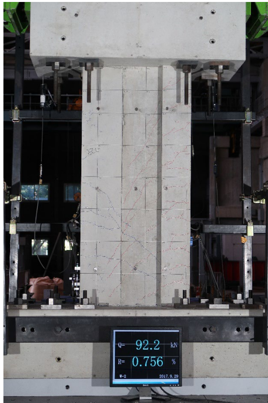
写真 5.2.4-43 R=1/133②損傷写真
