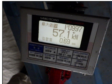
写真 8.3.2-16 あと施工アンカー施工 後試験，上向き引張試験結果 (第三者機関による確認) (実測荷重 57.1kN，変位 0.69mm)
