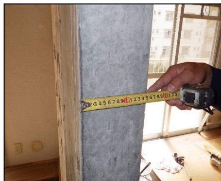
写真 8.2.2-68 北側補強壁柱厚さの確認
