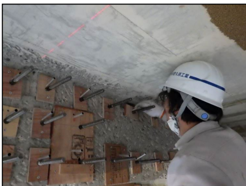
写真 8.2.2-19 型枠内通し筋設置状況
