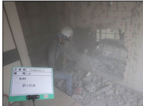
写真 8.2.2-8 開口部はつり状況
