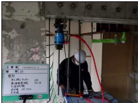
写真 8.3.2-15 あと施工アンカー施工後 試験，引張試験 (第三者機関による確認) (設計荷重 55.4kN)
