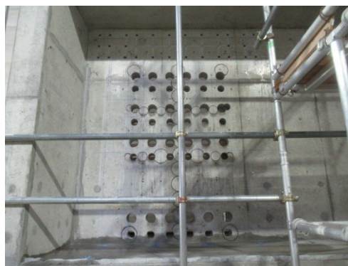
写真 8.2.1-4 コアボーリング後
