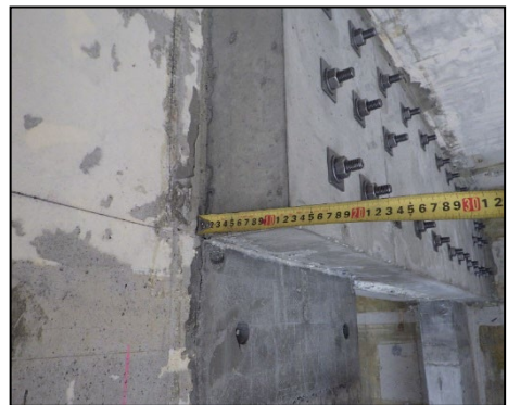
写真 8.2.2-53 外付け梁幅の確認, 201号室側
