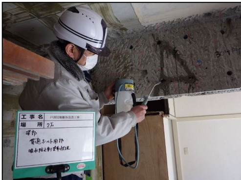
写真 8.2.2-15 通し筋用吸水防止剤の塗布
