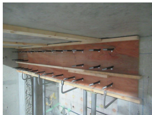
写真 8.2.1-12 グラウト注入用型枠
