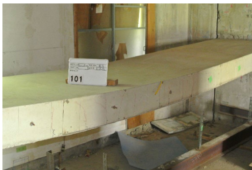
写真 1.3-1 実構造物の新設スラブ
