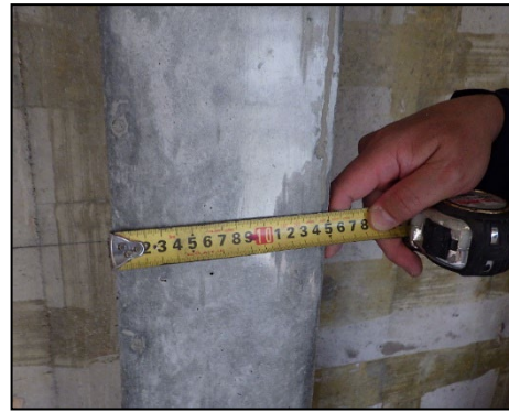
写真 8.2.2-62 北側補強壁柱厚さの確認
