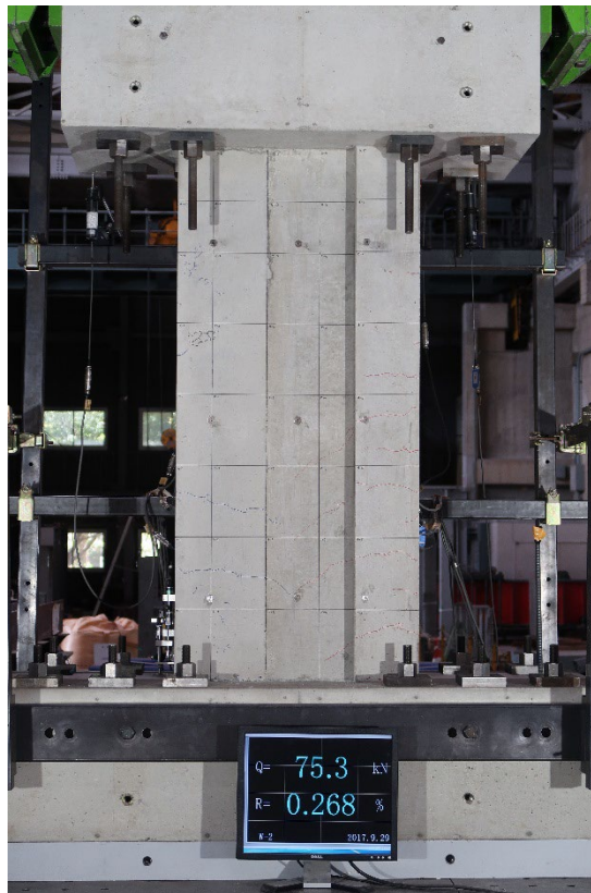
写真 5.2.4-35 R=1/400②損傷写真
