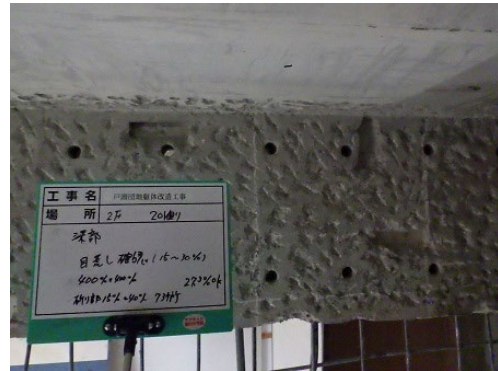
写真 8.2.2-14 補強梁目荒らしの程度確認
