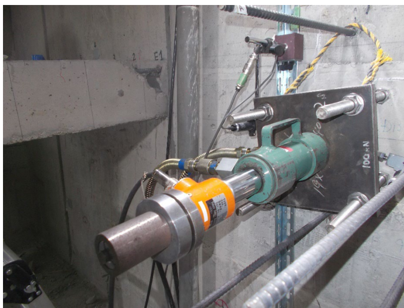
写真 3.3.5-2 引抜き試験装置
