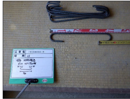
写真 8.2.2-22 補強梁用縦筋寸法確認
