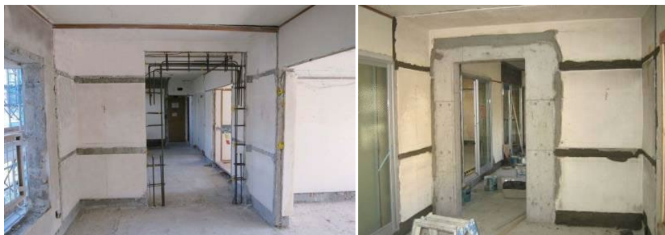
(a) 壁開口新設概要
