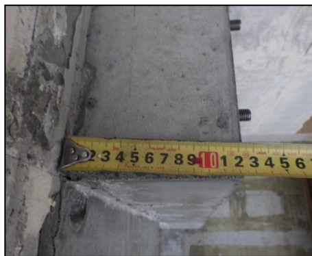
写真 8.2.2-54 外付け梁幅の確認, 201号室側
