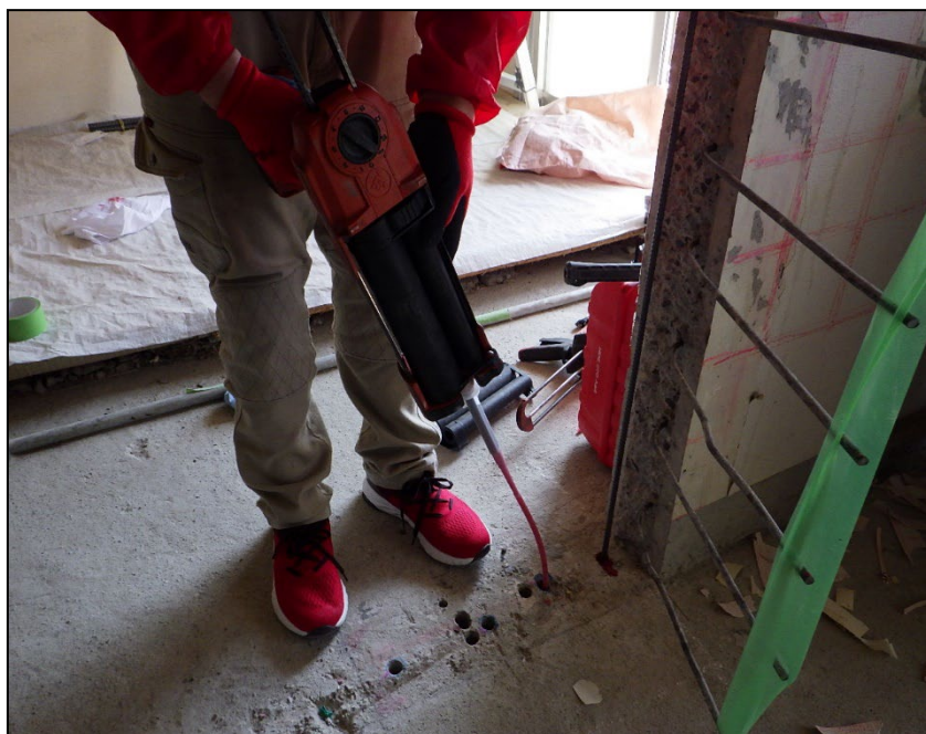
写真 8.3.2-31 あと施工アンカー施工樹脂充填状況，下向き No.1
