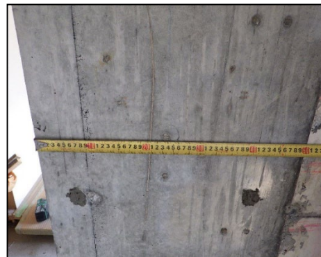
写真 8.2.2-65 北側補強壁柱の長さ確認
