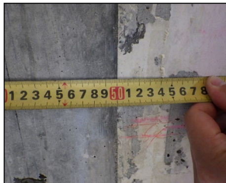
写真 8.2.2-66 北側補強壁柱の長さ確認
