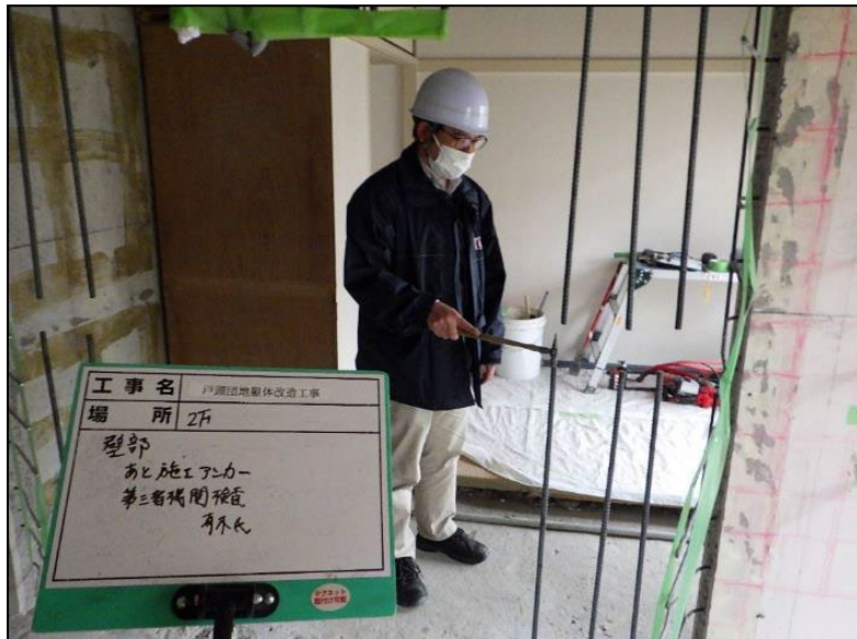
写真 8.3.2-12 あと施工アンカー施工後試験，打音検査
