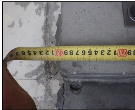
写真 8.2.2-57 外付け梁長さの確認, 201号室側
