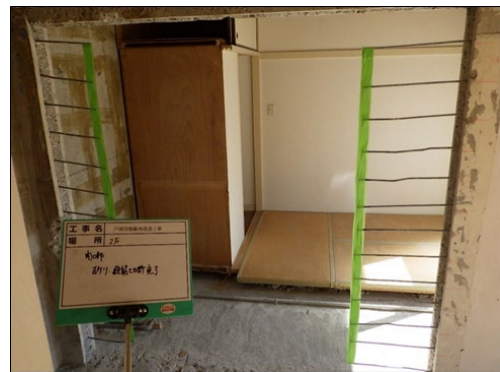
写真 8.2.2-10 開口部鉄筋切断・養生
