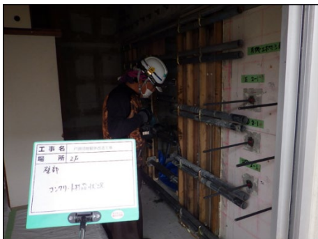
写真 8.2.2-41 壁柱補強部 コンクリート打設状況
