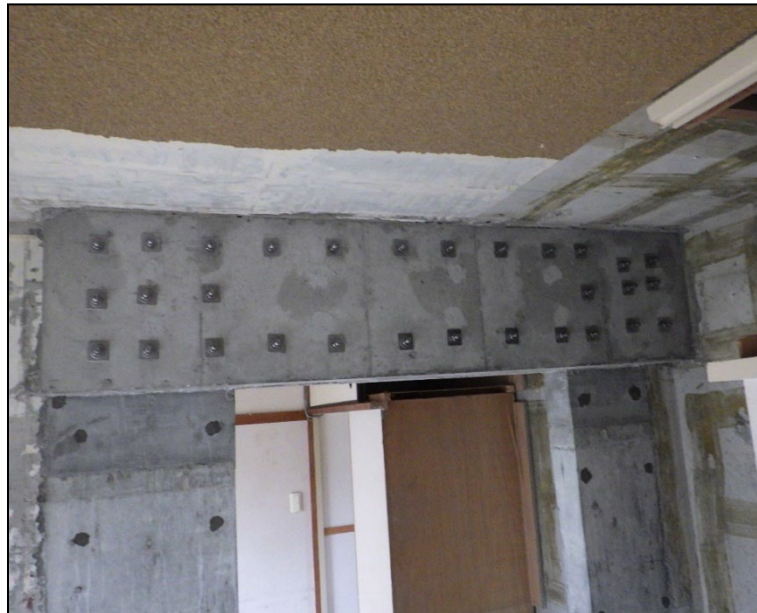
写真 8.2.2-46 躯体改造試験施工完了状況，外付け梁，201号室側
