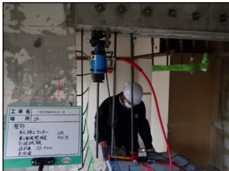
写真 8.3.2-19 あと施工アンカー施工後試験，引張試験 (第三者機関による確認) (設計荷重 55.4kN)
