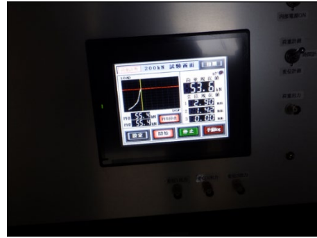
写真 8.3.2-14 あと施工アンカー施工 後試験，引張試験結果（ 第三者機関による確認） (実測荷重 55.4kN)
