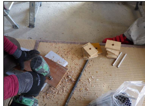
写真 8.2.2-16 通し筋固定用型枠制作状況
