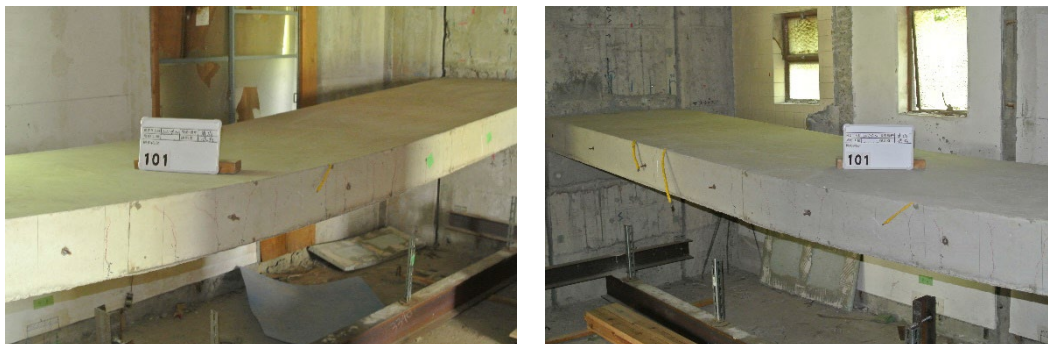
写真 3.3.6-2 101号室 最終破壊状況
