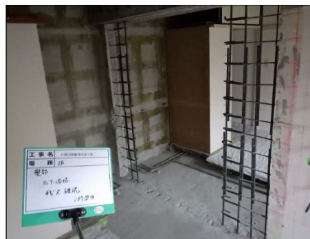
写真 8.2.2-40 壁柱補強部配筋
