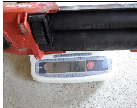
写真 8.3.2-24 樹脂測確認状況,近景 2階壁脚, No1 注入後, 3.15kg
