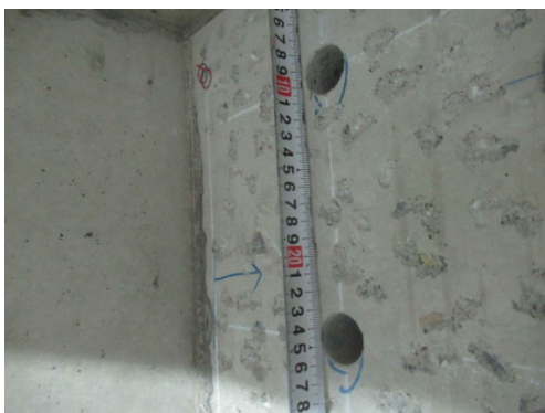
写真 8.2.1-11 通し筋コア抜き位置
