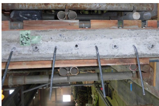
写真 5.3.1-1 既存部の目荒らし状況
