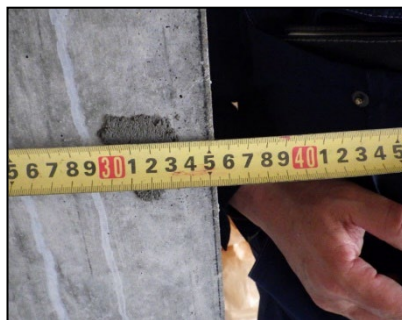
写真 8.2.2-60 北側補強壁柱の長さ確認
