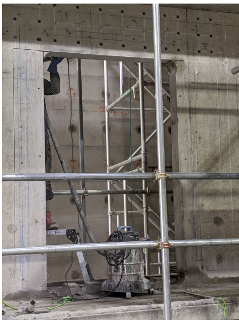
写真 8.2.1-7 新設開口部切り出し
