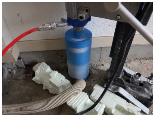
写真 8.2.2-3 コンクリート打設孔の穿孔 (3階スラブ)
