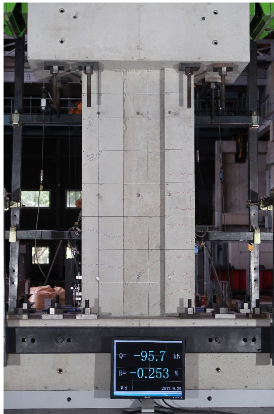
写真 5.2.4-34 R=-1/400 損傷写真
