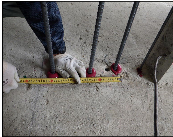
図 8.3.2-10 接着材の充填状況の確認(目視検査)
