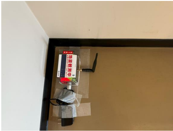
写真 4. 4-9 強震計設置状況 (WJMC4 : 南東側屋上、Sonas No.5)
