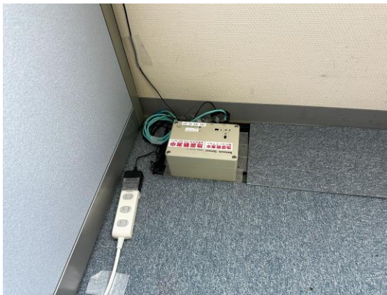
写真 4.4-14 強震計設置状況 (WJMF3 : 南側1階、CV374_147)
