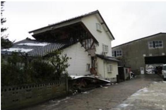
写真5. 2. 2-64 1層が崩壊した3階建て木造住宅
