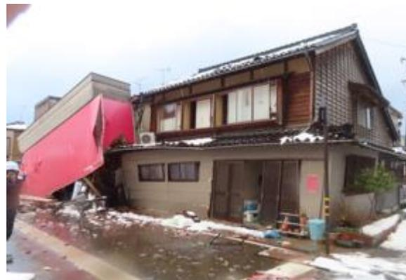
写真5. 2. 2-65 倒壊した木造店舗併用住宅
