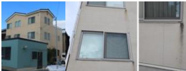
写真5.2.2-84 珠洲市野々江町の3階建枠組壁工法住宅の開口周囲のひび割れ
