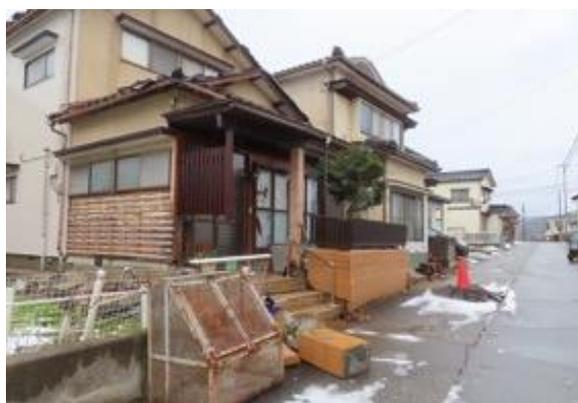
写真 5. 2. 2-68 外壁が剥落した木造住宅
