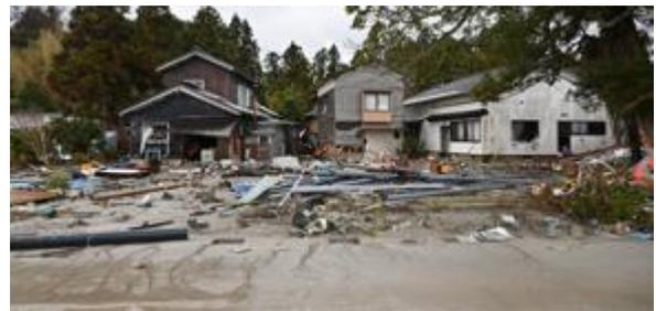
写真5. 2. 2-71 津波により流失した木造住宅1
