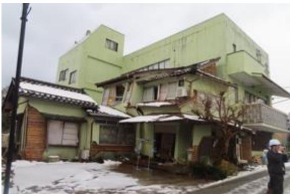
写真5. 2. 2-62 2階が損傷した木造住宅
