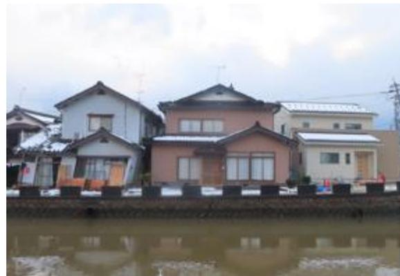
写真5. 2. 2-63 大きく傾斜した木造住宅
