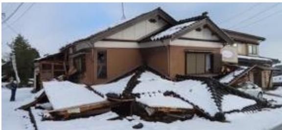
写真5.2.2-48 1層が崩壊した木造住宅
