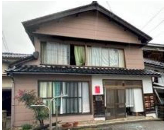
写真5.2.2-59 残留変形がある家屋(穴水町大町)
