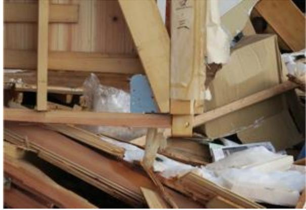
写真5.2.2-45 写真5.2.2-44の筋かい端部の金物
