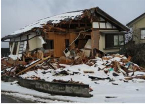
写真5.2.2-44 倒壊した木造住宅
