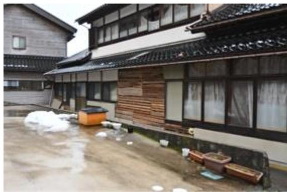
写真5.2.2-75 外壁の剥落した木造住宅
