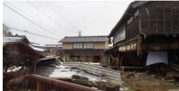
写真5. 2. 2-73 津波により倒壊した木造住宅
