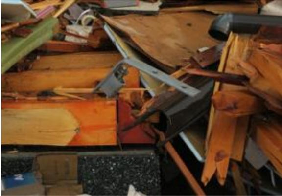
写真5.2.2-46 写真5.2.2-44のホールダウン金物
