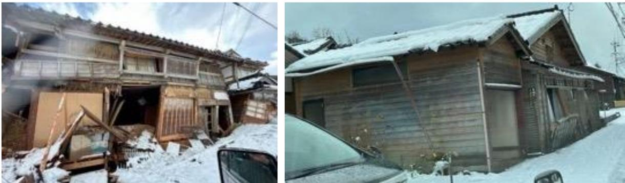
写真5. 2. 2-26 一部は安全限界変形を超えるような大きな残留変形がある家屋（門前町黒島）
