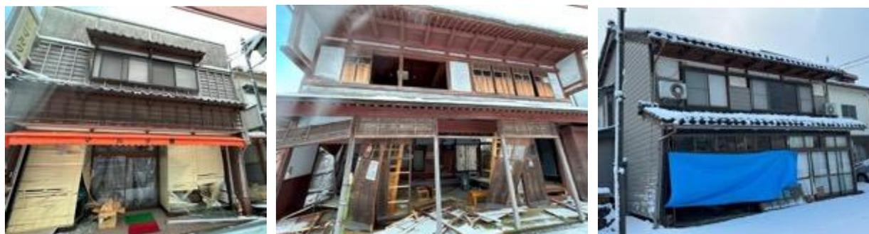
写真5.2.2-14 一部は安全限界変形を超える大きな残留変形のある家屋（門前町門前）
