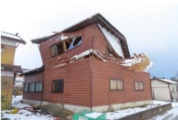
写真5.2.2-50 2層が崩壊した木造住宅
