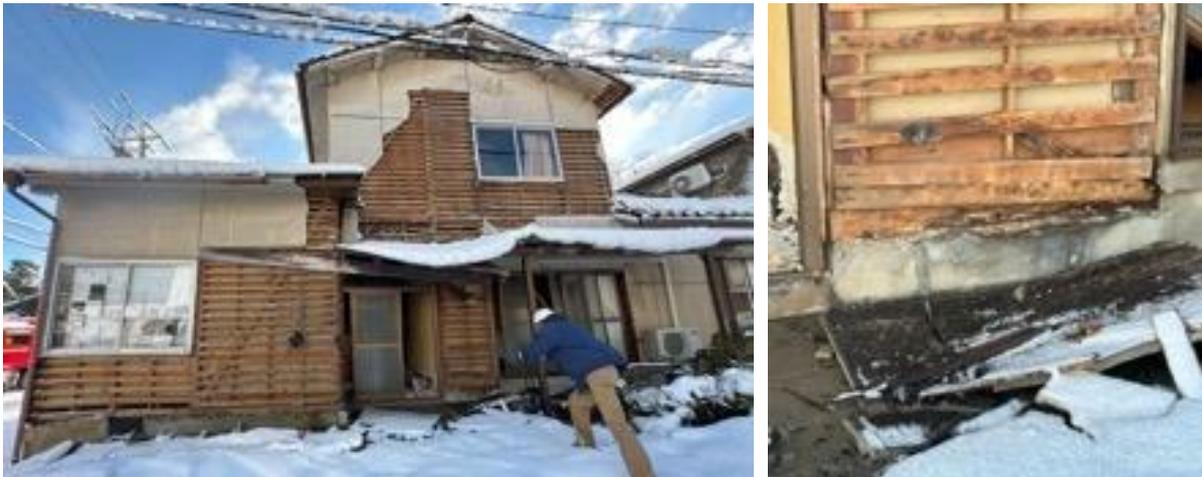
写真5.2.2-17 モルタル外壁が大規模に剥落した住宅とその土台の腐朽
