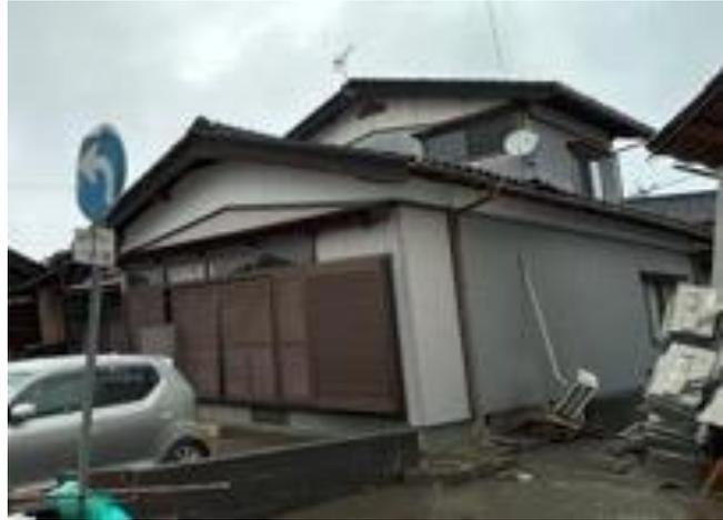
写真5. 2. 2-40 比較的建築年が古い割に被害が軽微な木造家屋
