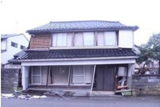
写真5.2.2-82 大きく傾斜した木造住宅
