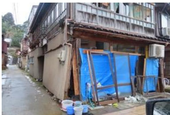
写真 5. 2. 2-69 大きく傾斜した木造店舗併用住宅
