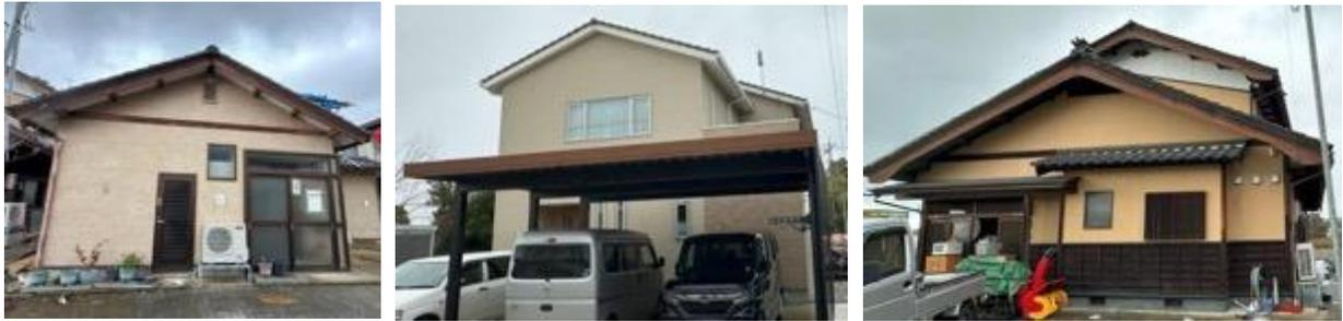
写真5. 2. 2-35 新耐震基準施行後の建築とみられる無被害又は被害軽微の家屋
