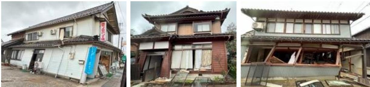
写真5. 2. 2-34 珠洲市正院町正院で一部は安全限界変形を超える大きな残留変形が残る家屋
