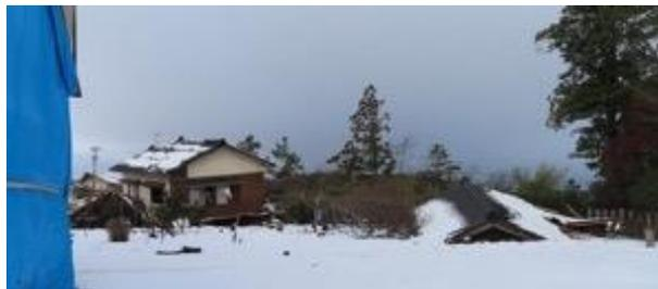
写真5.2.2-49 1層が崩壊した木造住宅と倉庫
