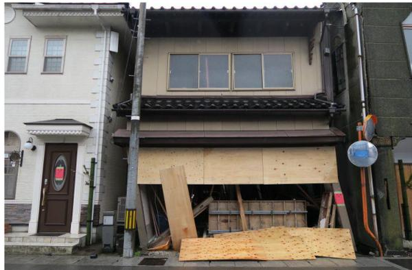
写真5.2.2-81 大きく傾斜した木造店舗併用住宅
