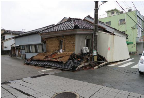
写真5.2.2-80 倒壊した木造住宅
