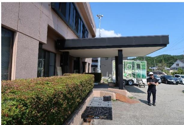
写真 5.3.2-157 建物入口ポーチ部の柱の傾斜
