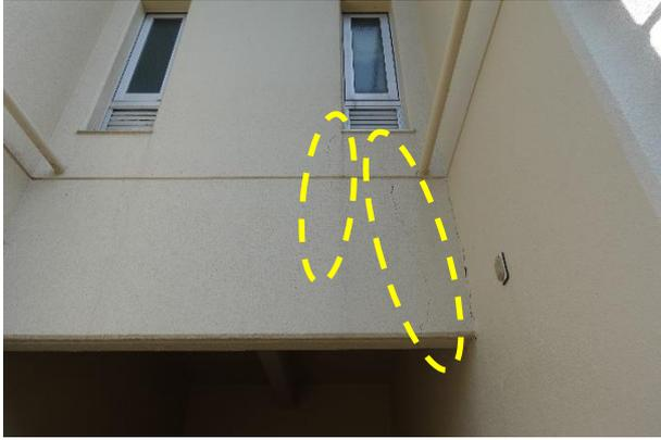
写真 5. 3. 2-58 西側階段室上部のひび割れ
