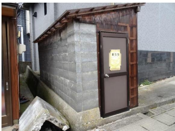
写真 5.3.2-92 建築物 L-2 の傾斜
