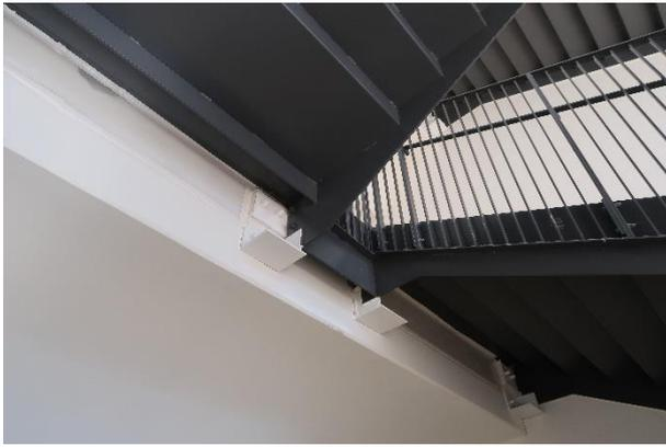
写真 5.3.2-118 建築物 O-1 鉄骨階段の接合部
