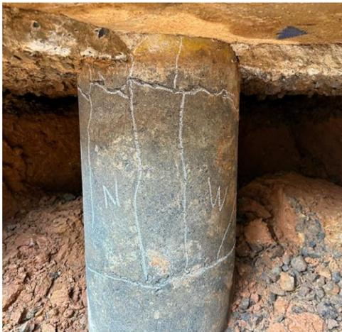
写真 5.3.2-122 杭の損傷状況 (③)
