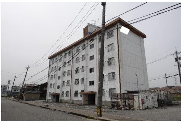
写真 5.3.2-136 建築物 AC-1 外観および塔屋の傾斜
