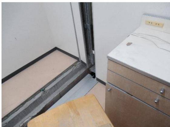
写真 5.3.2-3 Exp. J.の損傷②
