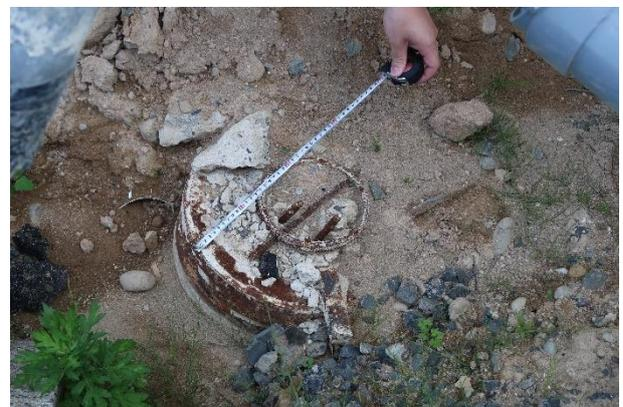
写真 5.3.2-55 露出した杭頭部断面
