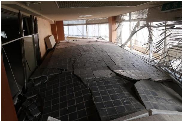
写真 5. 3. 2-133 Y1~Y2 構面 1 階床の膨れ上がり
