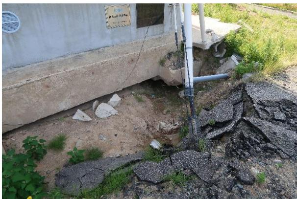
写真 5.3.2-54 南西端部の杭頭部露出
