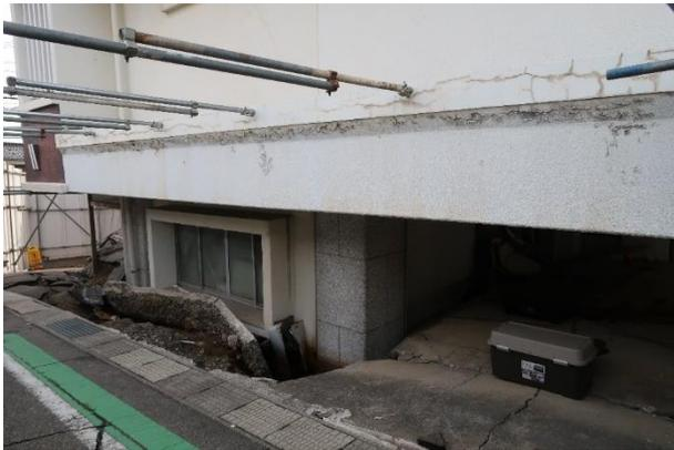
写真 5. 3. 2-131 X4 構面 1 階部分の沈下
