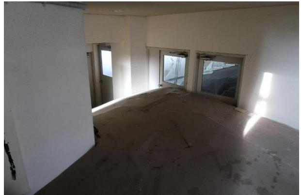
写真 5. 3. 2-134 Y2~Y3 構面 1 階床の膨れ上がり
