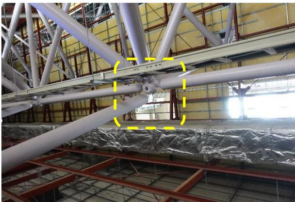
写真 5.3.2-102 システムトラス屋根のポールジョイント部での破断
