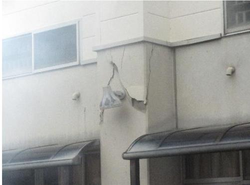
写真 5.3.2-121 2階S柱—RC梁接合部の被害
