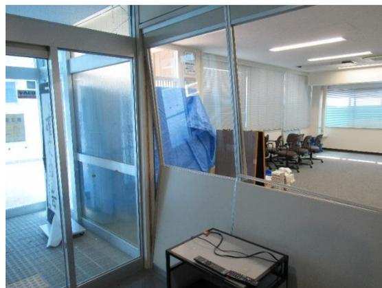
写真 5.3.2-4 間仕切りの損傷
