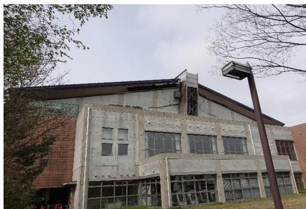
写真 5.3.2-97 妻構面の RC 造壁の面外破壊②
