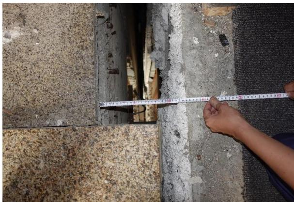
写真 5.3.2-169 7 階の西側棟及び東側棟の離間
