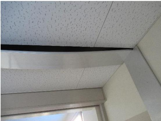
写真 5.3.2-109 Exp. J. の損傷
