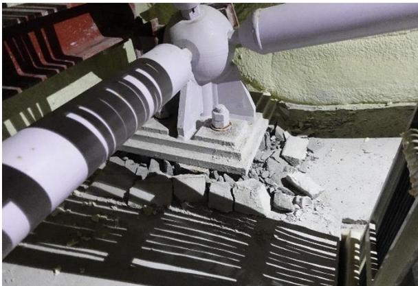
写真 5.3.2-100 屋根支承部のモルタルの損傷
