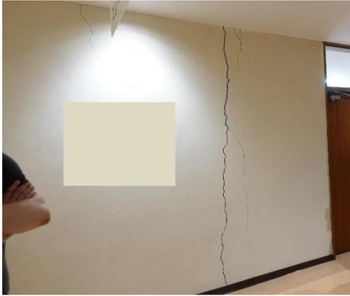
写真 5.3.2-68 壁の縦ひび割れ
