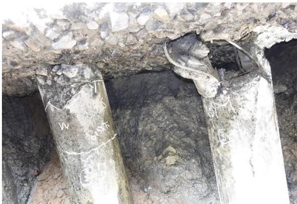
写真 5.3.2-8 杭 No.③の損傷状況
