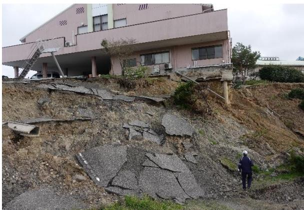
写真 5.3.2-196 杭頭及びパイルキャップの露出
