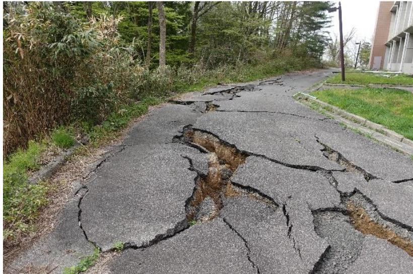
写真 5.3.2-193 建築物 M-1、M-2 周辺の地盤変状
