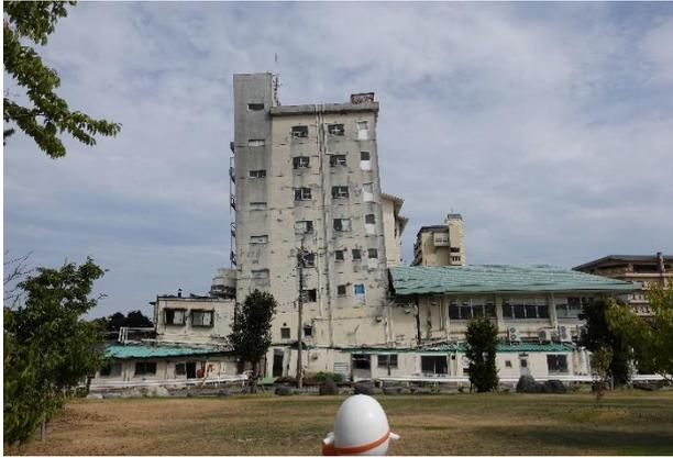
写真 5.3.2-165 西側棟の傾斜
