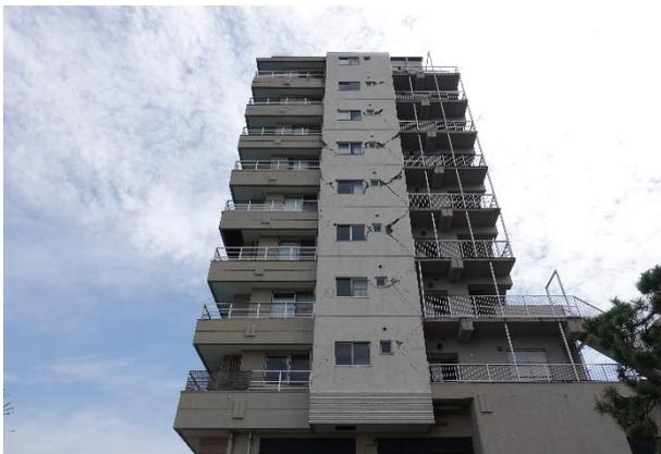
写真 5.3.2-161 AI-2 棟 方立壁のせん断破壊
