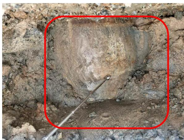
写真 5.3.2-174 未損傷の杭頭部
