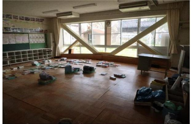
写真 5. 3. 2-17 建築物 B-1 1階床の膨れ上がり
