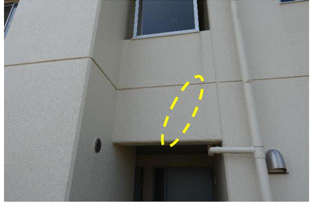
写真 5. 3. 2-59 西側階段室上部のひび割れ
