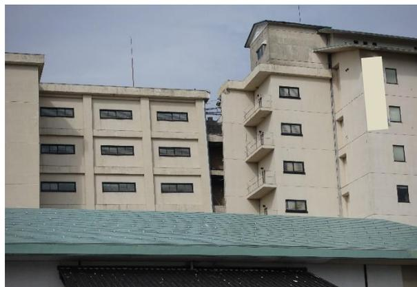
写真 5.3.2-164 西側棟の傾斜による Exp.J.の被害
