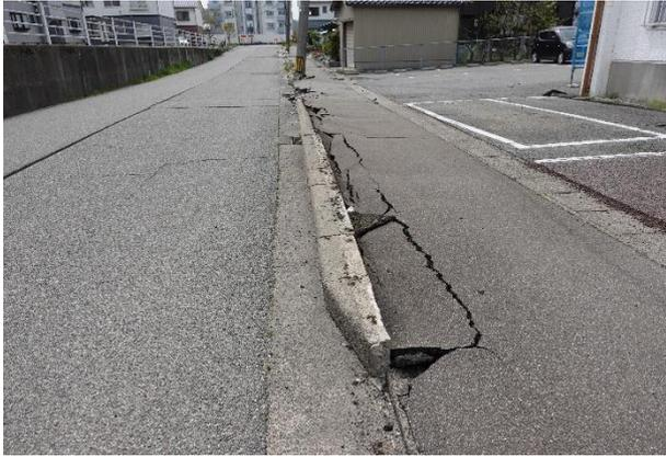
写真 5.3.2-138 建築物 AC-1 東側の地盤変状
