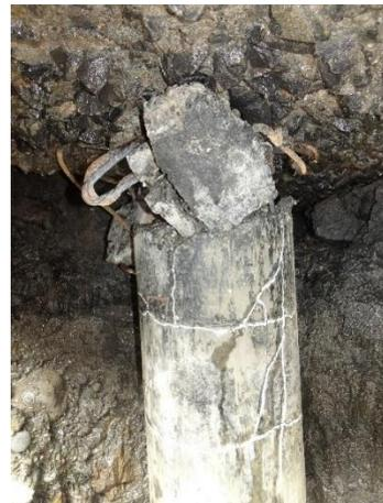
写真 5.3.2-9 杭 No.④-1 の損傷状況
