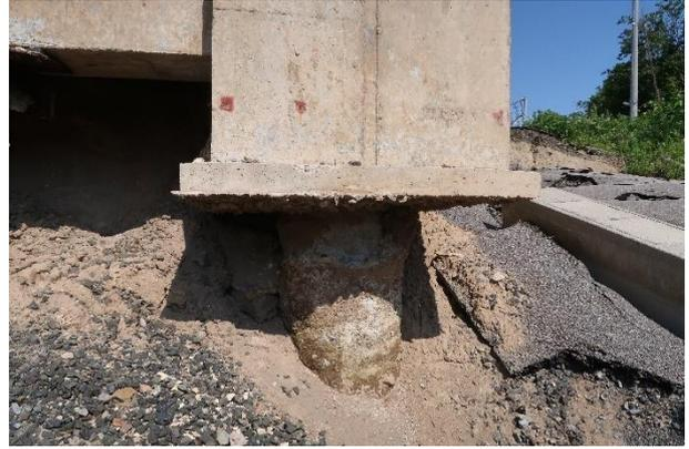
写真 5.3.2-111 建築物 O-3 南西角の基礎露出
