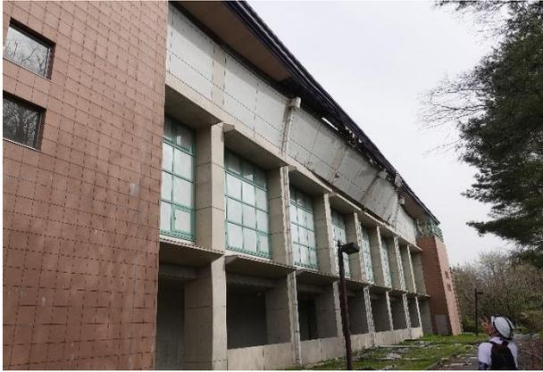
写真 5.3.2-98 平構面の RC 造壁の面外破壊
