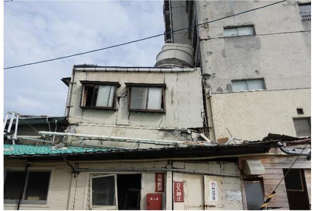
写真 5.3.2-166 西側棟の傾斜による北側 2 階建て建築物の被害
