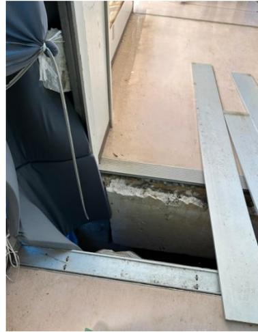
写真 5.3.2-120 Exp. J.の損傷
