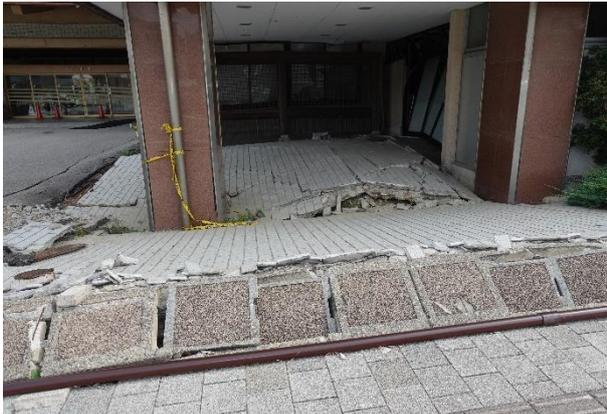
写真 5.3.2-159 AI-1 棟南側の地盤変状
