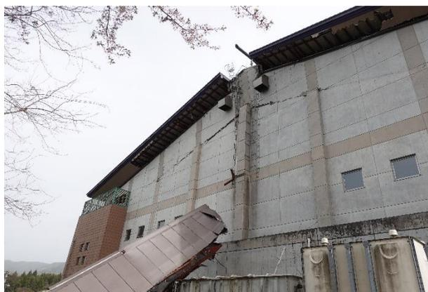
写真 5.3.2-96 妻構面の RC 造壁の面外破壊①
