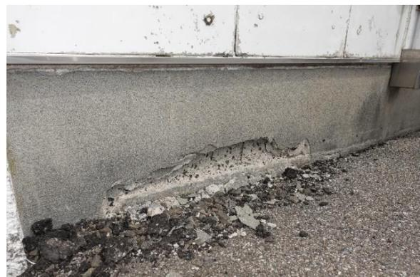
写真 5.3.2-137 上部構造基部のコンクリートの剥落（建築物 AC-1）
