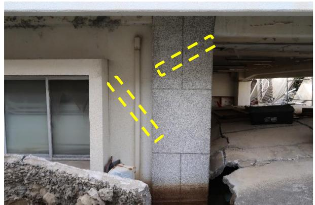
写真 5. 3. 2-132 X4-Y3 柱の損傷
