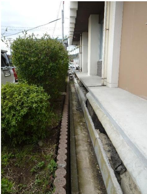
写真 5.3.2-46 建築物外周部の地盤変状
