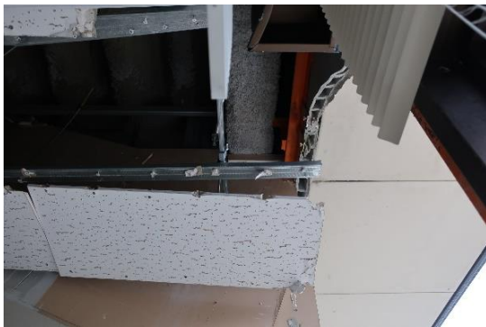
写真 5.6.2.(3)-11 校舎の張間方向の外壁の内観見上げ (AN-101 : 穴水町、教育施設)
