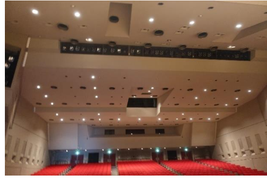
写真 5.6.2.(1)-18 内観 ※天井被害なし （NA-102：七尾市、音楽等用ホール）
