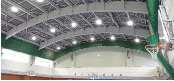
写真 5.6.2.(1)-17 内観 ※2007年～現在までに改修（天井の撤去）がされた例。天井被害なし （建築物E：金沢市、運動施設）
