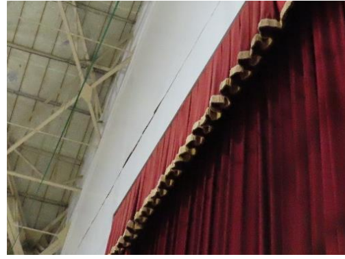
写真 5.6.2.(2)-6 屋内運動場 プロセニウムアーチのパネル目地の浮き (WA-103 : 輪島市、教育施設)
