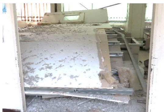
写真 5.6.2.(2)-13 校舎 3階間仕切壁の被害（上ランナごと脱落して転倒） (WA-111：輪島市、教育施設)
