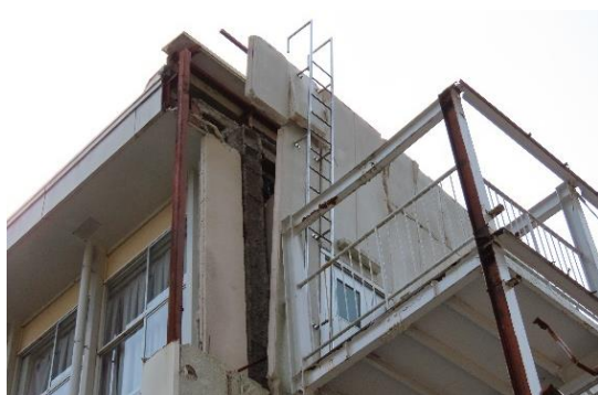
写真 5.6.2.(3)-3 校舎の鉄骨屋外階段付近の ALC パネルによる外壁の被害 (WA-111：輪島市、教育施設)
