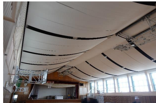
写真 5.6.2.(1)-20 屋内運動場の膜天井内観 ※天井被害なし （NO-102：能登町、教育施設）
