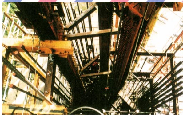
▲ コンクリート打設前の四隅の巨大な柱 全景 ▶ ▼ 四隅の巨大な柱
