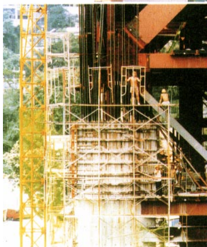
▲ コンクリート打設前の四隅の巨大な柱 全景 ▶ ▼ 四隅の巨大な柱
